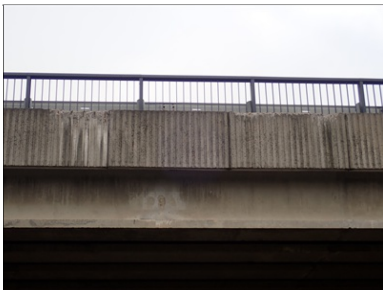
Degradace římsovek vlevo
