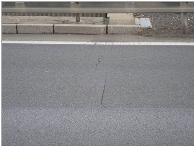
Trhliny ve vozovce nad 1. opěrou vpravo
