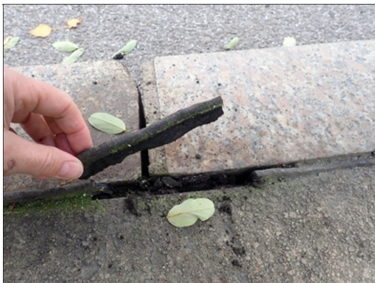
Zálivka mezi obrubníkem a římsou
