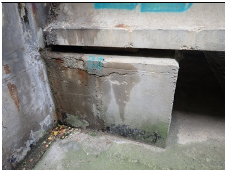
Úložný práh u 1. opěry vpravo
