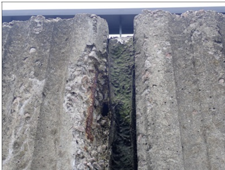
Dilatace v římse nad 1. opěrou vlevo
