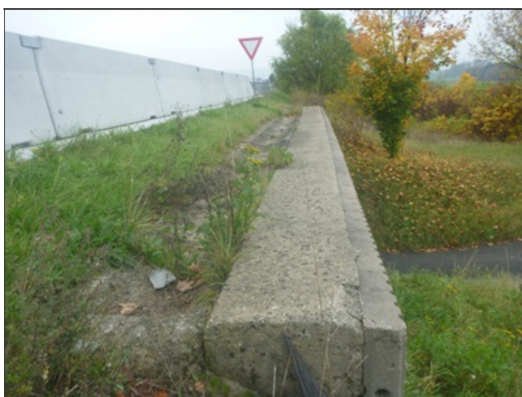
Římsa a odvodňovací žlab vpravo
