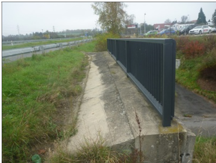
Pohled na římsu a odvodňovací žlab vlevo
