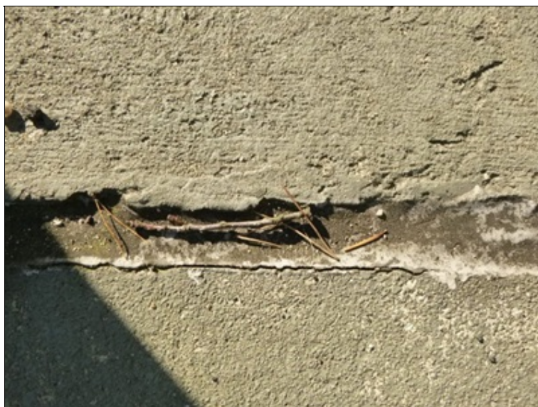
Dilatační spára v chodníku.
