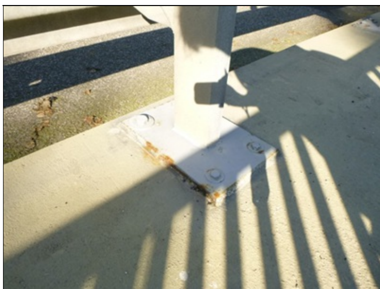
Patní desky svodidlového zábradlí
