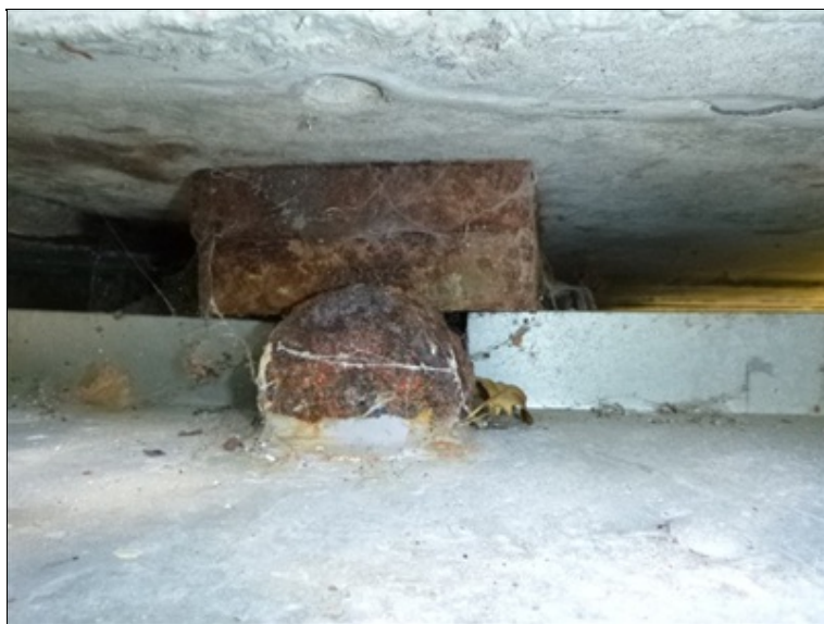
Krajní ložisko vpravo opěra 01
