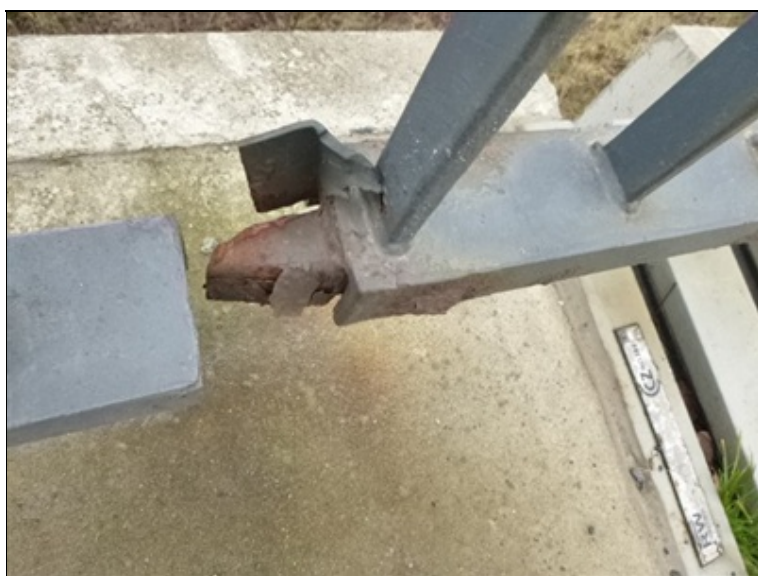
pole zábradlí nad mostním závěrem opěra 02
