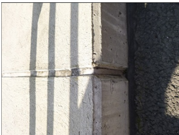
Dilatace v římse vlevo
