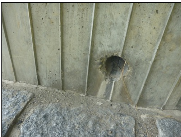
Nedostatečné vyústění v 2.OP
