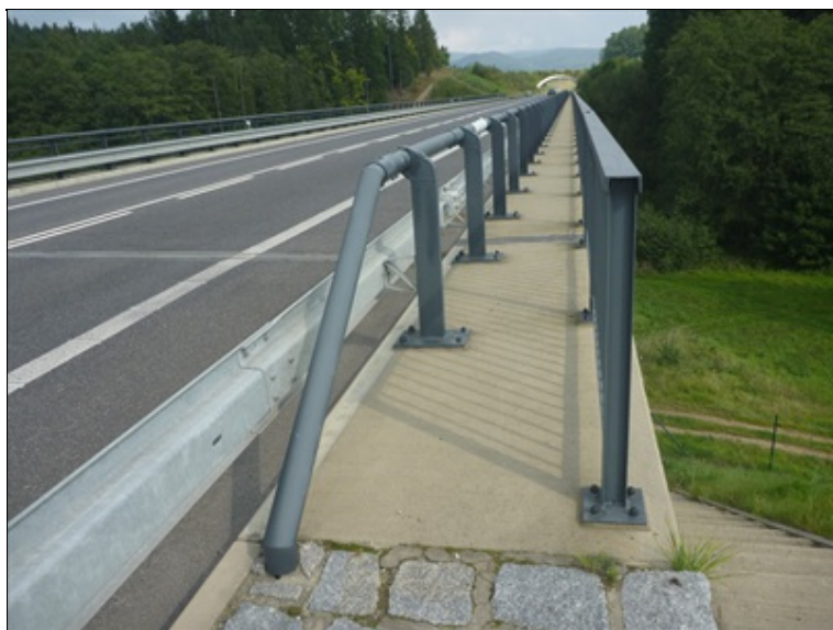
Ukončení horního madla svodidlového zábradlí
