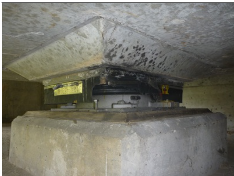
Ložisko na 2.OP s poškozenou ochrannou plentou
