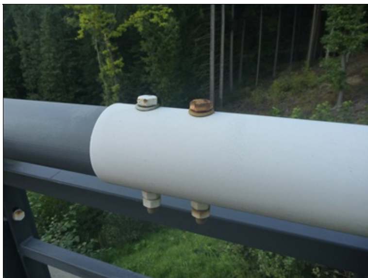
Lokální koroze spojovacího materiálu svodidlového zábradlí
