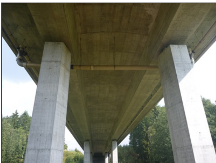
Podhled NK a systém odvodnění
