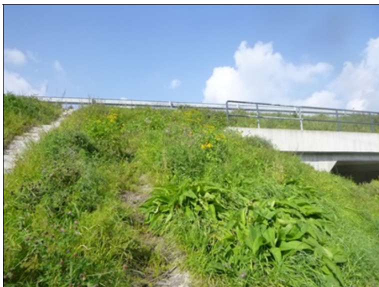
Odvodňovací žlab a revizní schodiště vpravo
