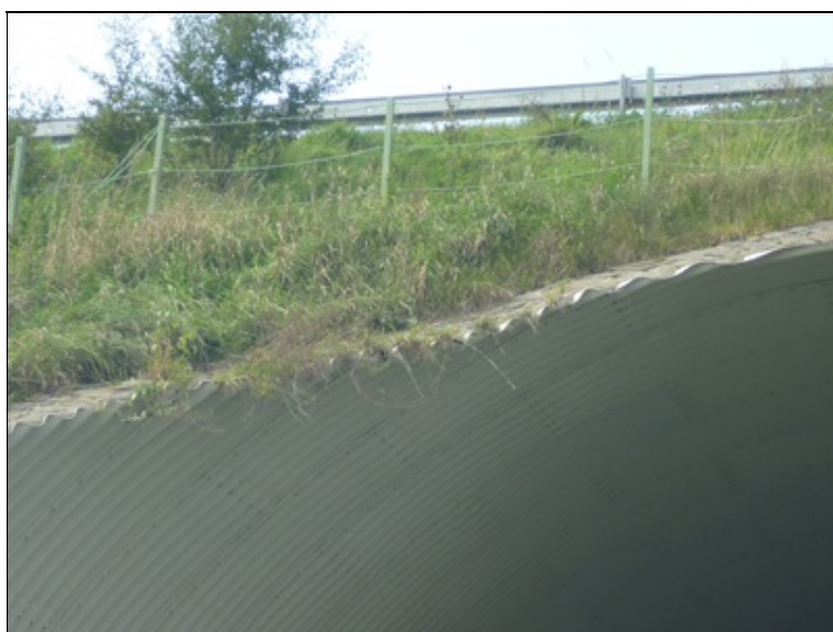
Poškozené zábradlí vpravo a zakořeněná vegetace v kamenném opevnění
