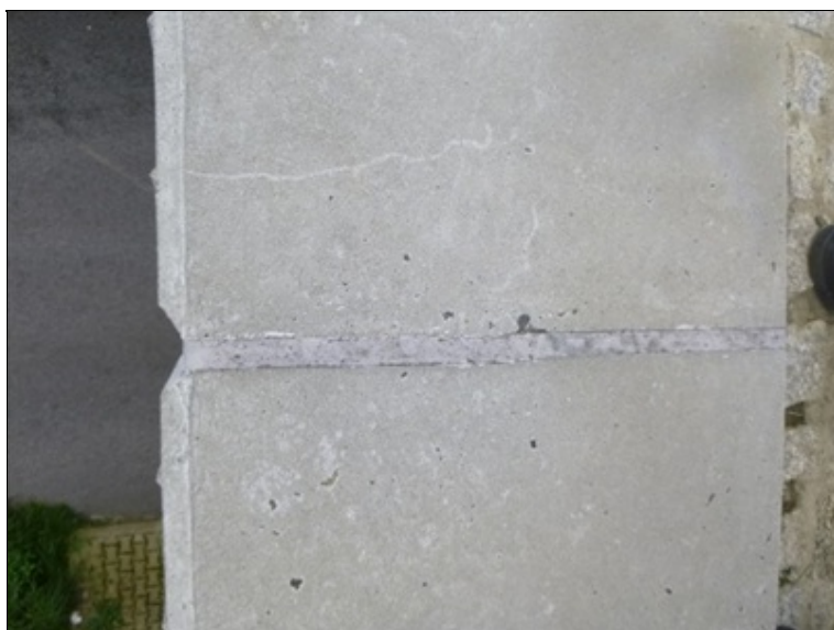
Dilatační spára v římse vlevo
