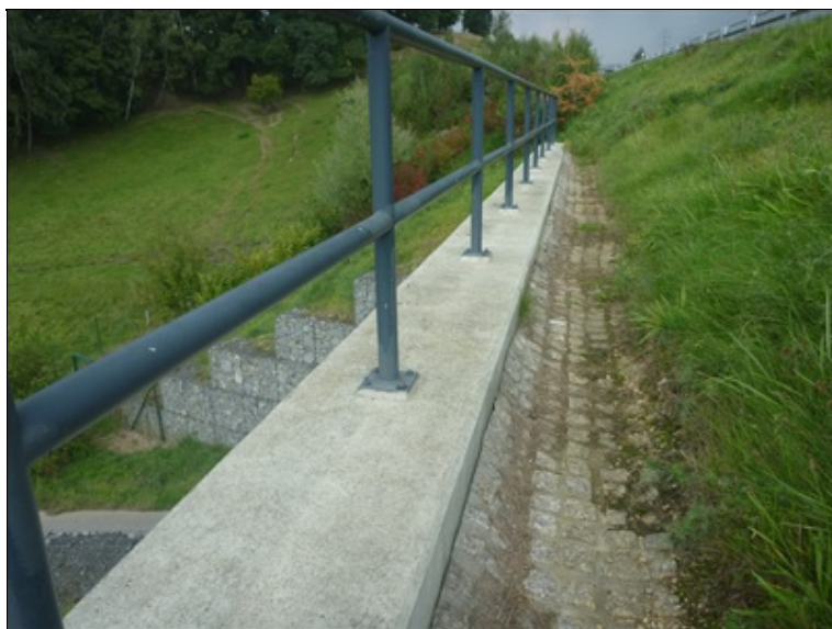
Odvodňovací kamenný žlab za římsou vlevo
