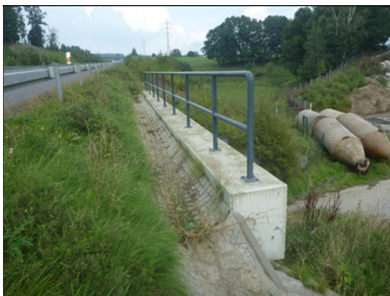
odvodňovací žlab u římsy vpravo
