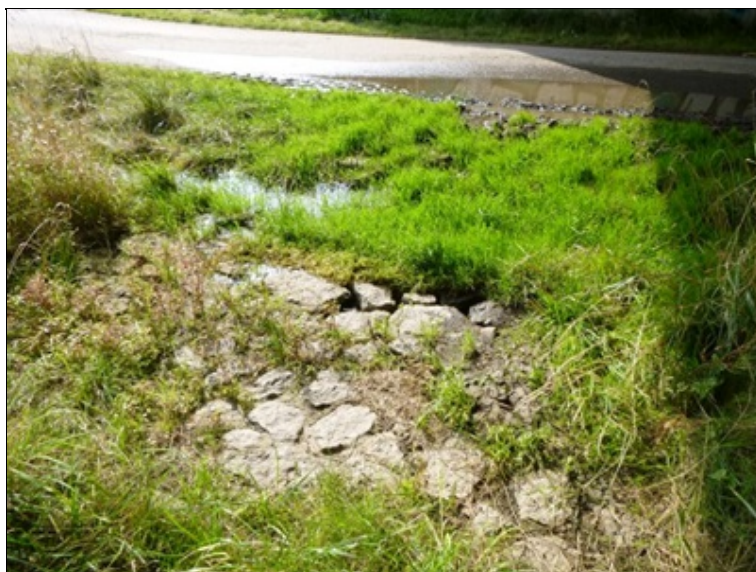
Vývařiště pod odvodněním mostu
