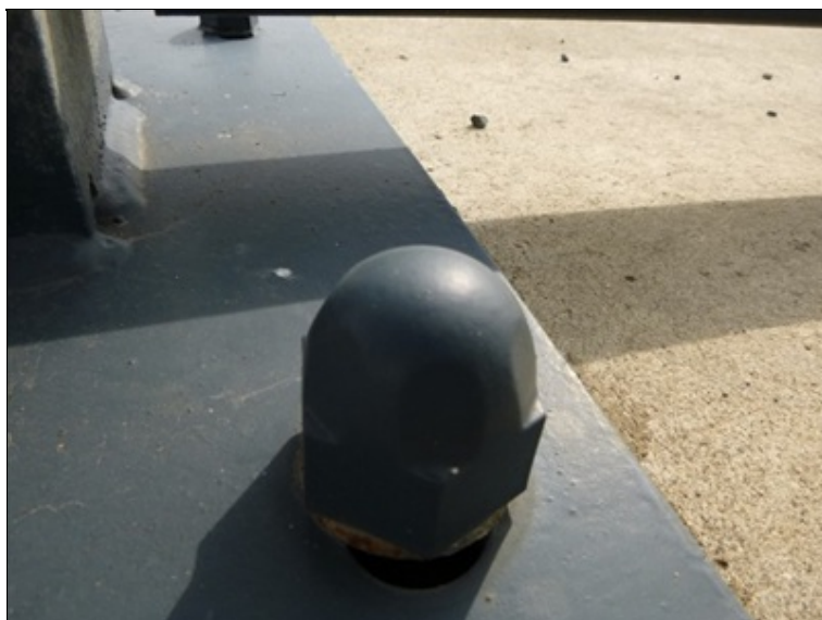
Kotevní deska zábradlí
