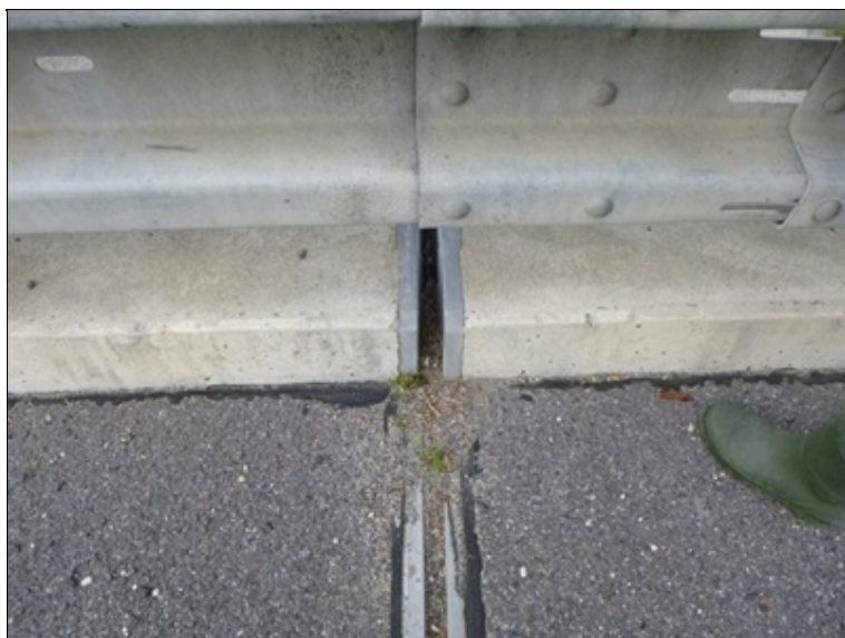
Dilatační závěr nad opěrou 1
