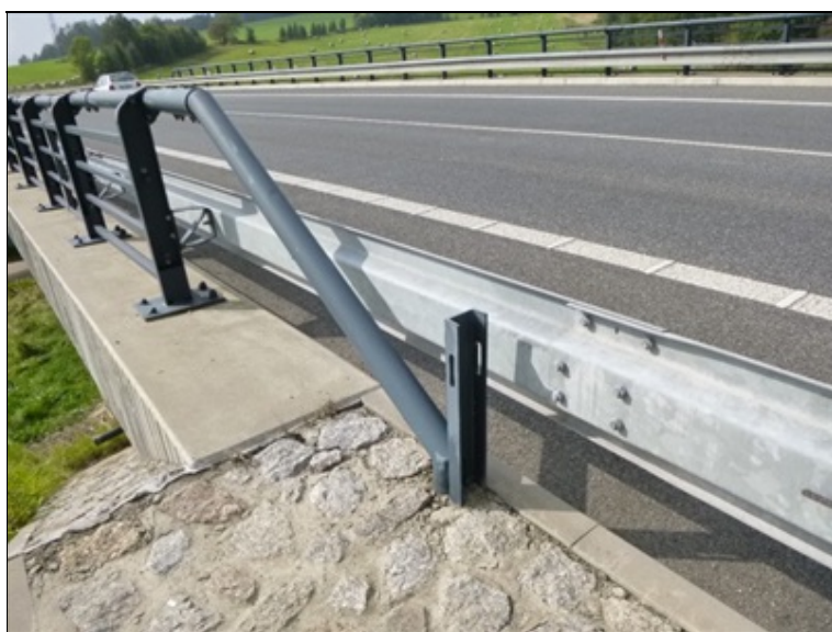
Zakončení zábradelního svodidla
