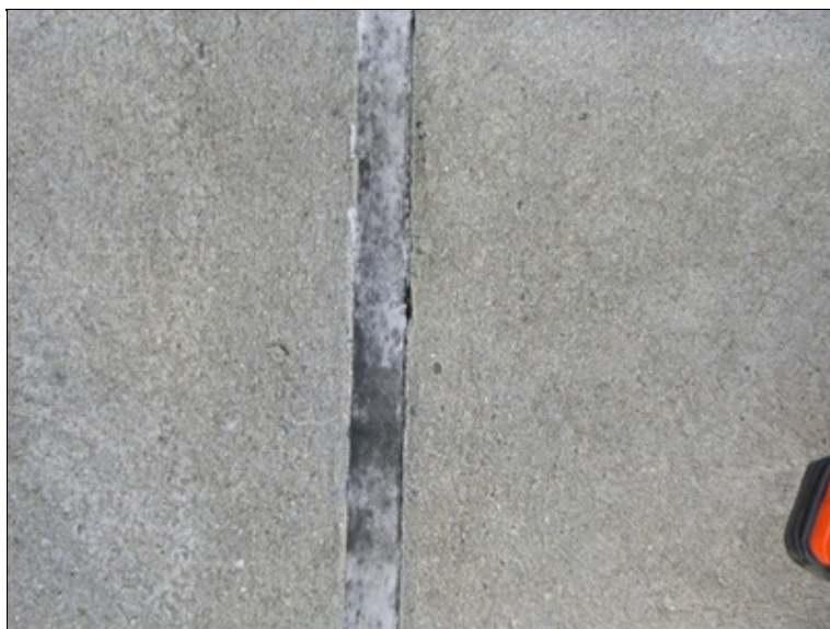
Dilatační spára v římse
