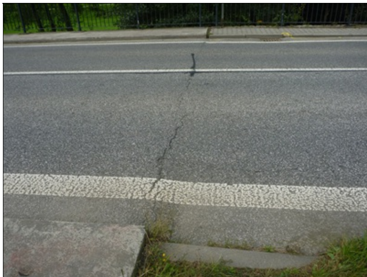
Trhlina nad 2.opěrou
