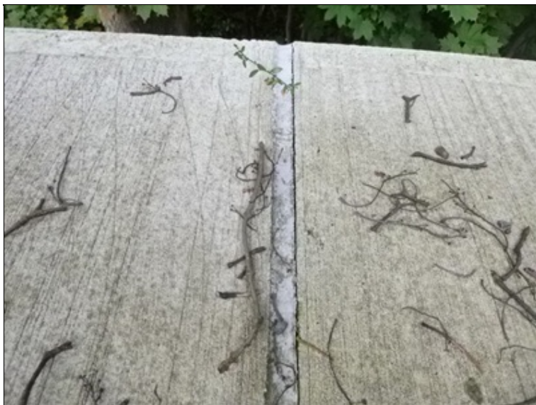
Dilatační spára v římse vlevo
