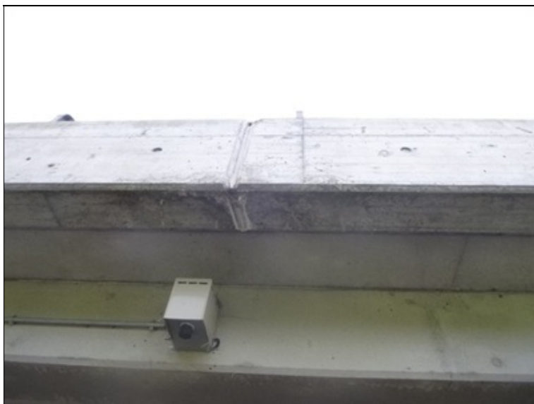
Dilatační spára v levé římse
