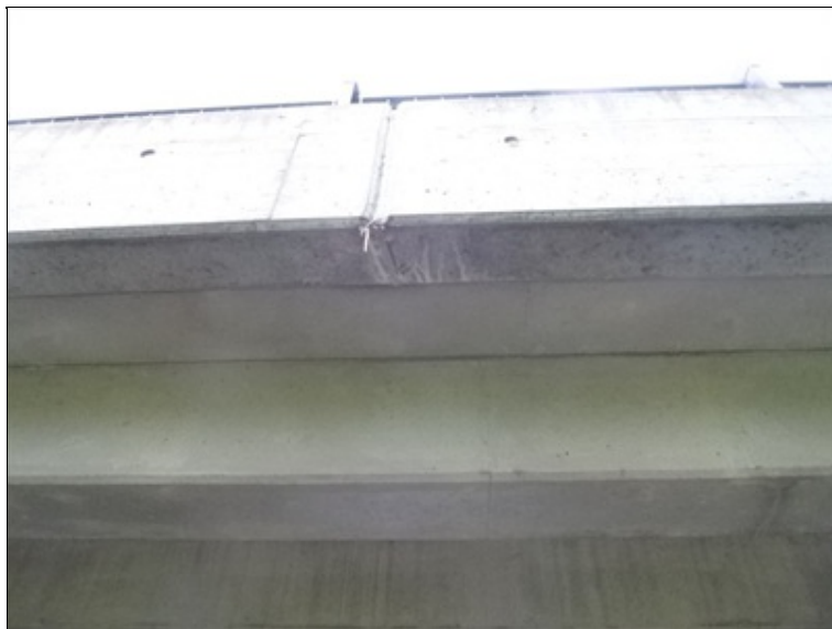
Dilatační spára v pravé římse
