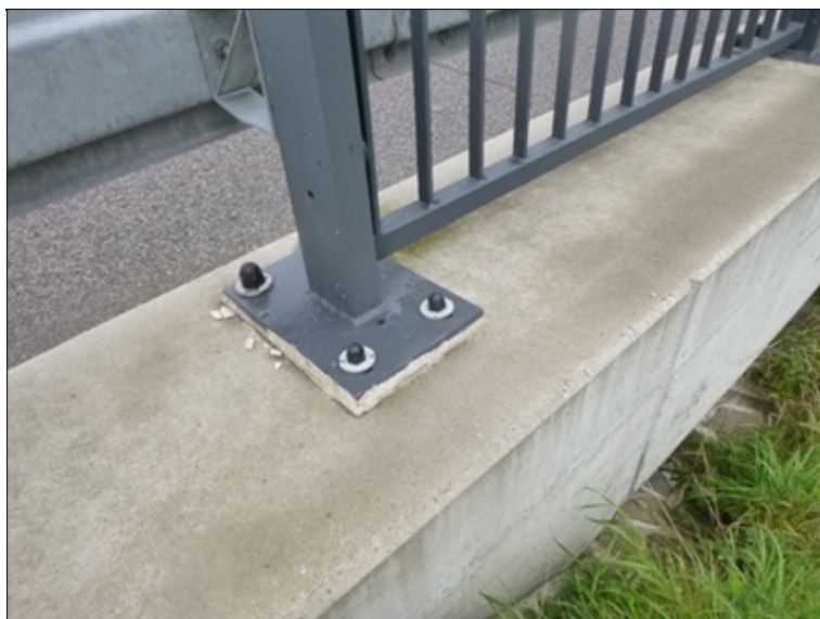
Patní desky zábradlí, pravá římsa
