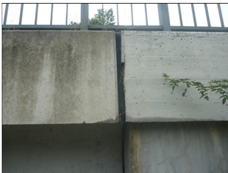
Dilatace v římse na vtoku vpravo
