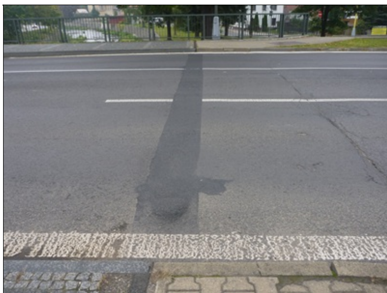
MZ nad pravobřežní opěrou
