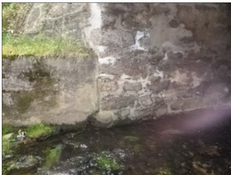
Napojení opěry 2 vlevo na betonovou zídku toku
