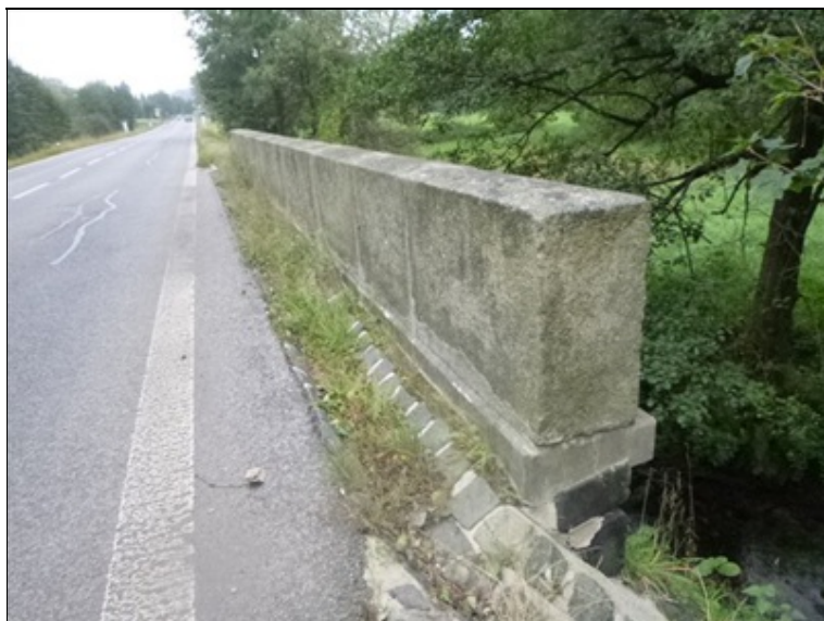
Odvodňovací žlab podél parapetu vpravo
