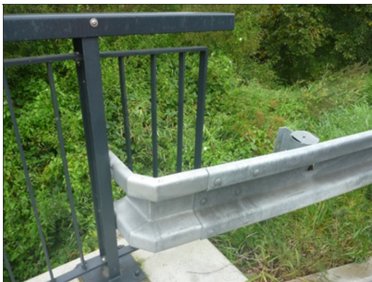
Ocel. svodidlo na výtoku vpravo
