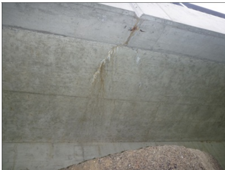
Dilatace výtokové římsy
