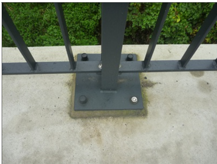
Kotevní deska zábradlí na výtoku
