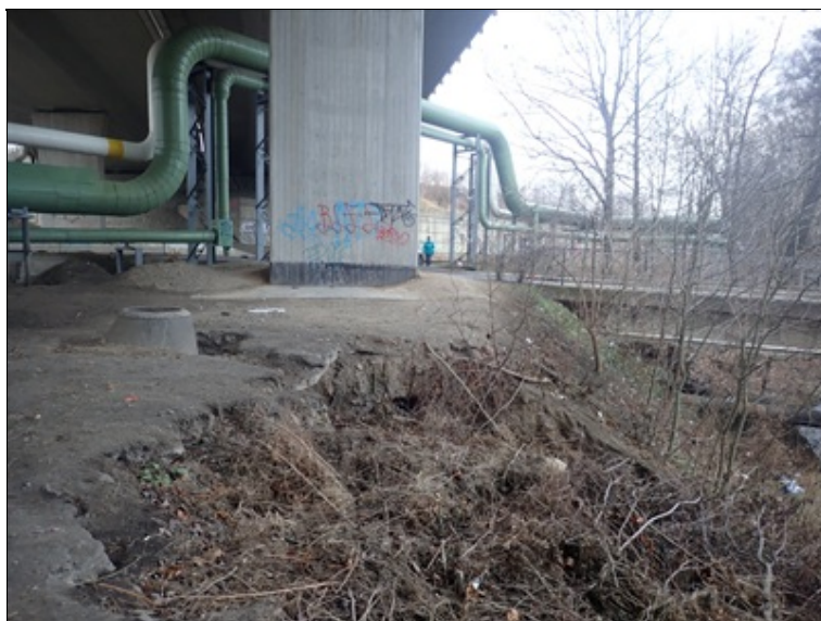
Eroze svahu mezi 2. a 3. pilířem
