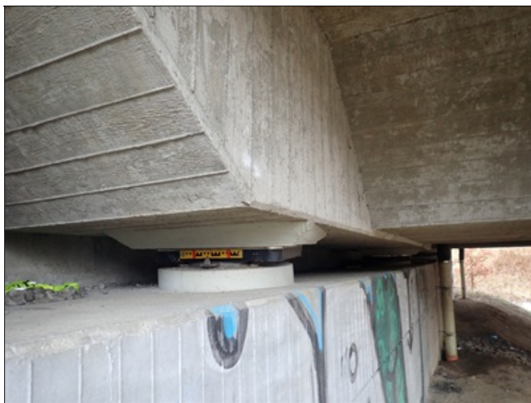
Pohled na 2.OP a nastavení ložiska
