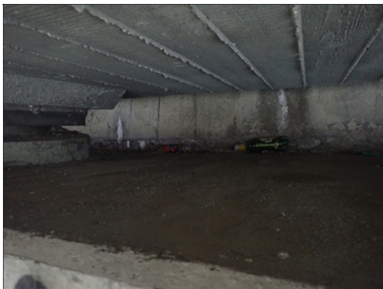
Mokré mapy a vápenné výluhy v 1.závěrné zídce
