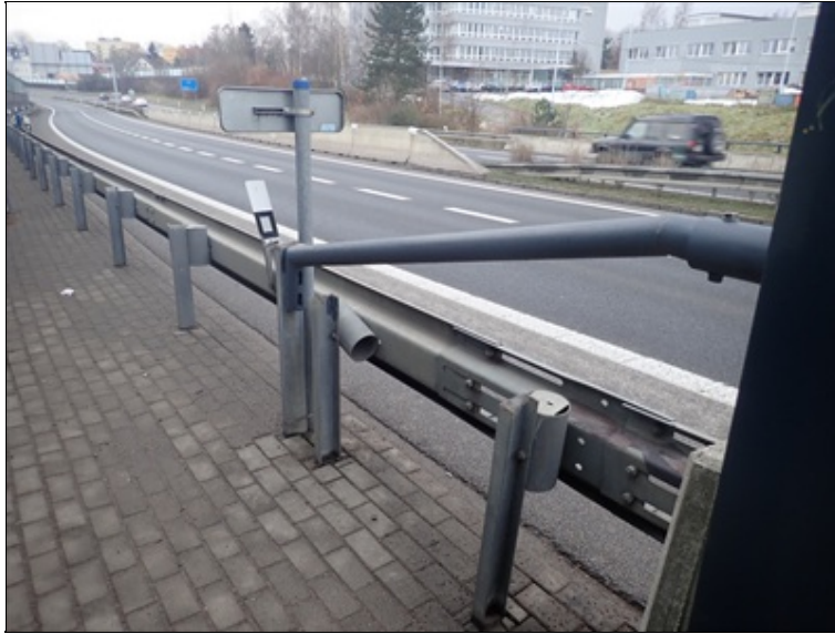
Poškozený deformační kus svodidla
