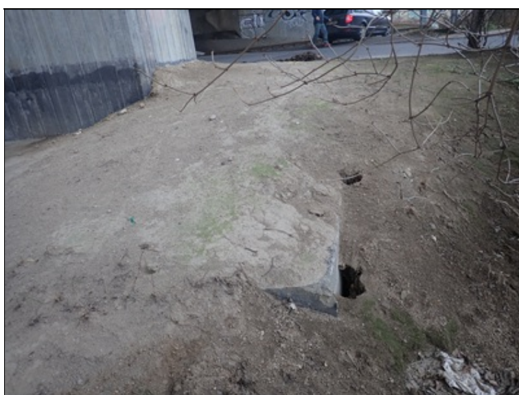
Obnažený základ 2.pilíře s kavernami v zásypu
