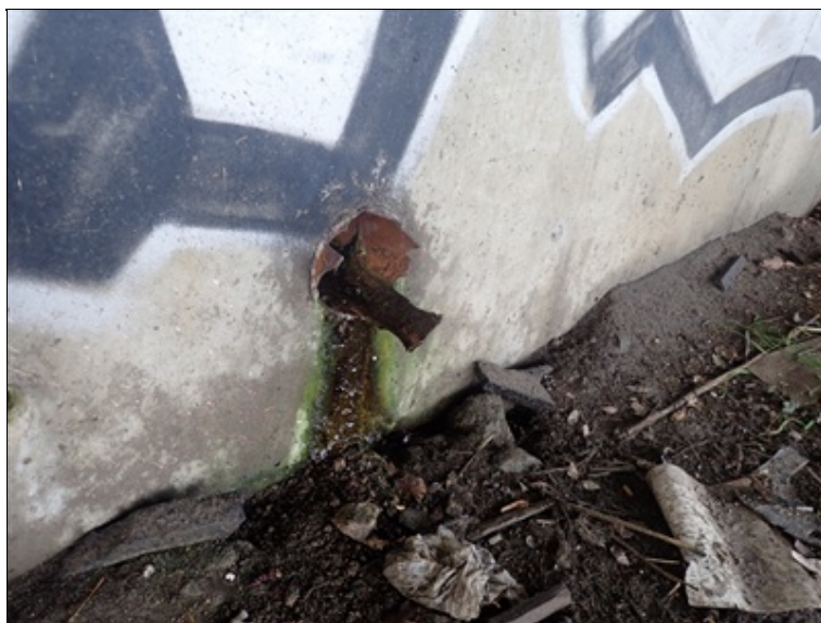
Poškozené vyústění rubové drenáže u 1.křídla vlevo
