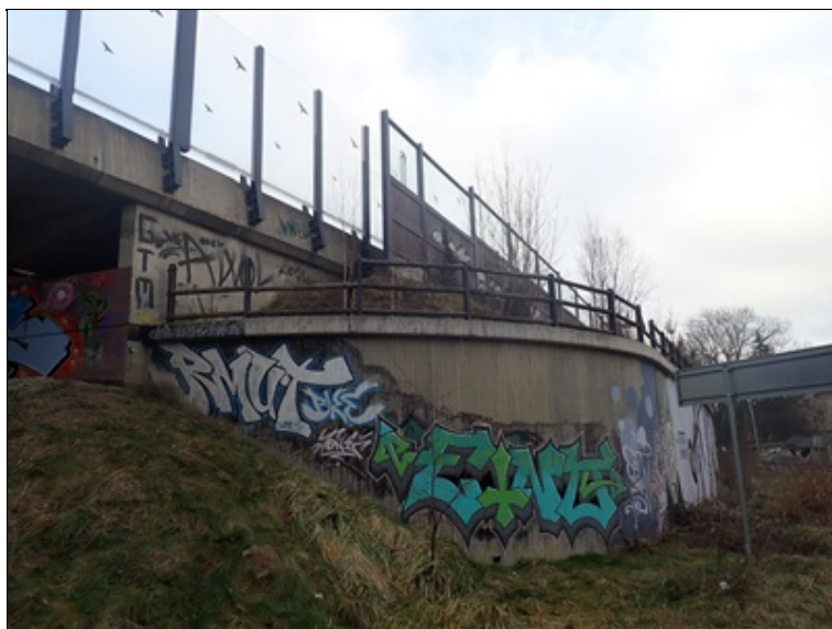
Poškozené zábradlí na 2.křídle vpravo
