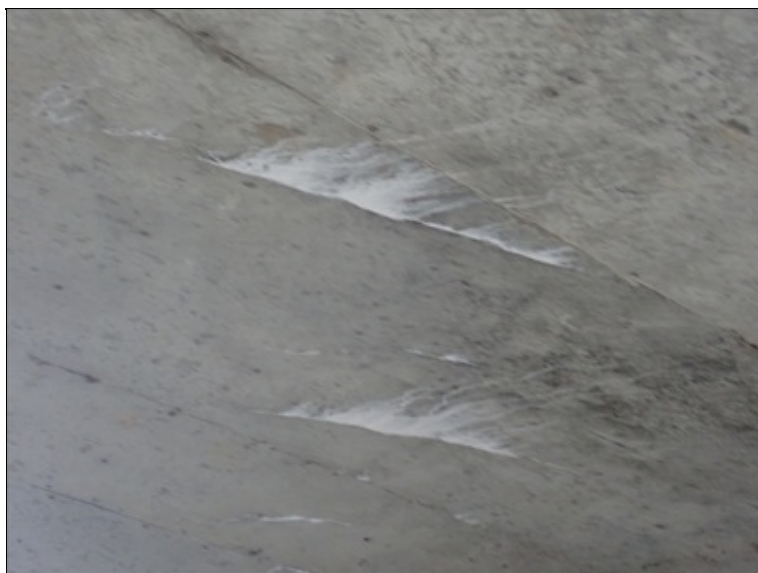
Vlasové trhliny v podhledu NK na vtoku
