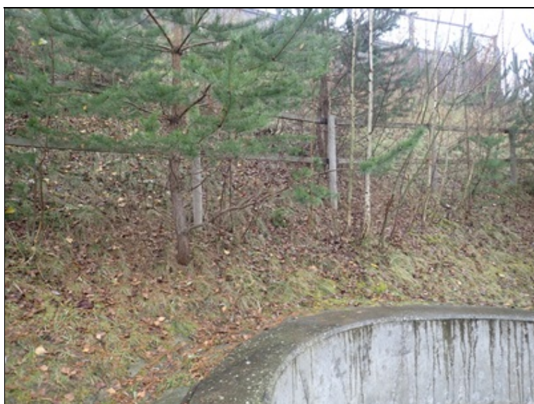
Zakořeněné nálety a stromky v násypovém tělese na výtoku
