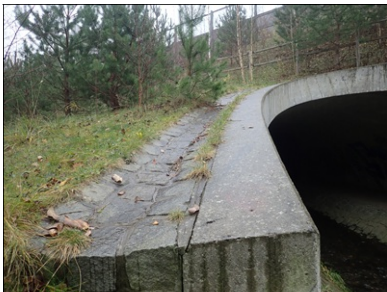
Detail kamenného žlabu podél prstence NK
