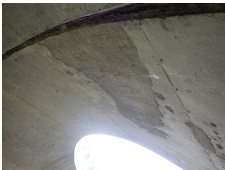
Podhled NK - stopy po opravě na výtoku
