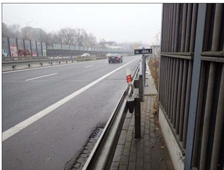
Poškozený deformační kus svodidla na levoběžném předpolí
