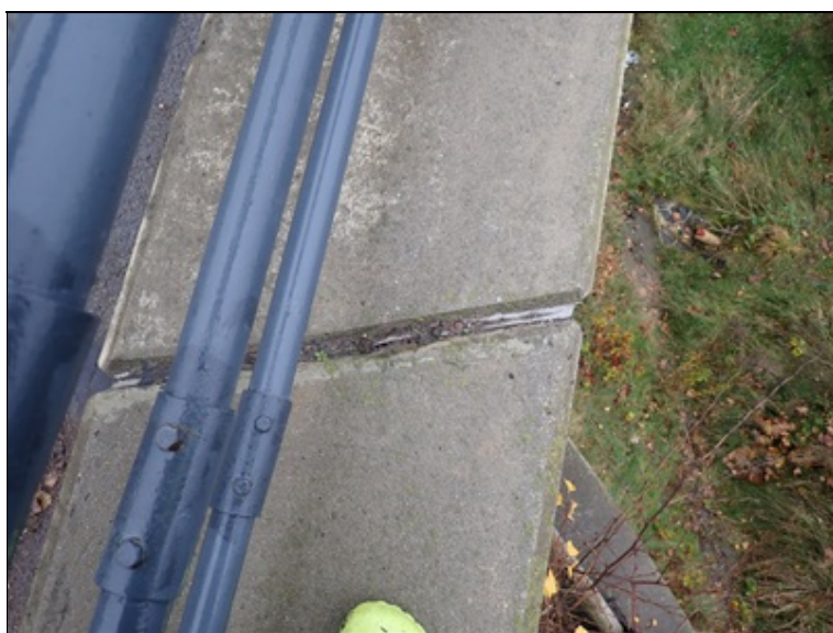
Poškozená dilatace v římse vpravo
