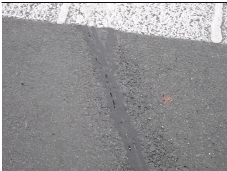
Otevřená spára v místě MZ nad 1. opěrou
