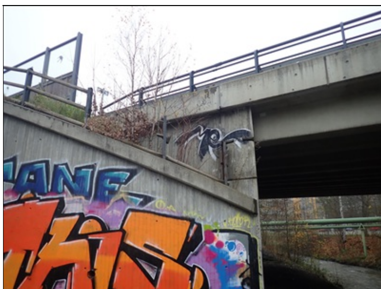
Poškozené zábradlí na 1. křídle vpravo, resp. na vtokovém křídle vlevo
