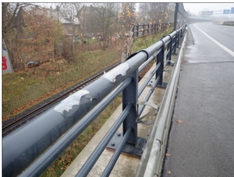
Poškozená PKO zábradelního svodidla vpravo
