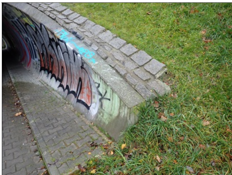
Chybějící kamenný blok v opevnění podél prstence NK vlevo
