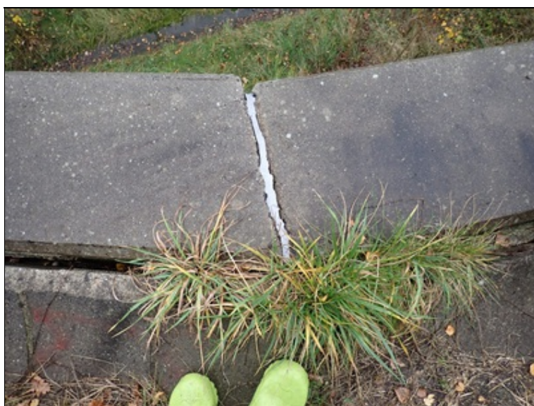
Poškozená dilatace na římse vpravo
