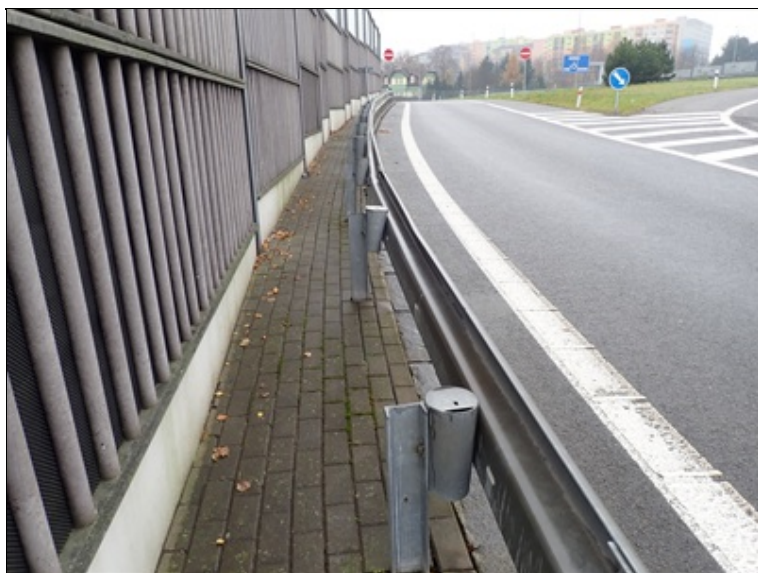
Poškozené svodidlo vpravo
