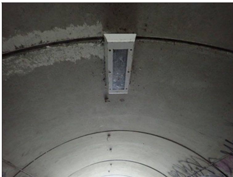
Podhled NK a poškozené osvětlení
