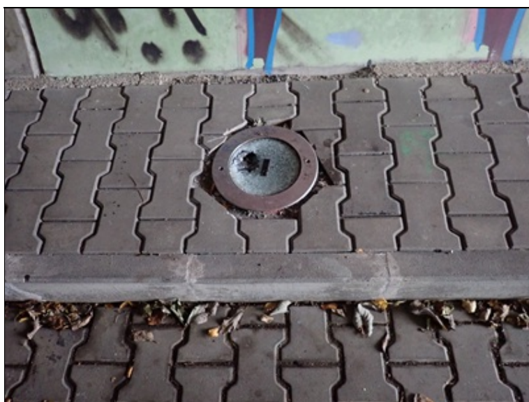
Poškozené osvětlení v chodníku
