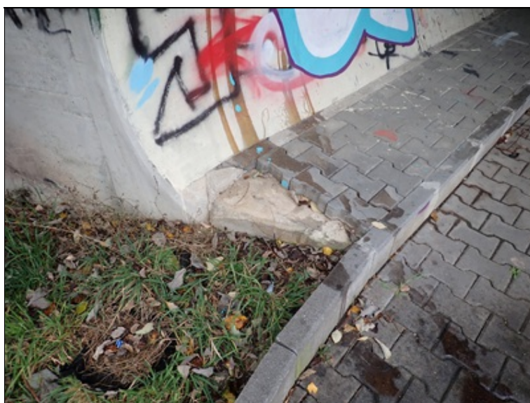
Chybějící zámková dlažba v podchodu vpravo
