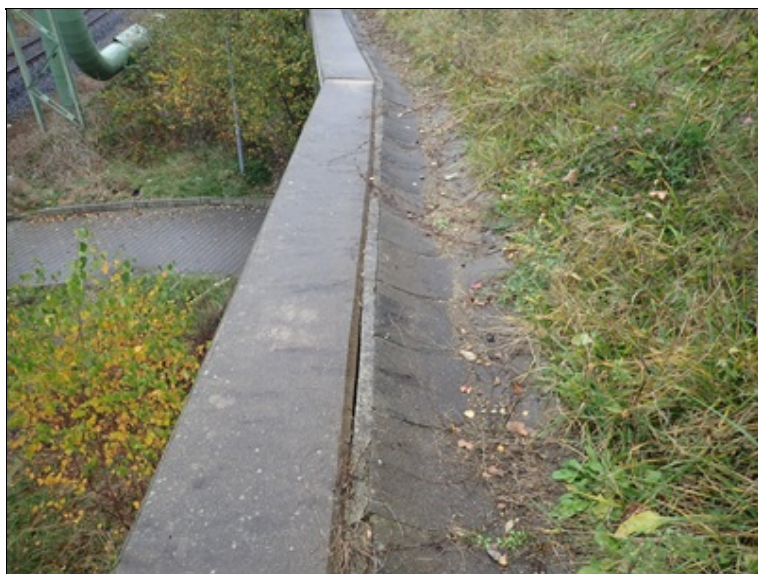
Bet. žlab u římse vpravo
