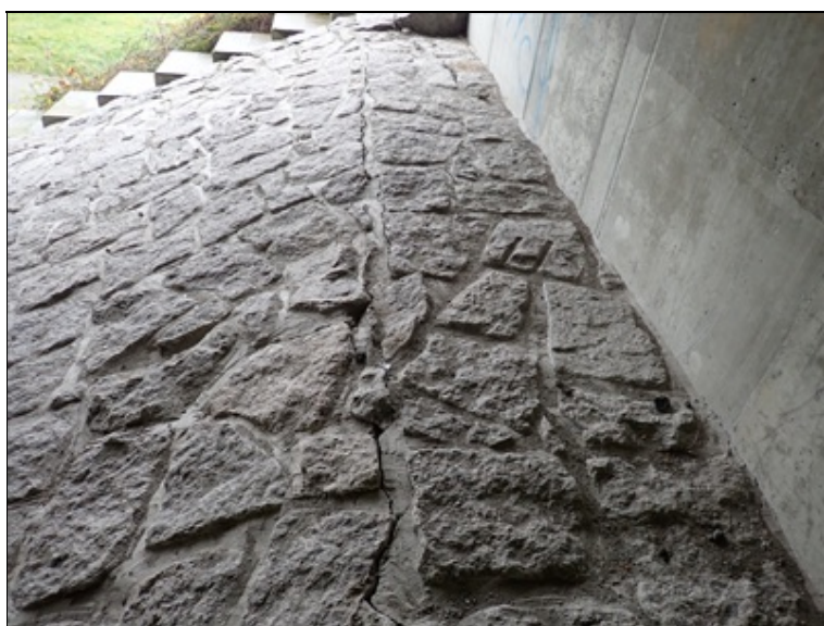
Podélná trhlina v kamenném opevnění u 1. opěry
