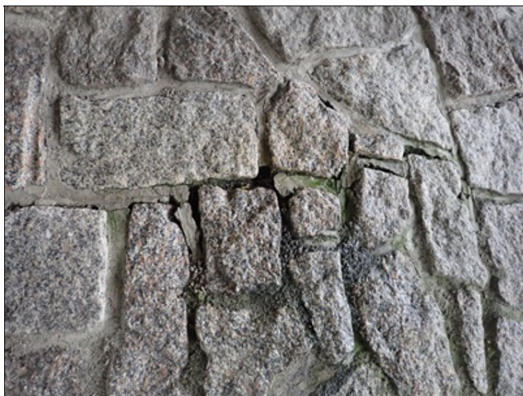
Poškozené spárování kamenné zádlažby pod mostem pod vyústěním odvodňovače izolace
