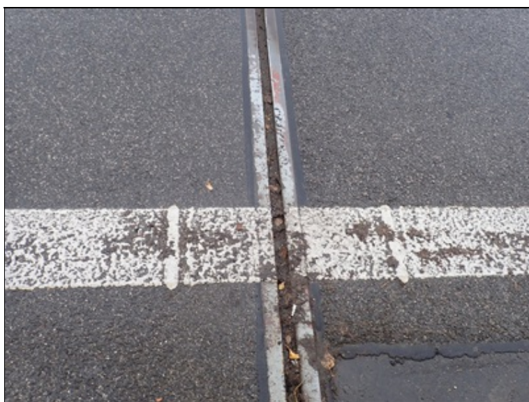
Dilatační závěr nad 2.opěrou
