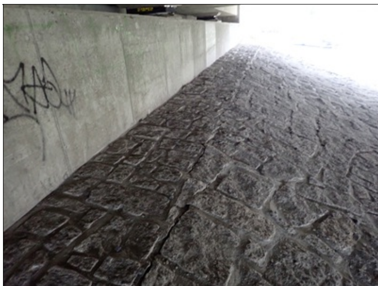
Pohled na 1. opěru a kamennou zádlažbu pod mostem s trhlinou.
