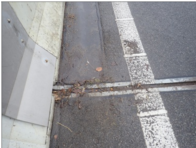
Dilatační závěr nad 1.opěrou
