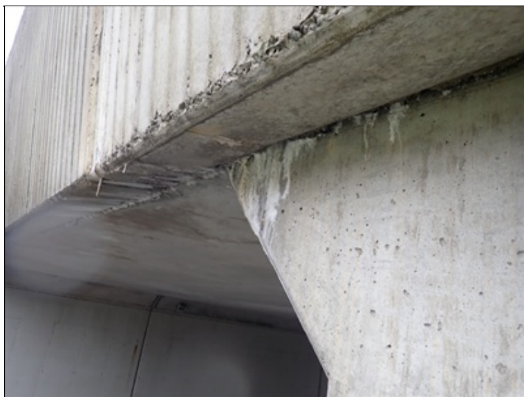
Detail zatékání pod římsou vlevo u 1.opěry
