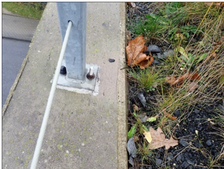
Kotvení zábradelního sloupku na římse vlevo
