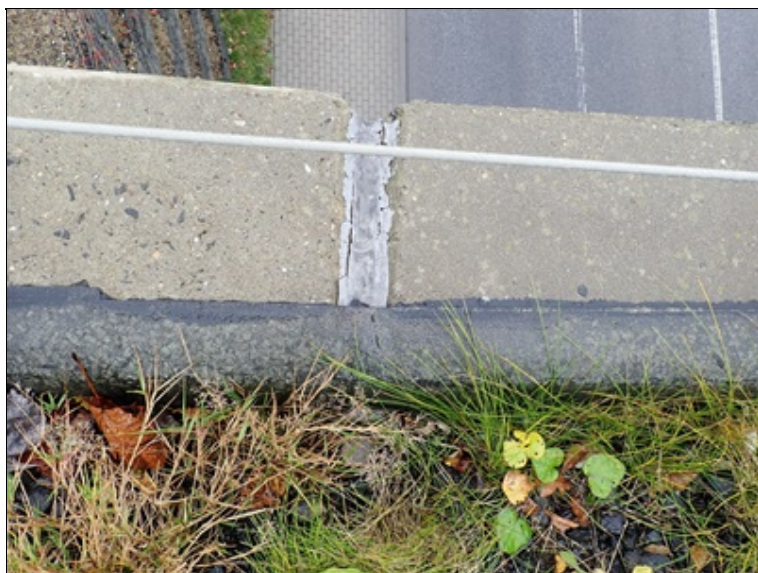
Dilatace římsy vpravo, včetně detailu ukončení izolace
