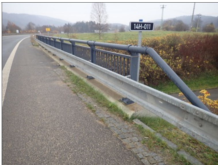
Krajnice a římsa vpravo u 1.opěry
