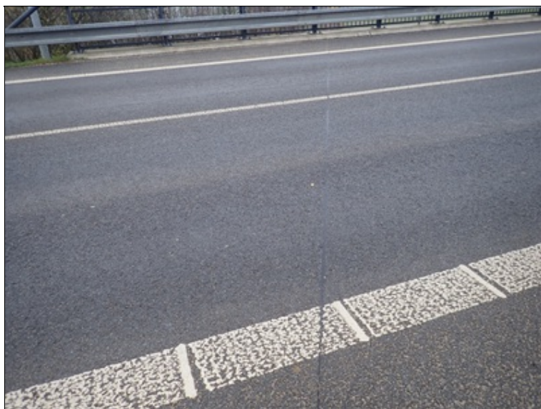
Řezaná spára ve vozovce nad 1.opěrou
