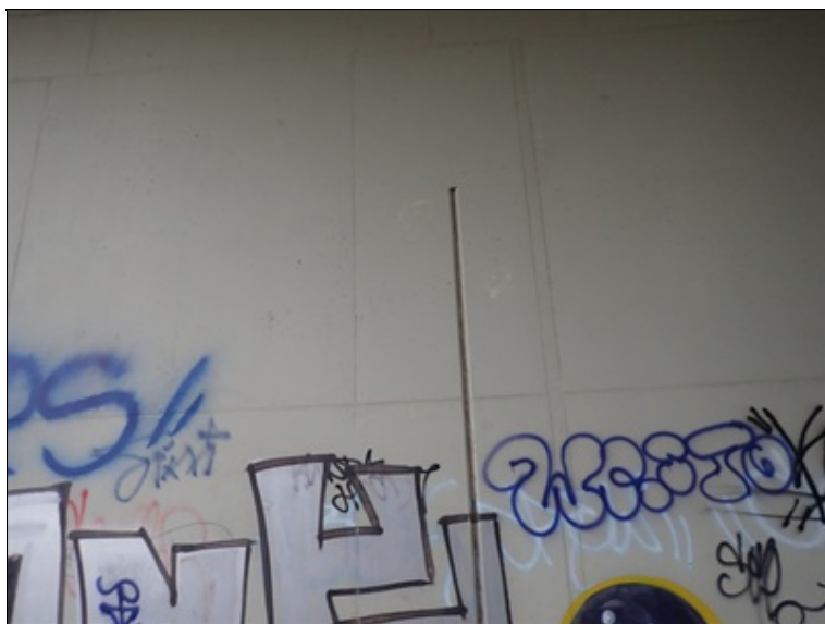
Pracovní spára uprostřed 2.opěry
