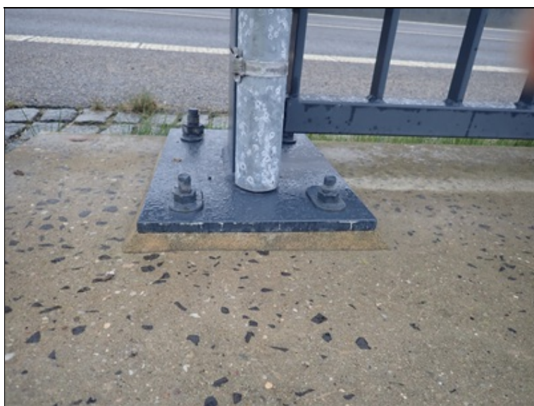
Kotvení zábradelních sloupků
