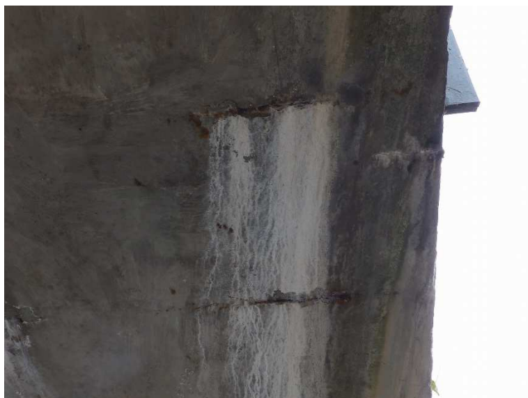
Průsaky s inkrustací na spodním líci.
