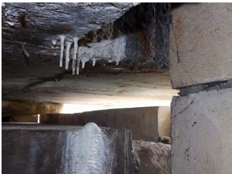
Fotodokumentace dutiny nad klenbou pole 2
