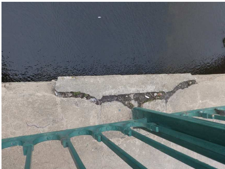
Krajní část betonu u kapsy sloupku zábradlí je odtržena od římsy.
