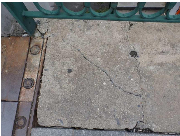
Rozpad římsy u mostního závěru nad OP1.
