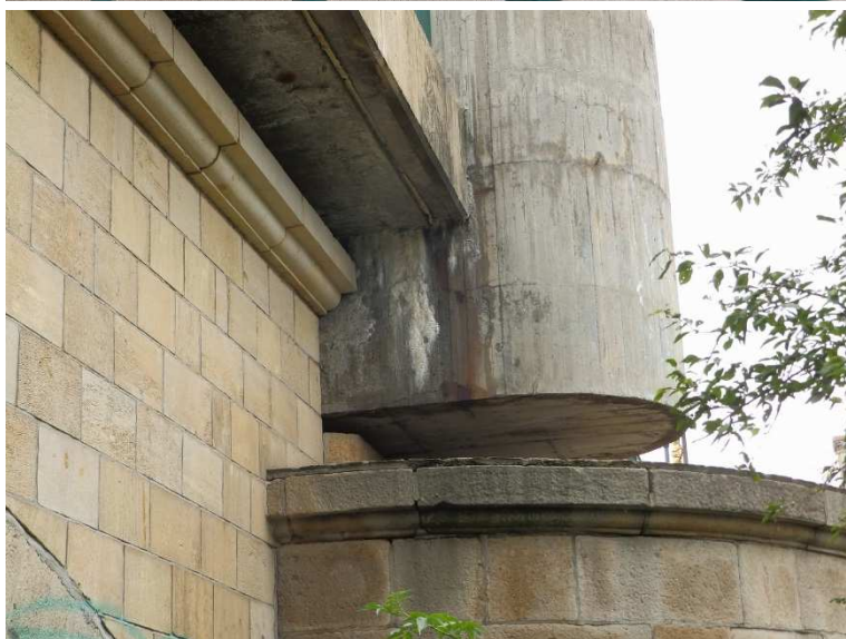
Silné průsaky na líc niky podél římsy.
