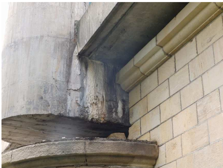
Silné průsaky na líc niky podél římsy.
