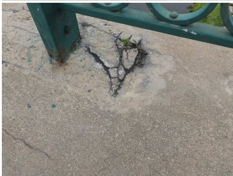
Degradace betonu okolo sloupku zábradlí.
