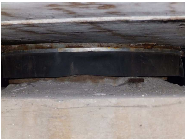
Povrchová koroze ložisek na P2.
