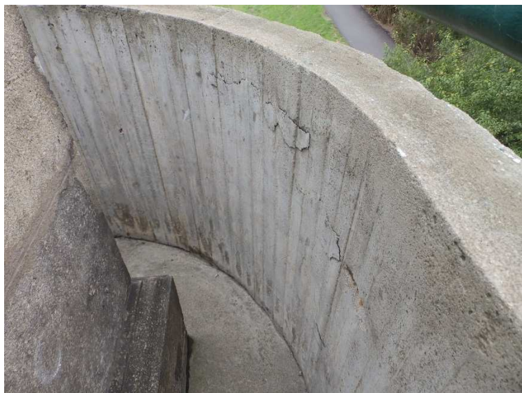
Separace krycí vrstvy na nice za sochou.
