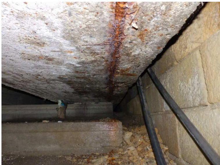
Aktivní průsaky na pravém trámu v 1/2 pole 1. V místě průsaků dochází k degradaci betonu, odhalená výztuž koroduje.
