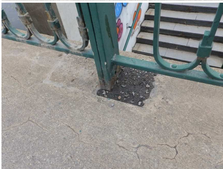
Degradace betonu okolo sloupku zábradlí.
