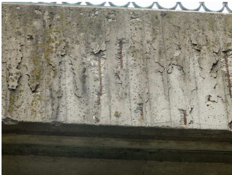
Separace krycí vrstvy na vnějším lici římsy, odhalená výztuž koroduje.
