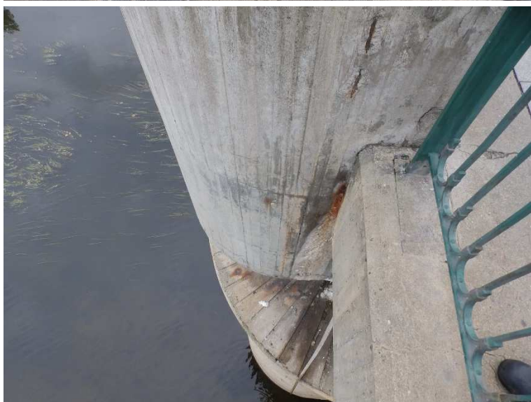
Zatékání na vnější líc niky podél římsy.
