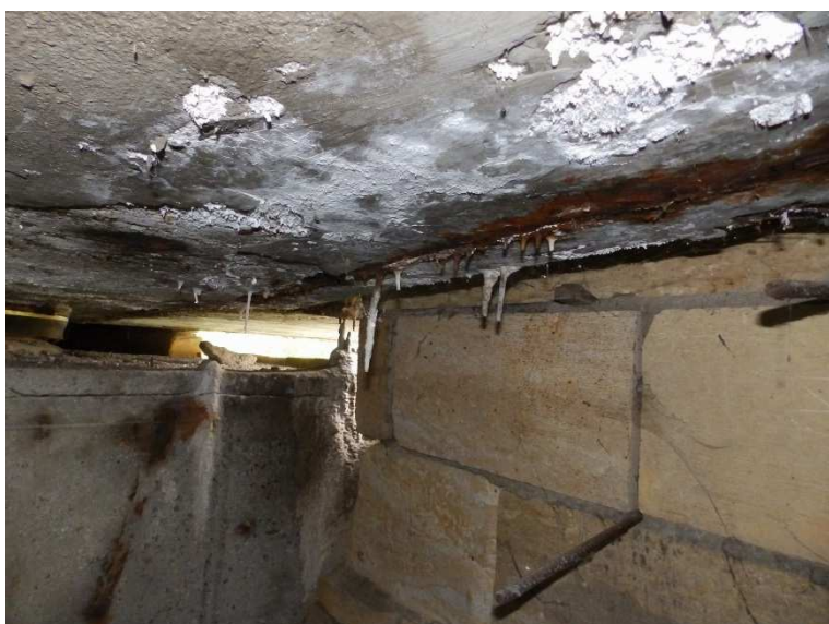
Aktivní průsaky v krajní části u pilíře P3
