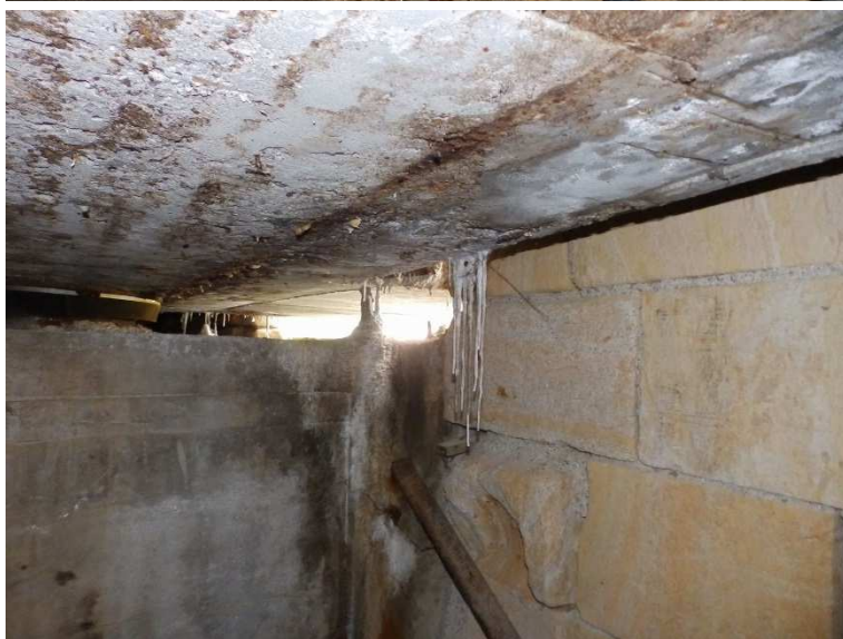
Průsaky s inkrustací v krajní část u pilíře P2 v poli 1.
