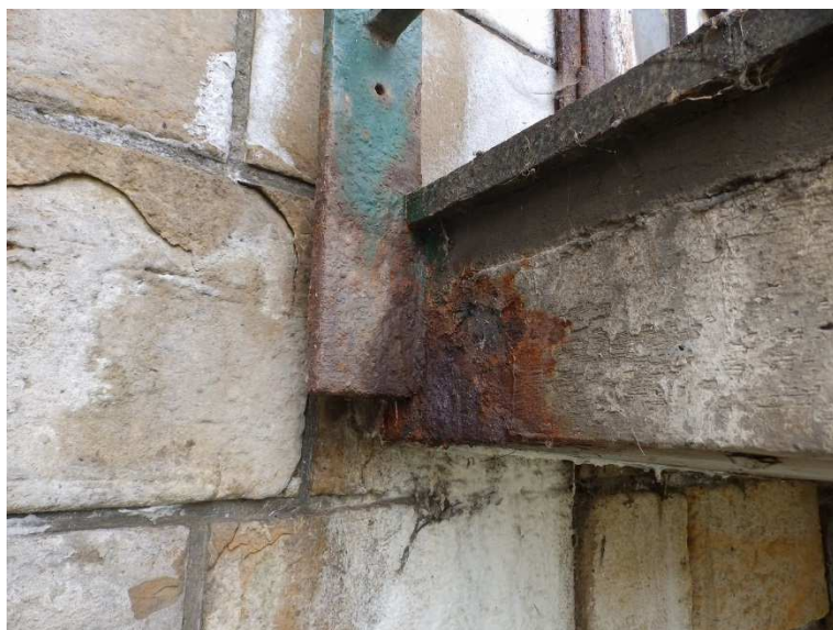
Silná koroze ocelového sloupku zábradlí.
