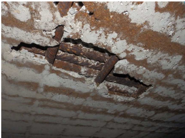
Fotodokumentace dutiny nad klenbou pole 2
