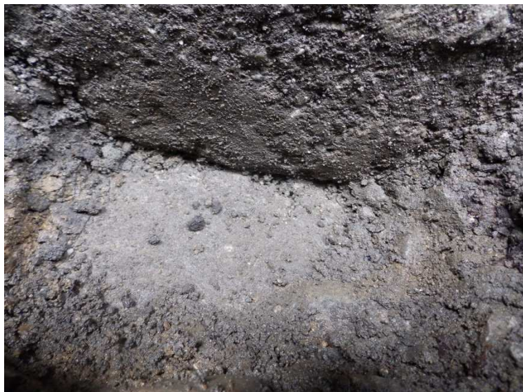
Detail - spára mezi deskou a podkladním betonem.
