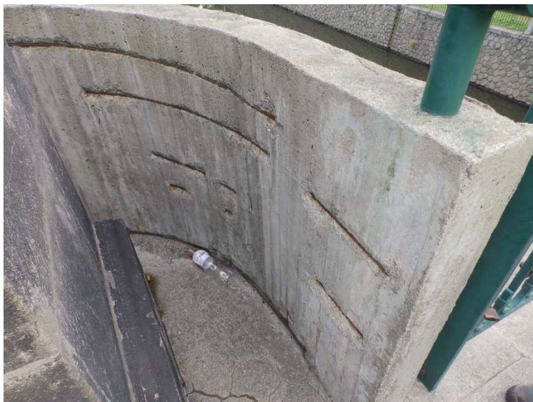
Separace krycí vrstvy na nice, koroze výztuže.
