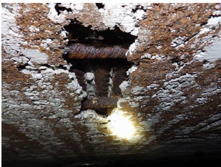
Štěrkové hnízdo na spodním líci nosné konstrukce. Koroze výztuže.
