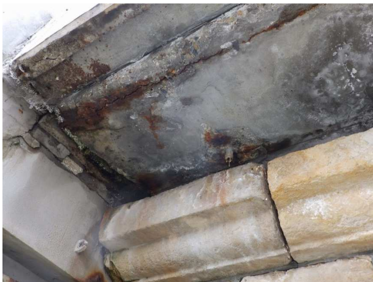
Silné průsaky na spodním líci římsy a konzole NK u mostního závěru.
