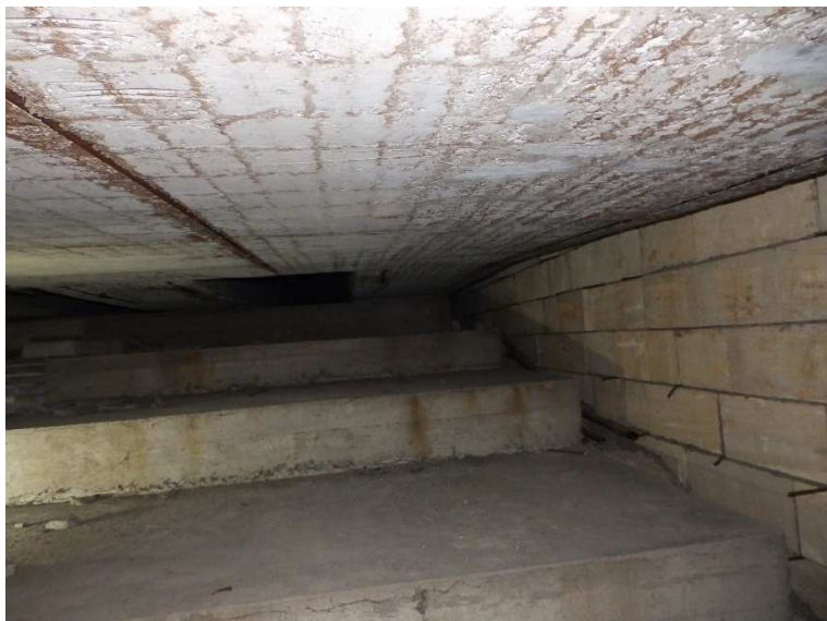
Pohled do druhé 1/2 pole 2, na spodním líci nosné konstrukce velké množství šterkových hnízd.
