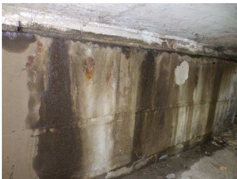
Aktivní zatékání na líc opěry OP4.
