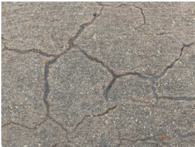
Trhliny na horním povrchu římsy (podezření na ASR).
