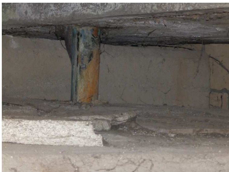
Průsaky s inkrustací v místě odvodňovací roury
