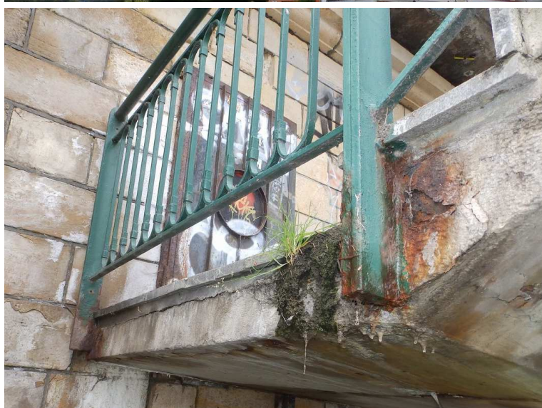
Zatékání, inkrustace, degradace betonu.
