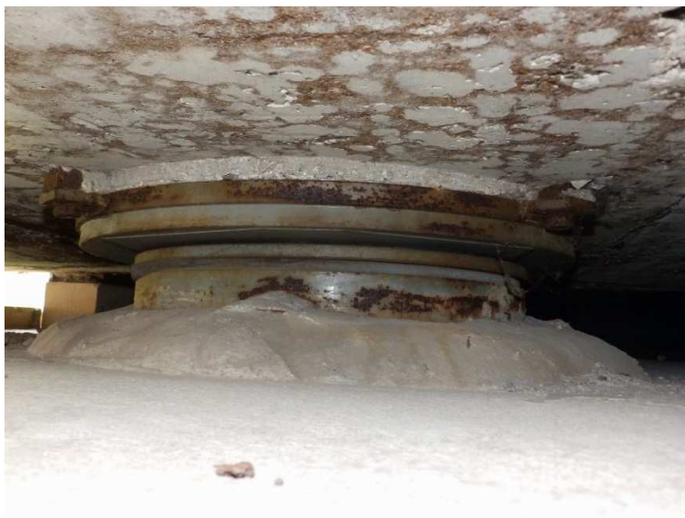
Povrchová koroze ložisek na P3.
