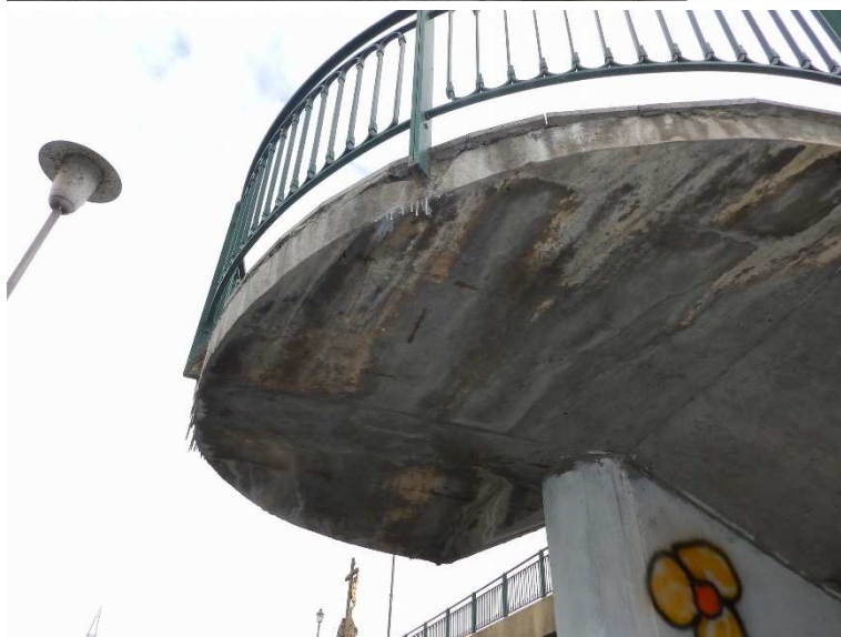
Silné zatékání přes okraj na spodní líc schodiště.
