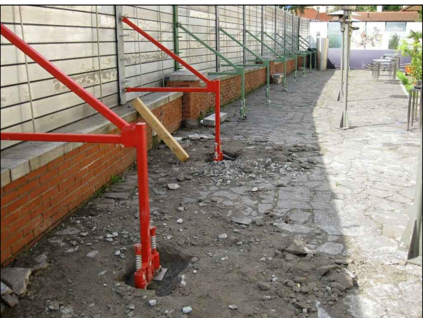
PROBLEMATICKÉ ČERVENÉ PODPĚRY SLUPICE V MÍSTĚ HERGETOVY CIEHLNY NÁVRH–ZKRÁCENÍ PODPĚR NA DÉLKU PODPĚR ZELENÝCH A PŘEBARVENÍ NA ZELENOU BARVU
