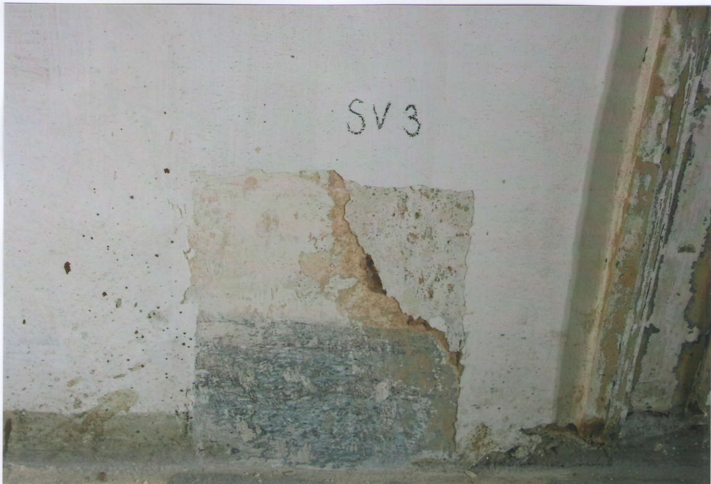
53. Pohled na sondu SV 3 - s nálezem původního šedého soklu, výška 18 cm.
