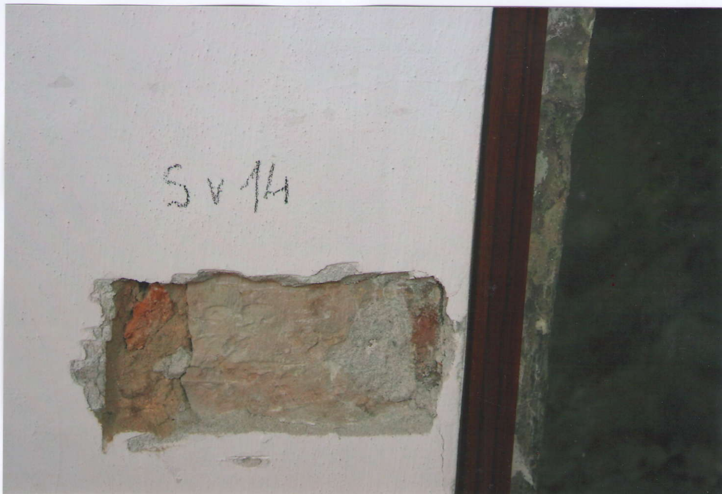
19. Pohled na sondu SV 14 - s nálezem opukového ostění.
