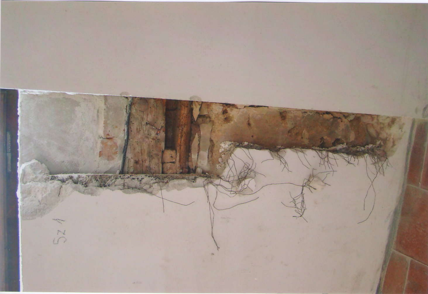
7. Pohled na sondu pod parapetem na západní stěně - s nálezem novějšího rámování parapetu, dřevěného trámků a původní omítky zakryté hereklitem.
