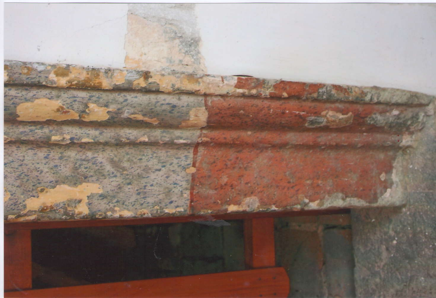
24. Detail spodní části ostění s červeným soklem, šedým ostěním a tmavě modrými stříkanci.
