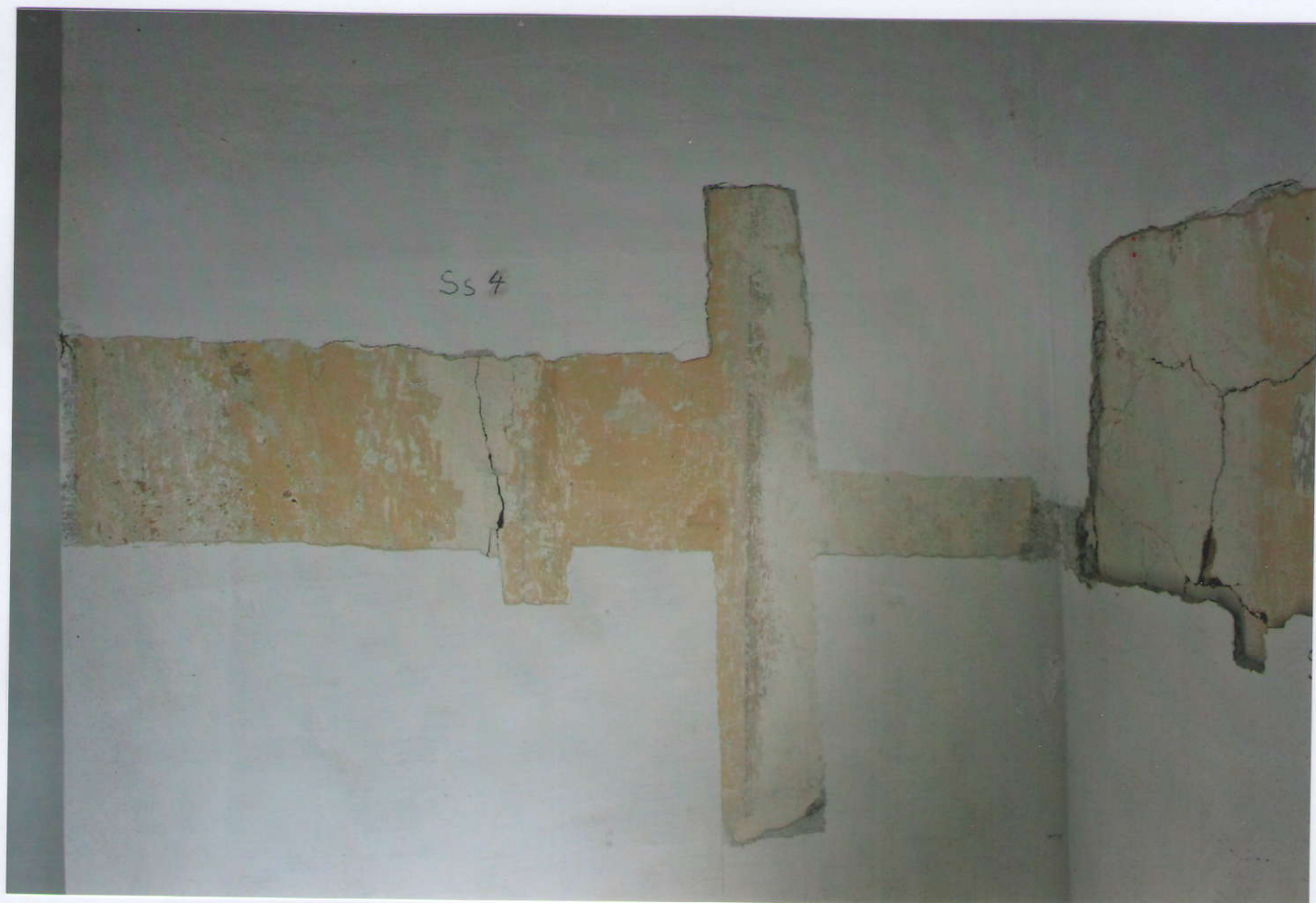
54. Pohled na sondu SS 4 - na severní stěně, s nálezem malovaného zrcadla s širší šedou linkou orámovanou tmavou hnědou linkou a dvěma bílými linkami.
