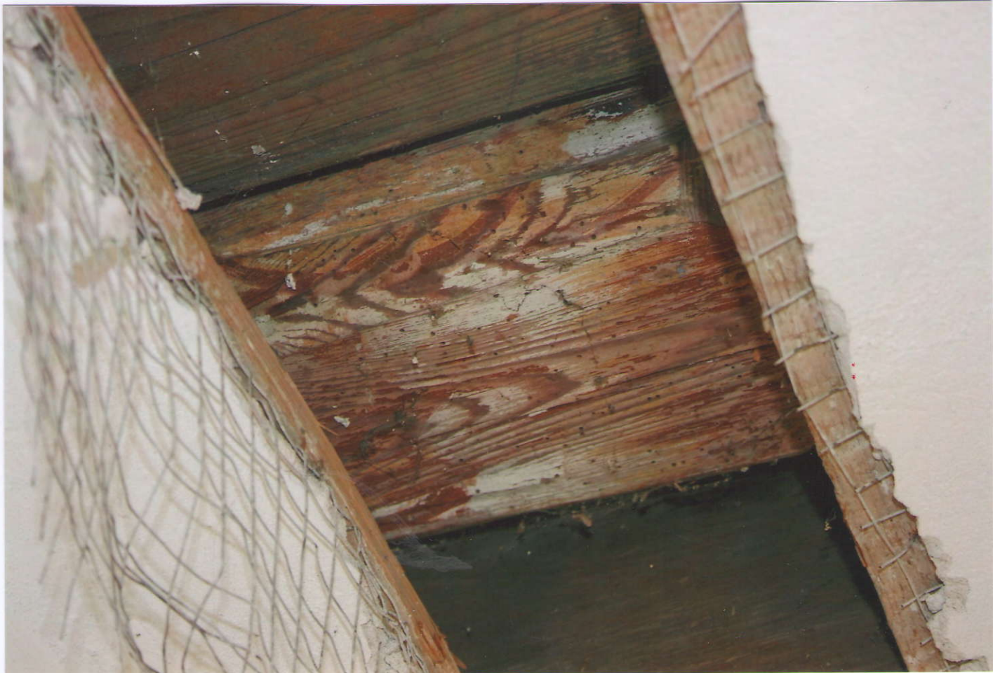
75. Detail s nálezem původního malovaného záklopového stropu.
