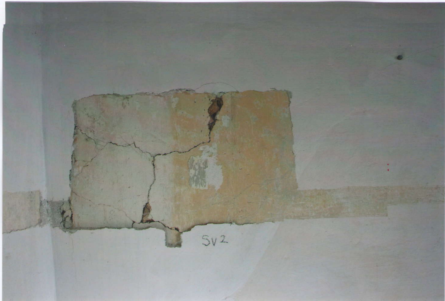
52. Pohled na sondu SV 2 - s nálezem původního malovaného okrového zrcadla .
