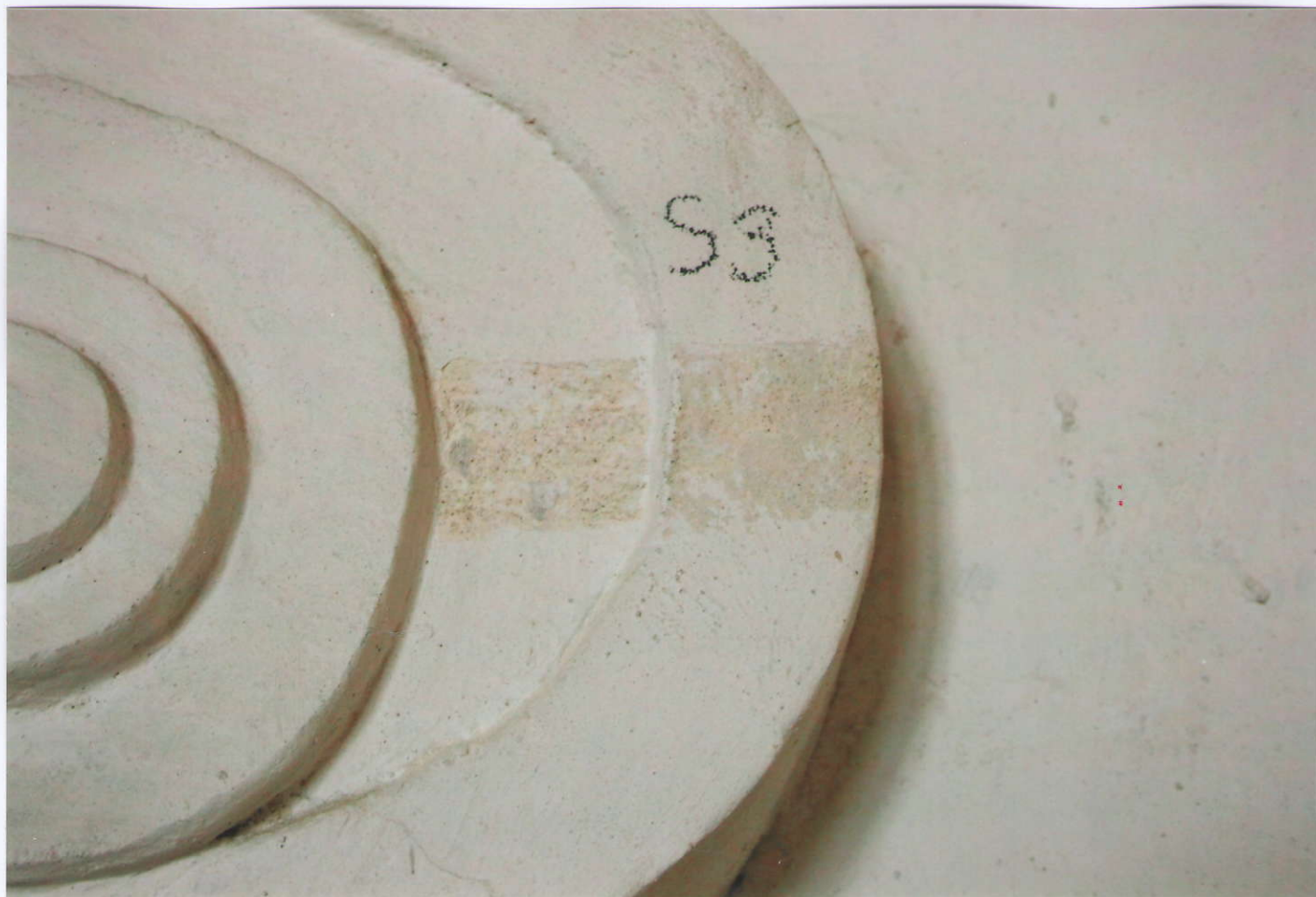
89. Pohled na sondu S 3 - s nálezem okrového nátěru u vpadlých ploch a vystouplé plochy v odstínu slonovinové kosti.
