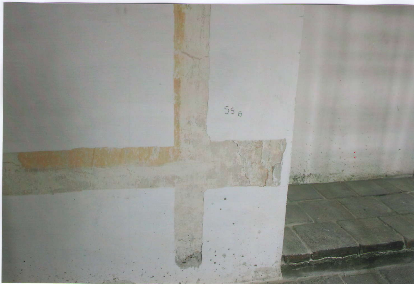
58. Pohled na sondu SS 6 - s nálezem okrového zrcadla s rámuujícími linkami.
