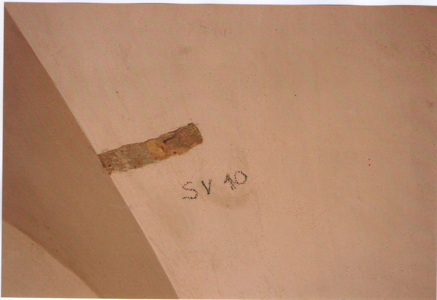
14. Pohled na sondu SV 10 - východní část klenby, s nálezem fragmentu původní omítky, s cementovými vysprávkami.
