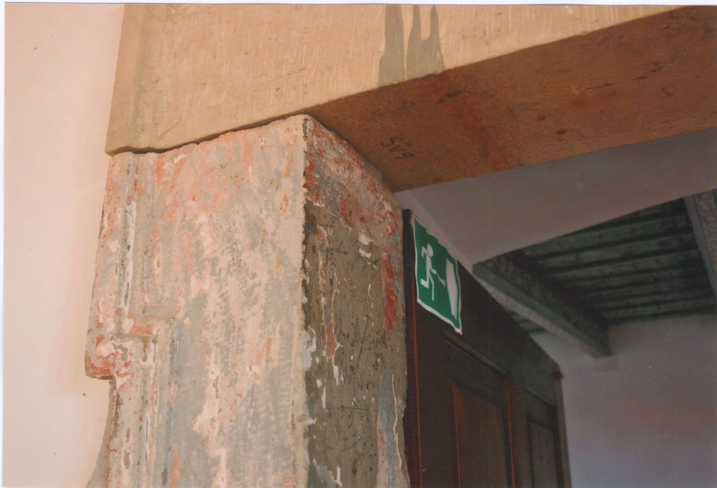
114. Pohled na sondu SV 9 - s nálezempůvodního cihlověčerveného mramorování.
