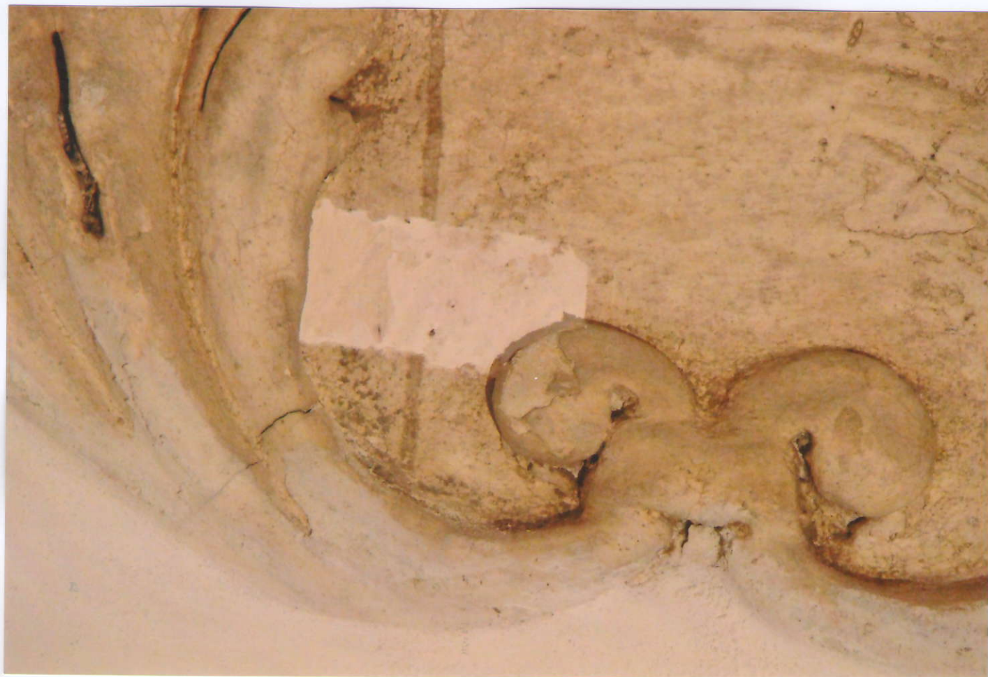
40. Detail štukové výzdoby se sondou, s nálezem původní barevnosti.
