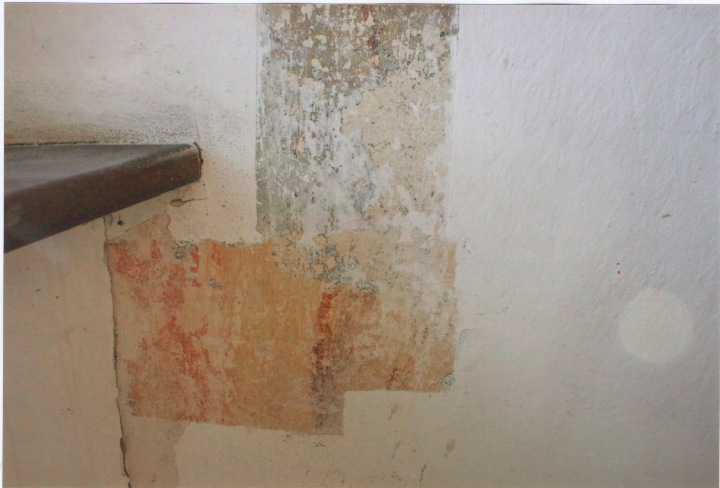
160. Detail sondy SJ 25 - ve spodní části s nálezem starší etapy dekorativní výmalby.
