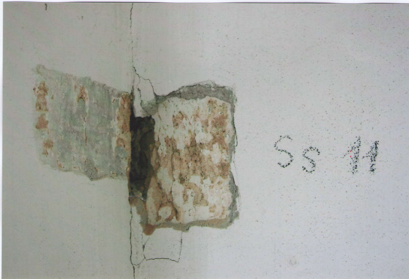
63. Severní stěna s výklenkem, pohled na sondu SS 11 - s nálezem novějších hrubých omítek, s pozdější zazdívkou vchodového otvoru.
