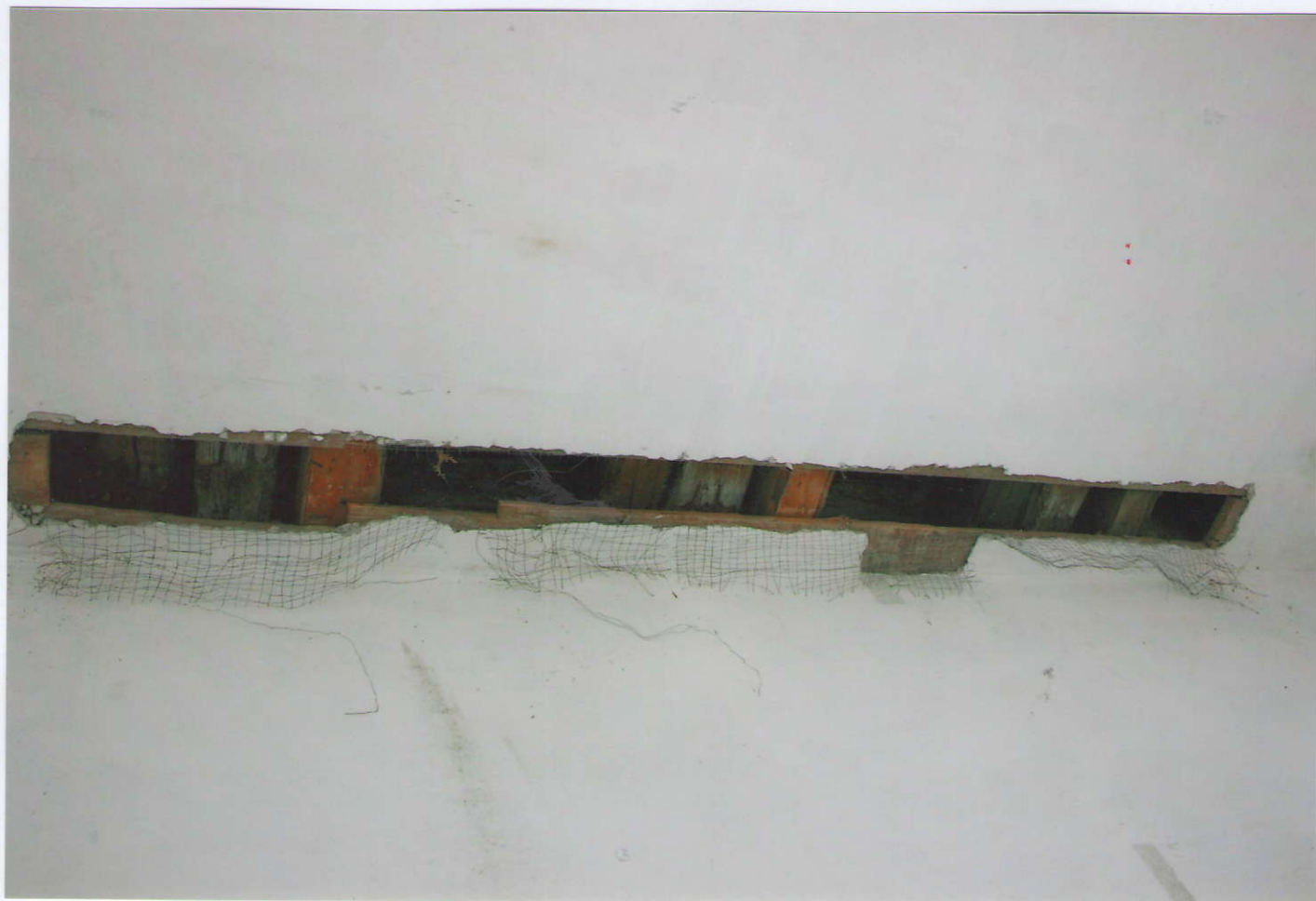
72. Celkový pohled na jižní část stěny se stropem, po sejmutí omítek a dřevěného podbití, s nálezem původního malovaného záklopového stropu.
