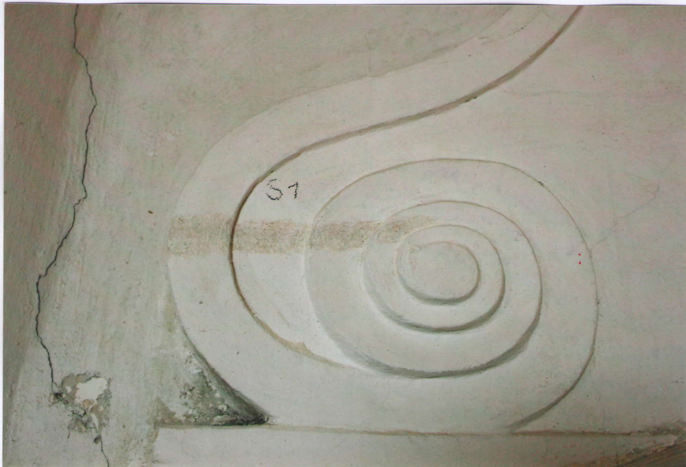
87. Pohled na sondu S 1 a bohatě profilovanou volutu - s nálezem původní omítky s okrovým nátěrem u vpadlých ploch, voluta v odstínu slonovinové kosti.
