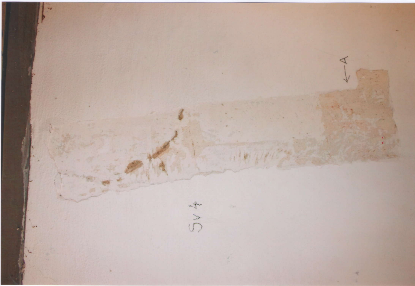
126. Pohled na sondu SV 4 - původní omítka s fragmenty malované výzdoby s červeným mramorováním.
