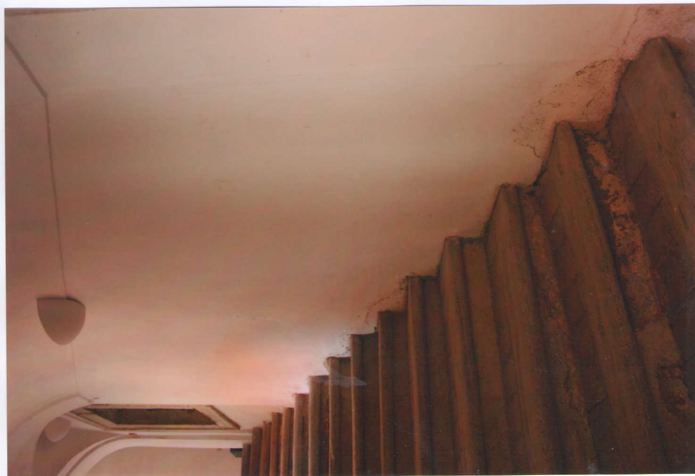
4. Celkový pohled na pravou část jižní stěny vstupního prostoru - zvětralé a opadané omítky do výše 2. metrů.
