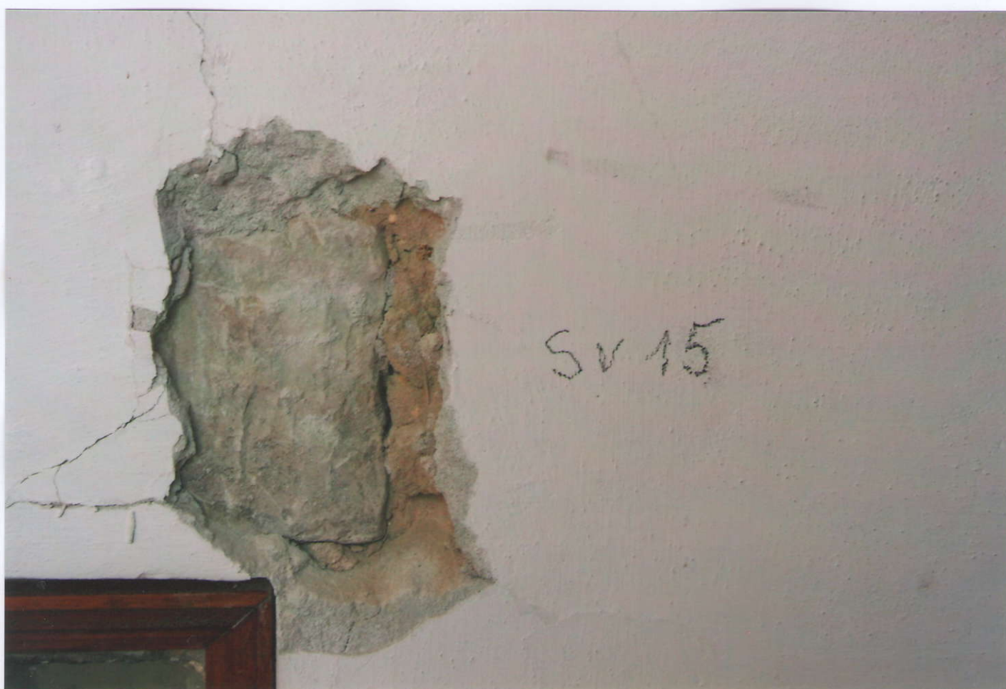
20. Pohled na sondu SV 15 - s nálezem opukového ostění.
