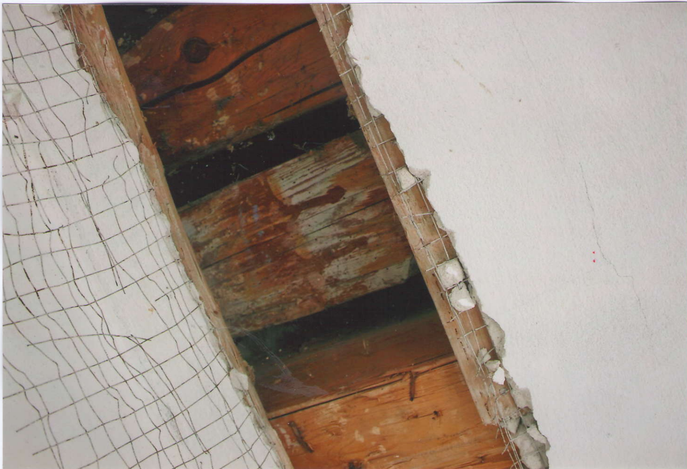
73. Detail s nálezem původního malovaného trámu v základním bílém odstínu, s malovaným okrovým a cihlověčerveným listovcem.
