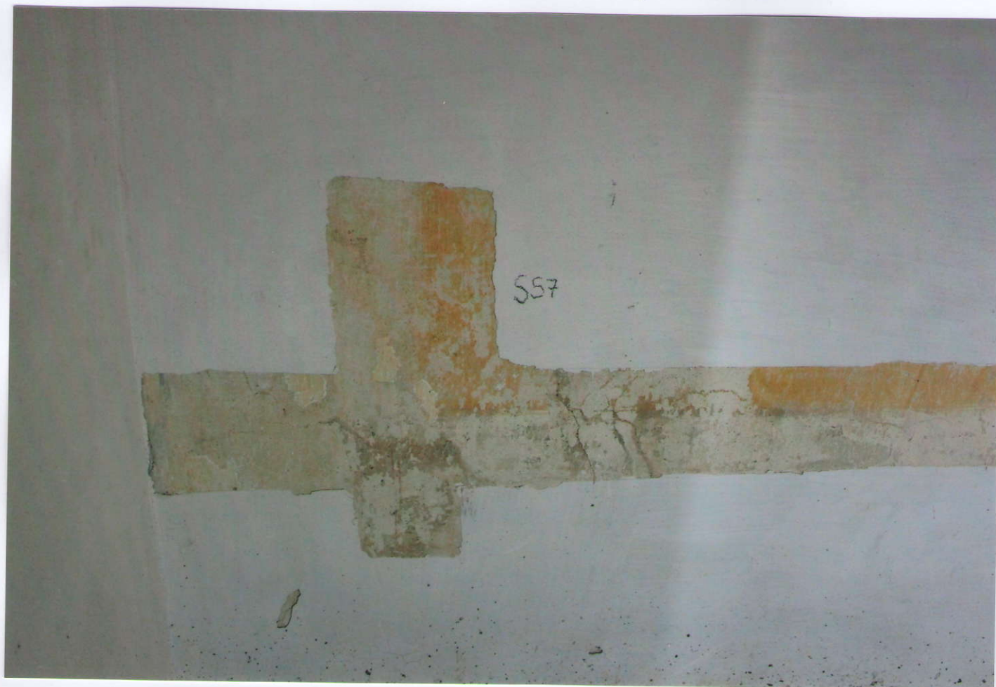
59. Pohled na sondu SS 7 - s nálezem okrového zrcadla s rámuujícími linkami.
