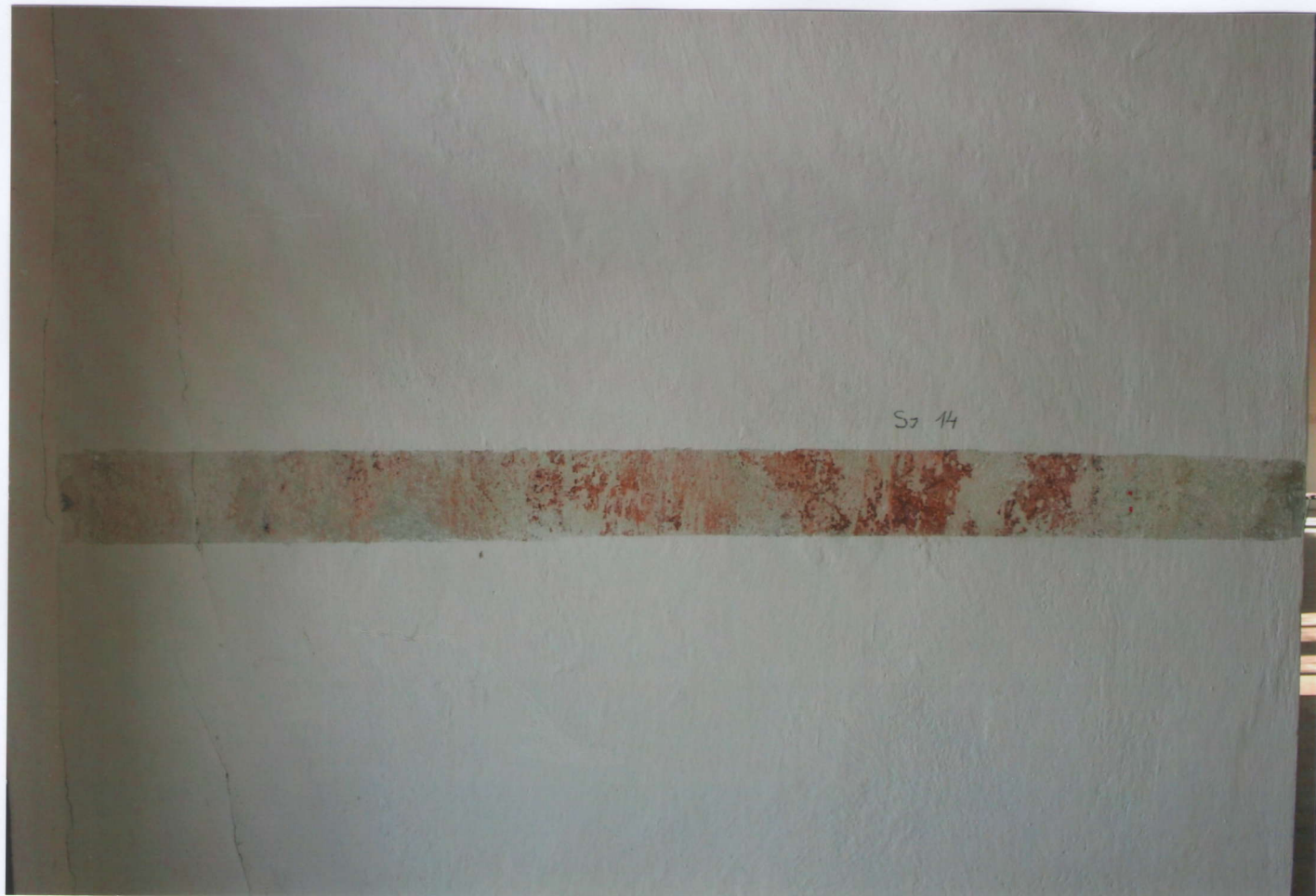
140. Pohled na sondu SJ 14 - pravá špaleta 2. okna, s nálezem cihlověčerveného mramorování.
