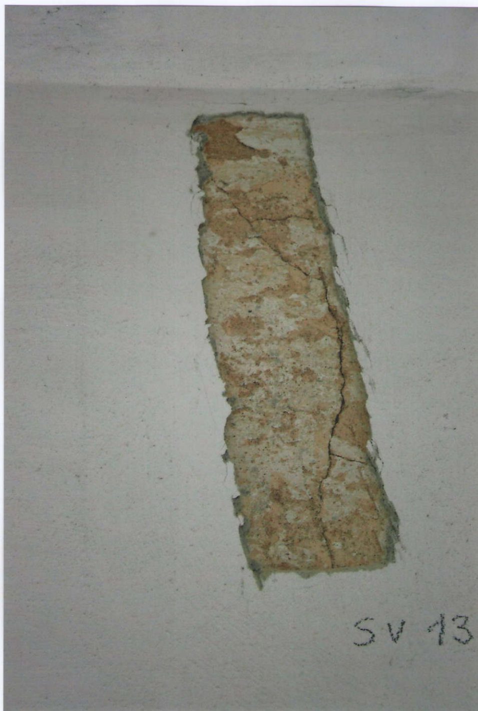
65.. Pohled na sondu SV 13 - na východní stěně, s nálezem novější silné, hrubé omítky.
