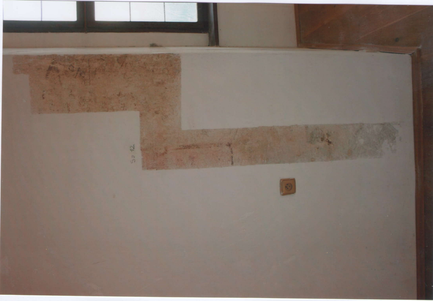
135. Sonda SJ 12 - s nálezem barokního cihlověčerveného mramorování s orámováním.
