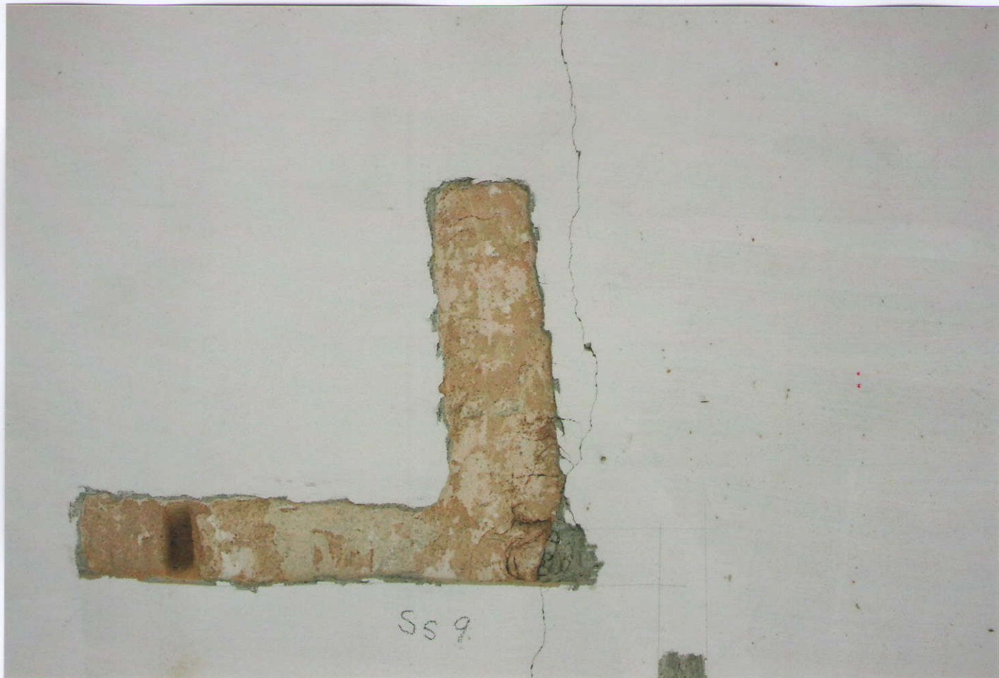
61. Pohled na severní část stěny se sondou SS 9 - s nálezem novějších hrubších omítek.
