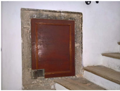
FOTO - KAMENNÉ OSTĚNÍ DVÍŘEK VSTUPU DO KROVU NAD SCHODIŠTĚ
