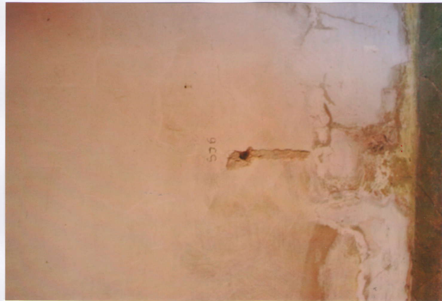
12. Pohled na sondu SJ 6 - jižní stěna při vstupu na schodiště vzlínající vlhkostí napadené nové omítky..
