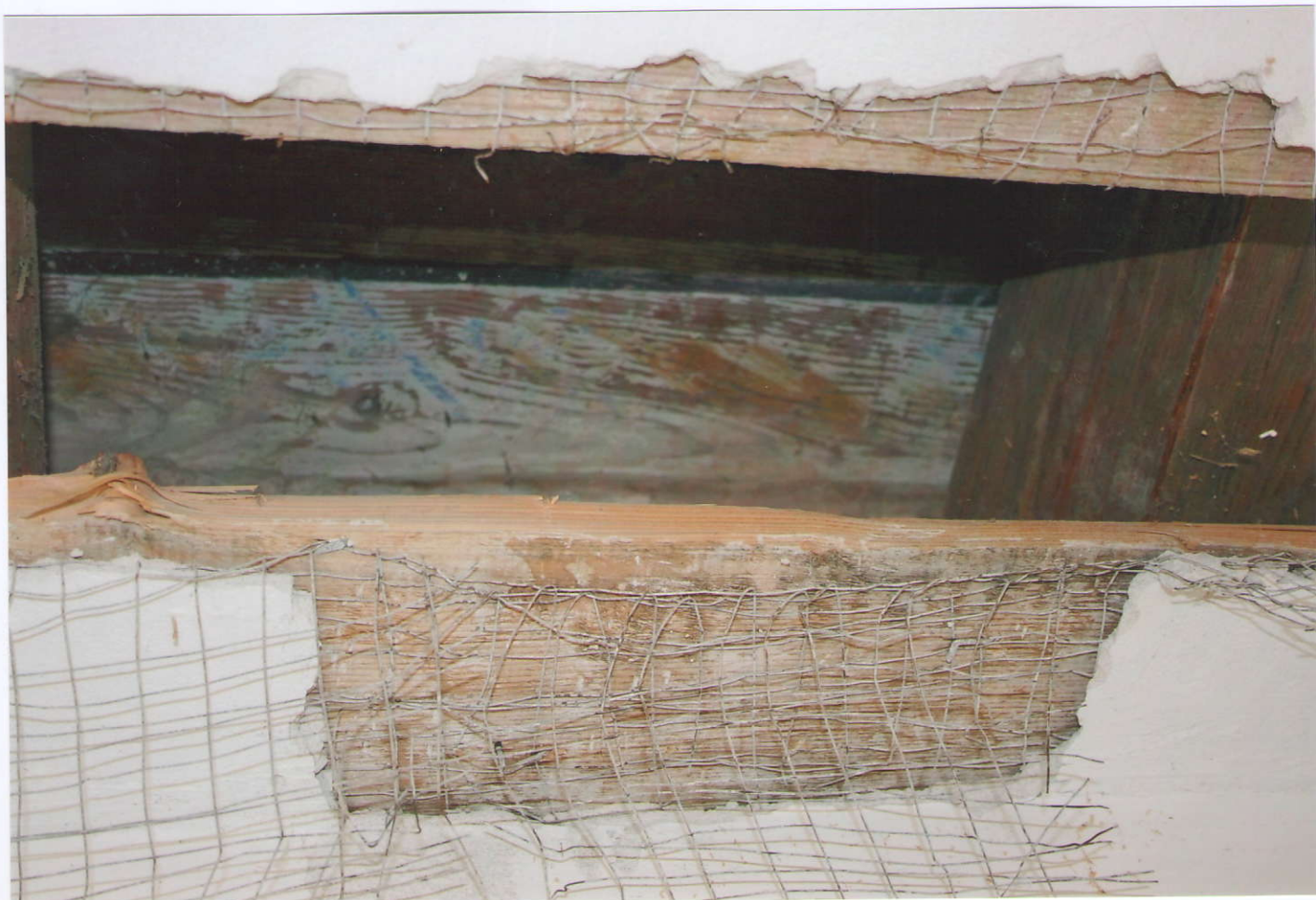
76. Detail s nálezem původního malovaného záklopu v odstínech základní bílé, okru, cihlověčervené a modré..
