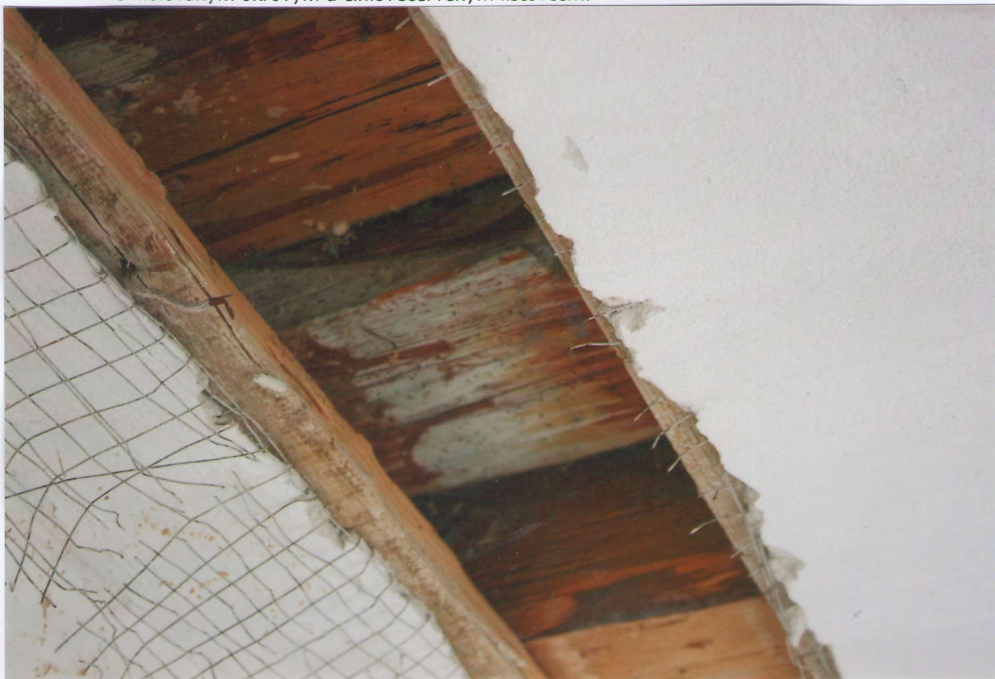
74. Detail s nálezem původního malovaného trámu v základním bílém odstínu, s malovaným okrovým a cihlověčerveným listovcem.
