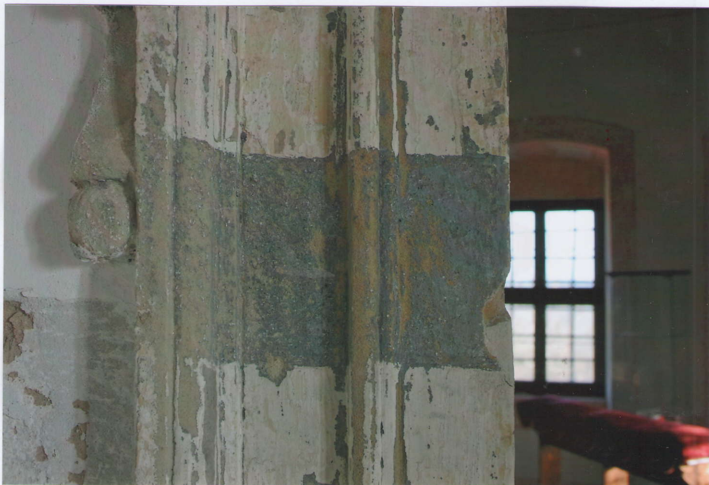
50. Pohled na barokní ostění se sondou s nálezem původní šedé polychromie.
