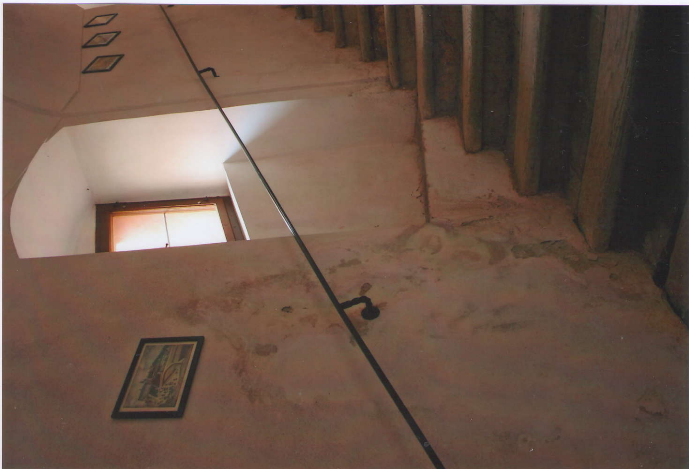
3. Celkový pohled na levou severní stěnu vstupního prostoru - zvětralé a opadané omítky do výšky 2 metrů.
