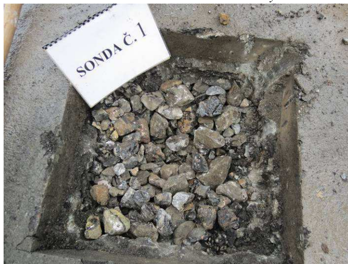
Obr.2.G Sonda č.1 - materiál konstrukční vrstvy
