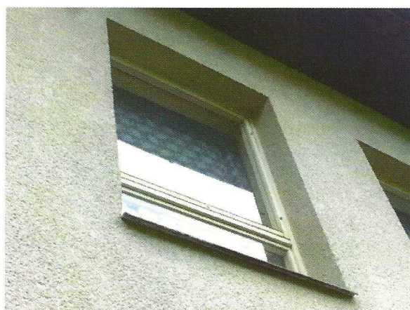
č. 16 – 18 Okna i okenní parapety těsně přiléhají ke zdivu
