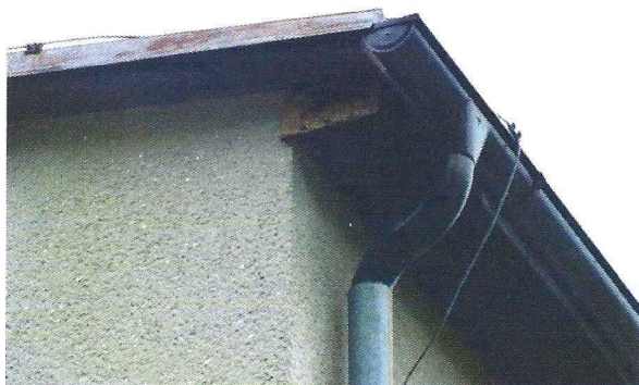
č. 19 - 20 Okapové svody jsou vedeny vně zdiva
