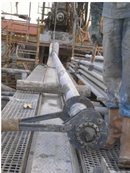
Obr. 5: Jadro vrtané dvojitou jadrovnicou GEOBOR S
