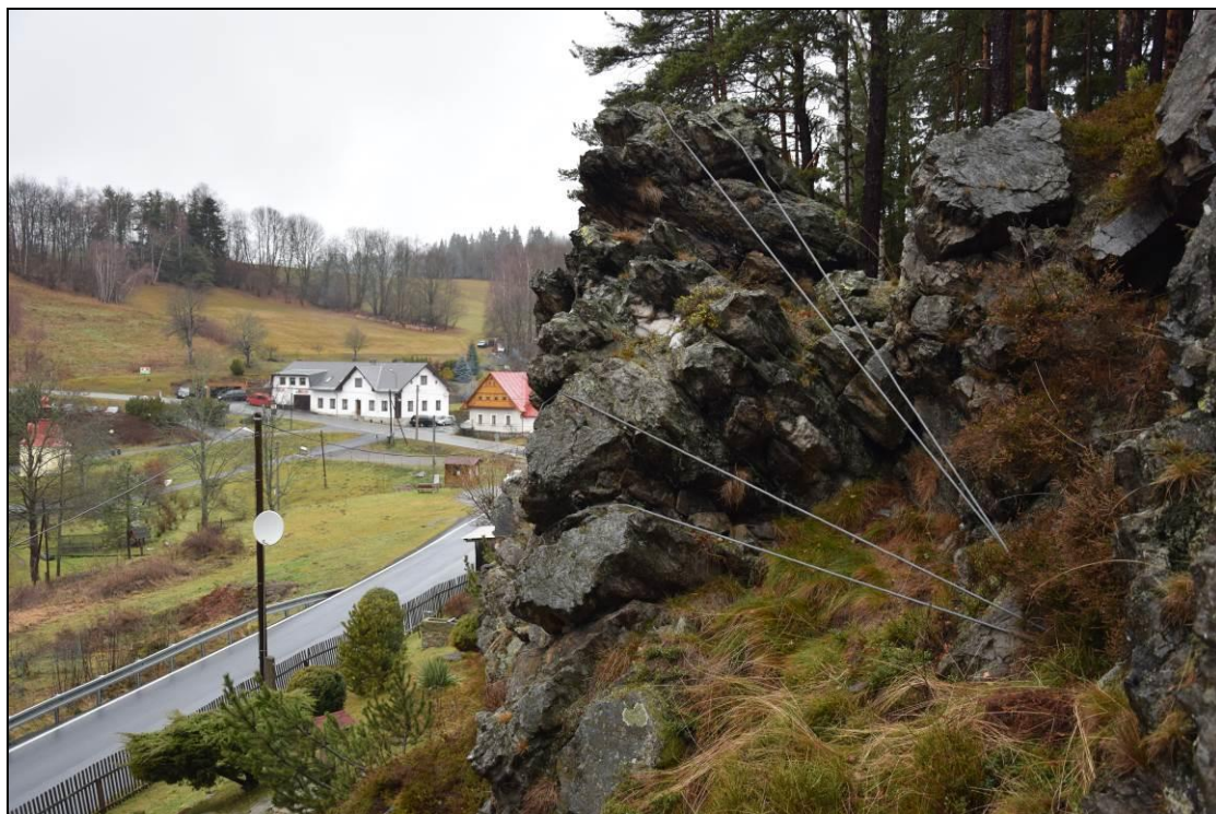
Foto 7 Pohled na nestabilní věžovitý skalní útvar ve střední části severojižního průběhu skalního svahu (stěny). Dobře patrné je celkové rozvolnění skalního útvaru i žadatelem aplikovaný zádržný lanový systém.
