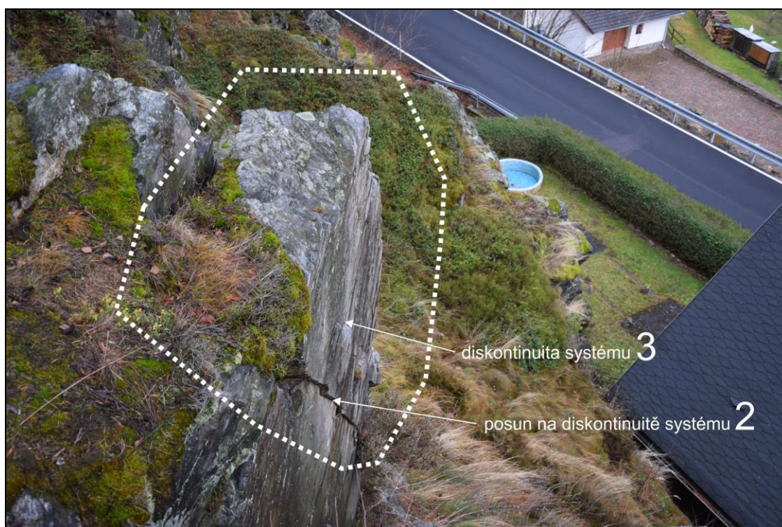
Foto 8 Nestabilní blok ve střední části zájmového území (vyznačen bílou přerušovanou čarou) – pohled shora.
