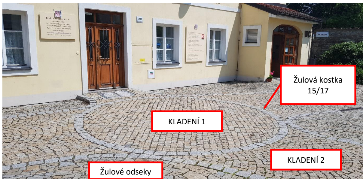
Ukázka provedení dlažby – provedení již hotové části Na Zadomí – východní část
