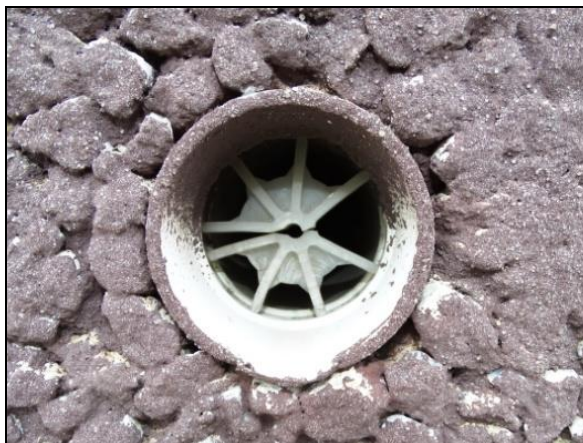
č. 8 Detail VO s funkční plastovou vložkou
