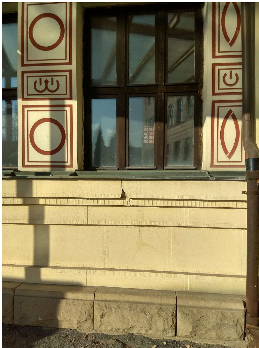
Svislá trhlina v parapetním zdivu ve východní zdi
