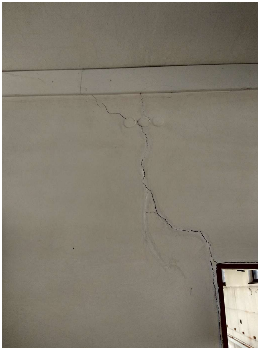
Trhlina ve vnitřní přičce
