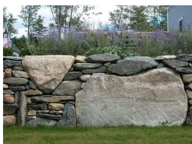
Ukázka kamenné zdi – haklíkové zdivo se zabudovanými jednotlivými kameny
