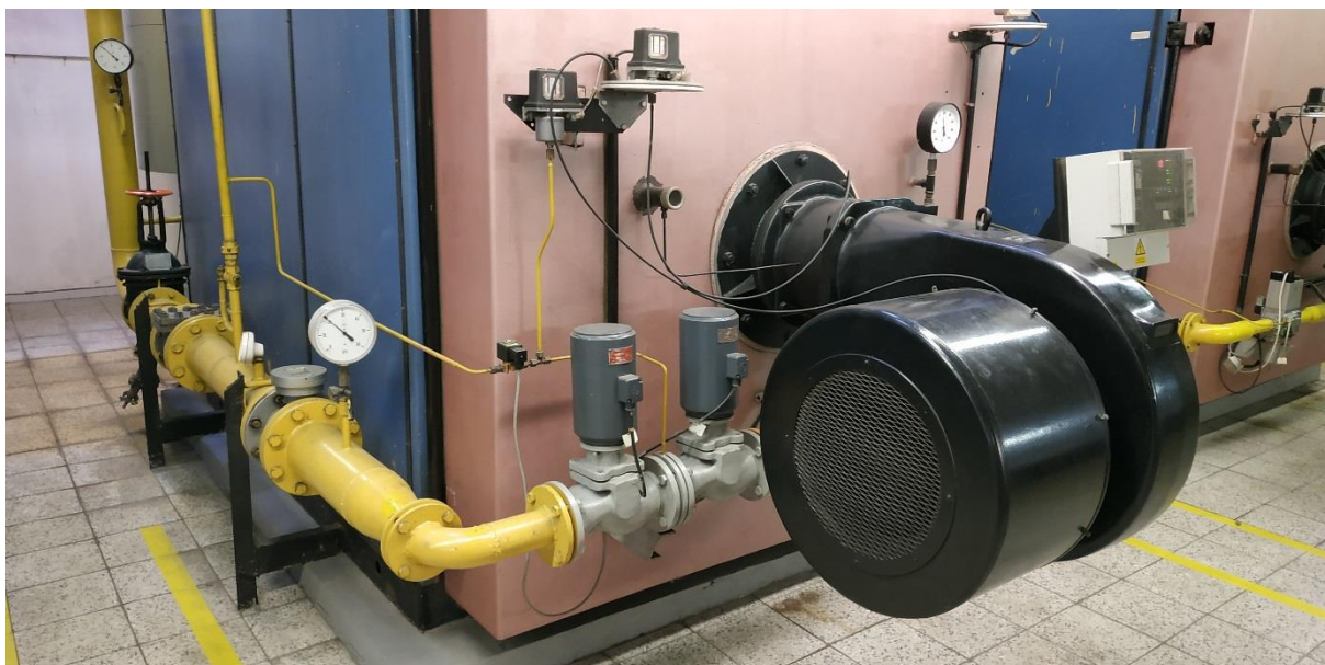
Obrázek 2 - Plynová řada a hořák
