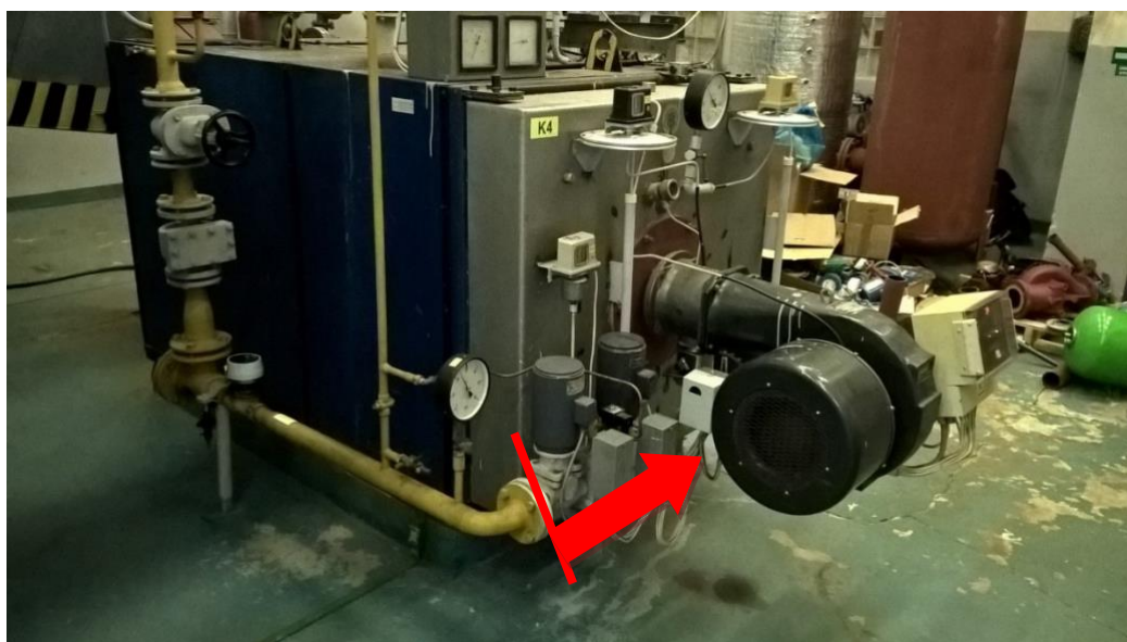
Obr. 3 Hranice dodávky na straně plynu
