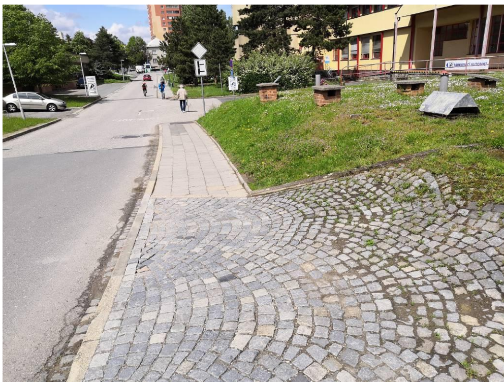
Pohled na dlažbu k demontáži
