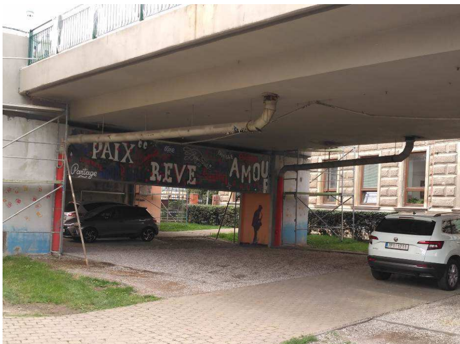
Obrázek 1 - svody odvodnění estakády
