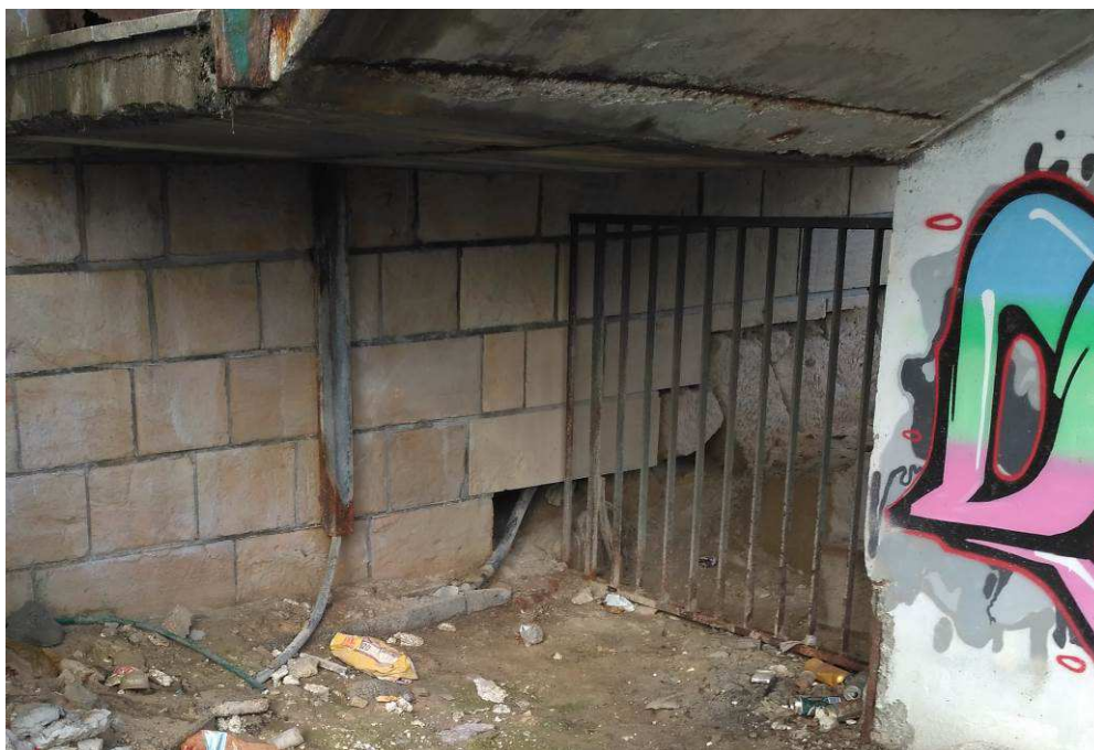
Obrázek 2 – Nechráněný kabel PmdP
