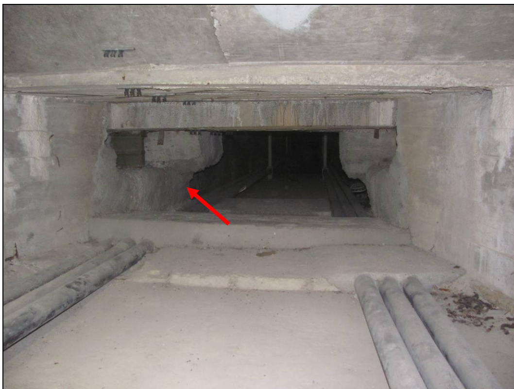
Foto 51: Detail zmonolitněného kloubu v poli 2.
