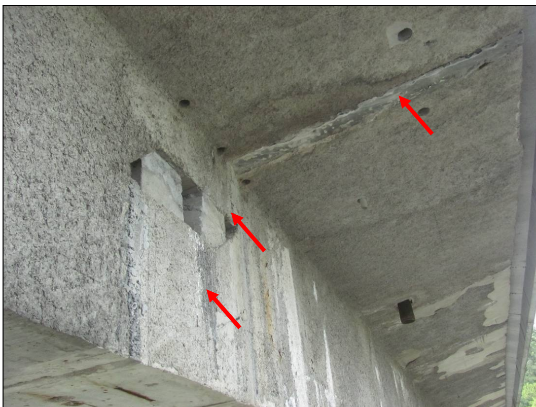
Foto 16: Povodní strana, pole 2. Detail zmonolitněného kloubu uprostřed rozpětí. Na površích nebyly nalezeny známky nějakého zjevného poškození, jako jsou např. trhliny, drcení betonu, nadměrné deformace. V oblasti kloubu viditelné lokální výluhy způsobené zatékáním, v době prohlídky neaktivní.
