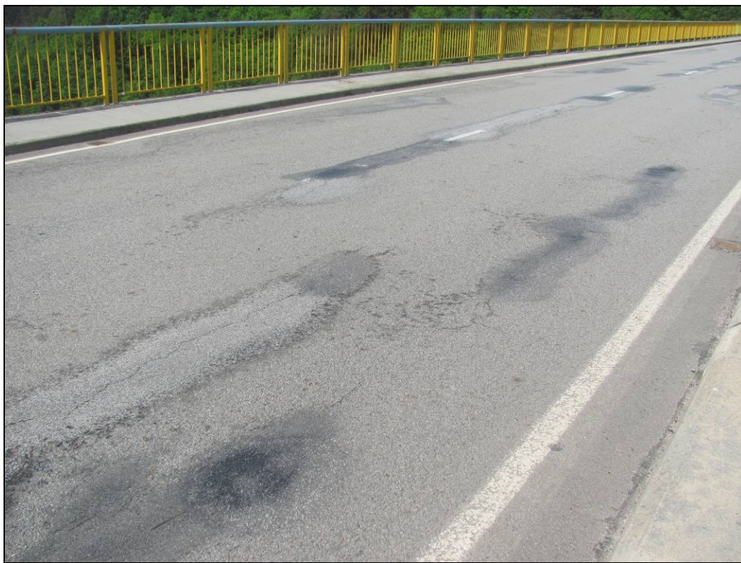
Foto 59: Zapravené výtluky na vozovce v asfaltobetonové vrstvě, trhliny a vyjeté koleje.
