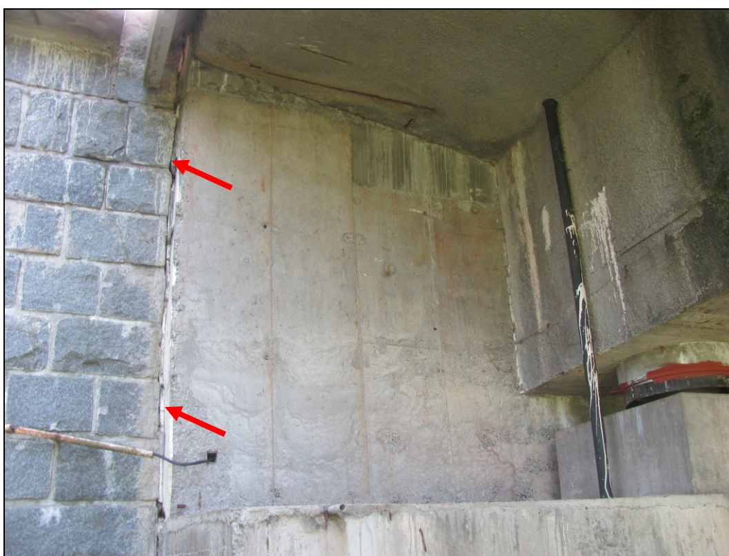
Foto 36: Dilatační spára mezi nosnou konstrukcí a kamenným křídlem. Viditelné výluhy po průsacích. V době prohlídky neaktivní.
