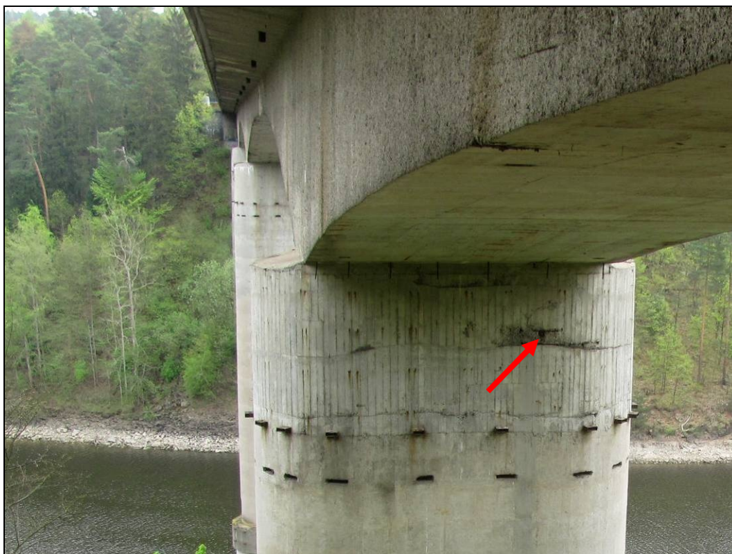
Foto 12: Povrchová až silná koroze odhalené výztuže v horní části pilíře.
