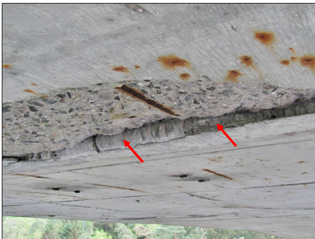
Foto 26: Pohled na spodní líc zmonolitněného kloubu. Dochází k ulamování hran betonu na styku dvou sousedních prvků až do hloubky cca 70 mm. Dobetonovaná spára je lokálně porušena trhlinami do šířky 0,2 mm. V místě ulámaných hran jsou v odkryté dobetonované spáře vloženy betonové jádrové vývrty.
