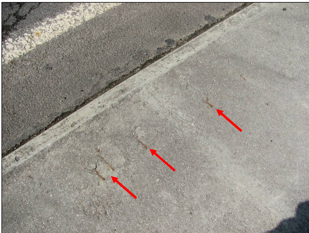
Foto 60: Detail vrchního líce chodníku, nedostatečné krytí výztuže a její koroze.
