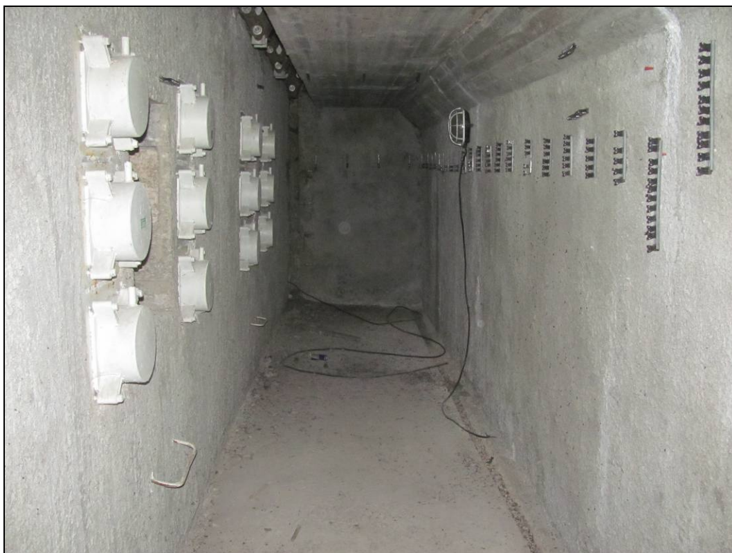
Foto 56: Pohled do komory pod mostním závěrem, Zvíkovské Podhradí. Lokální výluhy způsobené zatékáním. V době prohlídky neaktivní.
