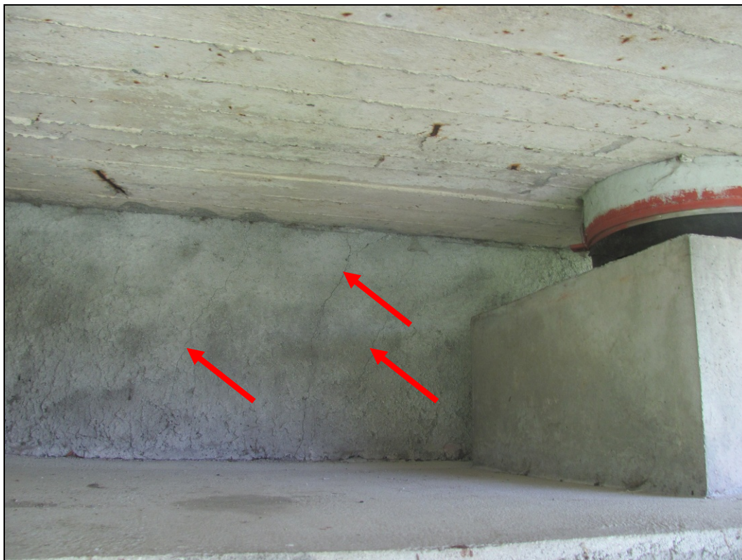
Foto 5: 3x šikmá trhlina ve vrstvě torkretu, na závěrné zídce v prostoru za ložisky.
