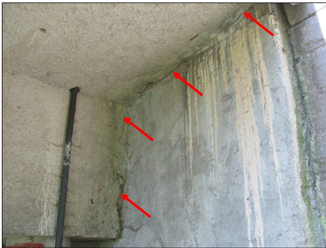
Foto 4: Trhlinou prokreslená dilatace mezi závěrnou zídkou a komorou (levá strana).
