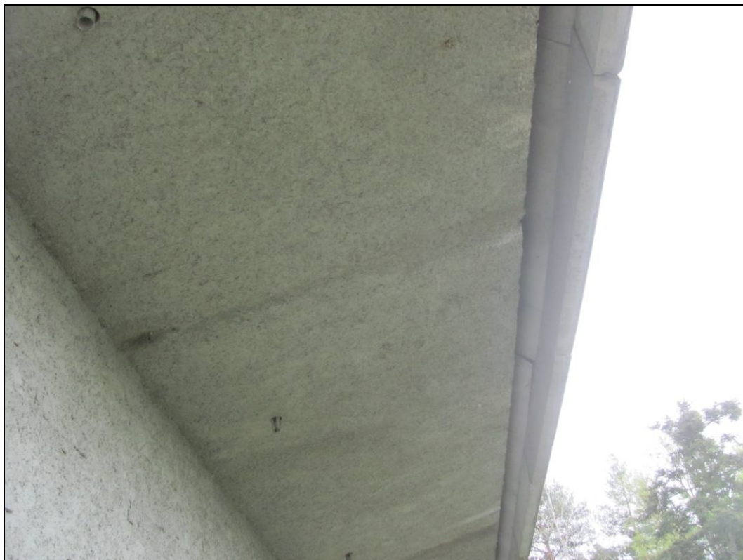
Foto 30: Návodní strana, pole 4. Bok komor a spodní líc konzol plošně zakryt vrstvou torkretu.
