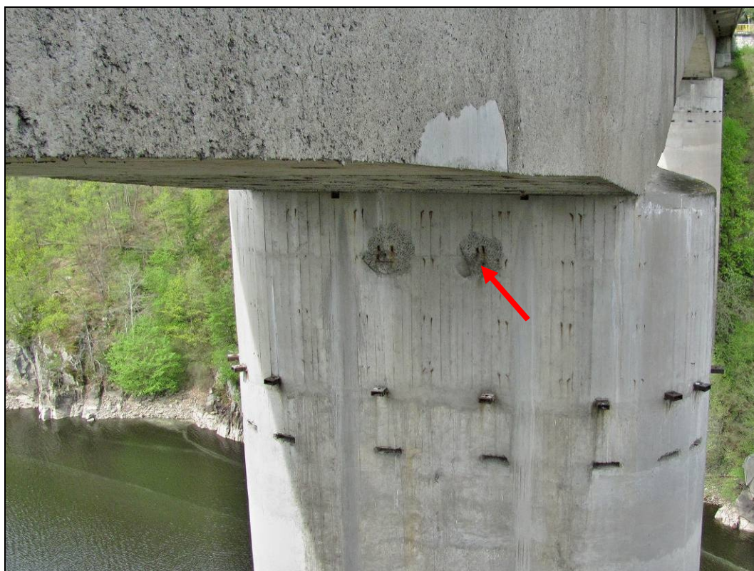
Foto 20: Detail hlavy pilíře P3, povrchová až silná koroze odhalené výztuže v horní části pilíře.
