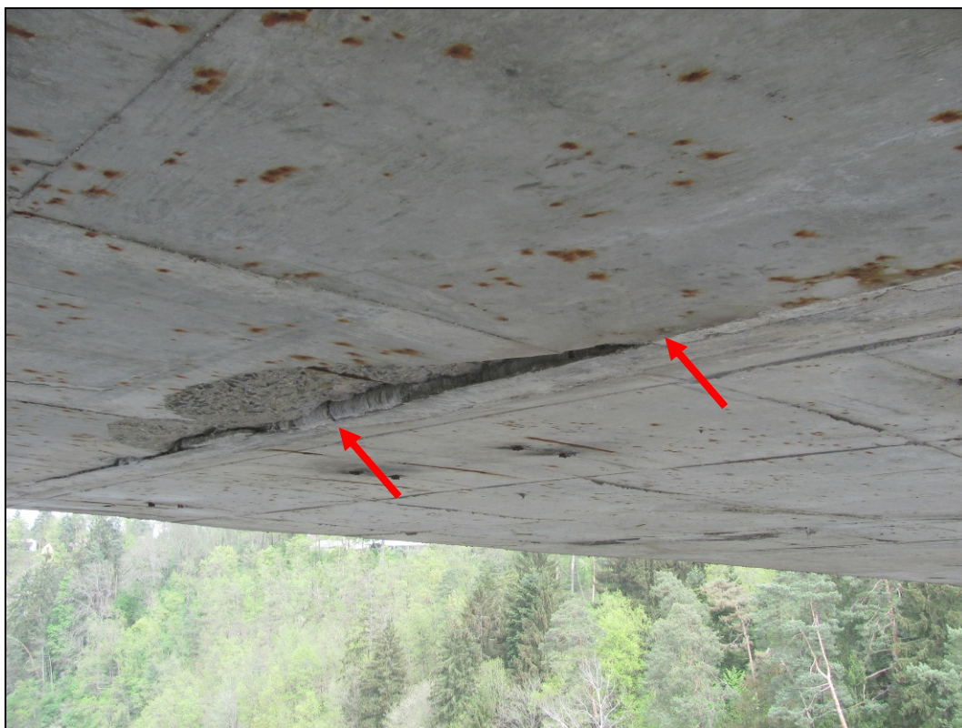
Foto 27: Pohled na spodní líc zmonolitněného kloubu. Dochází k ulamování hran betonu na styku dvou sousedních prvků až do hloubky cca 70 mm. Dobetonovaná spára je lokálně porušena trhlinami do šířky 0,2 mm. V místě ulámaných hran jsou v odkryté dobetonované spáře vloženy betonové jádrové vývrty.
