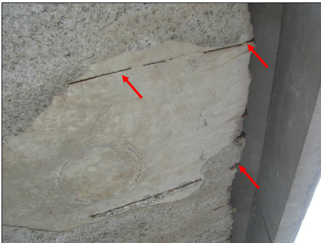
Foto 18: Na koncích konzol místa s odpadlou vrstvou torkretu. Odhalená výztuž. Zde dochází k povrchové korozi výztuže.
