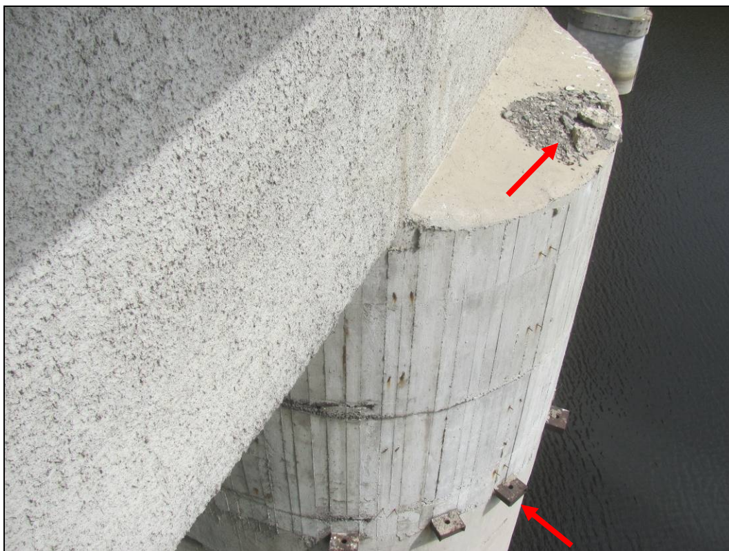
Foto 11: Pohled na Pilíř 2. Ponechaný vybouraný materiál na horním líci. Lokální povrchová koroze výztuže. Koroze ocelových konzol, pravděpodobně sloužících k ukotvení lávky.
