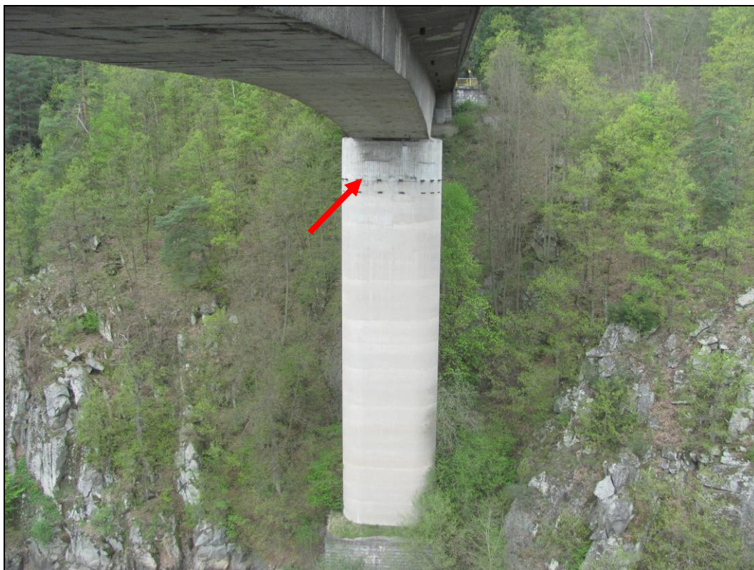
Foto 10: Pohled na pilíř P2. Viditelná spára. Koroze ocelových konzol, pravděpodobně sloužících k ukotvení lávky.
