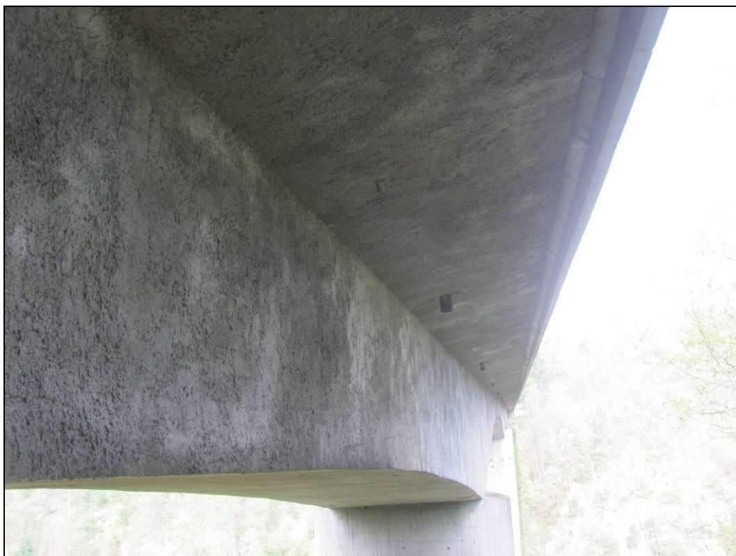
Foto 31: Povodní strana, pole 4. Bok komor a spodní líc konzol plošně zakryt vrstvou torkretu.
