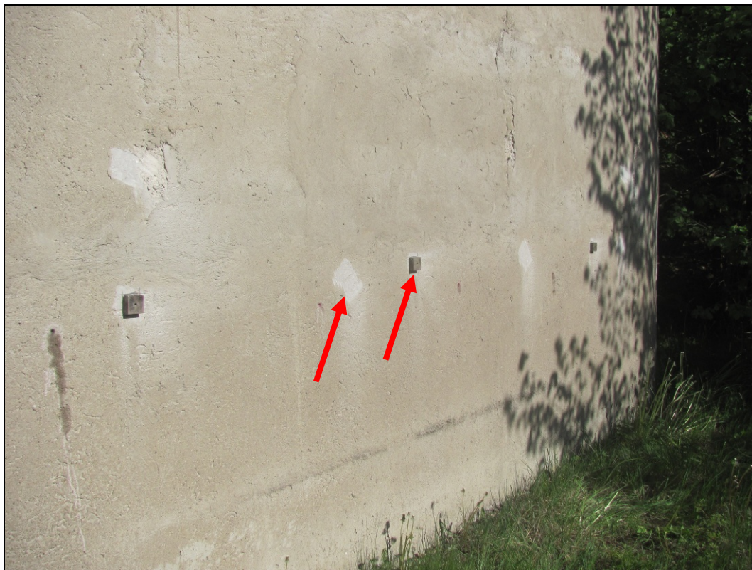
Foto 13: Pata pilíře. Viditelná místa prováděných testů.
