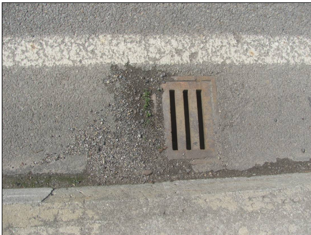
Foto 61: Detail částečně ucpaného vtoku odvodňovače.
