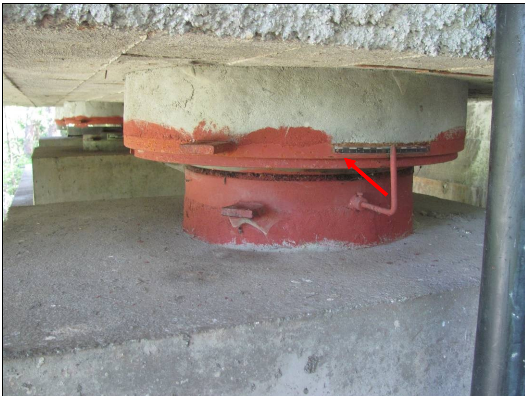
Foto 37: Pohled na pravé hrncové ložisko (NGe 2,5MN). Chybí ochranná manžeta.
