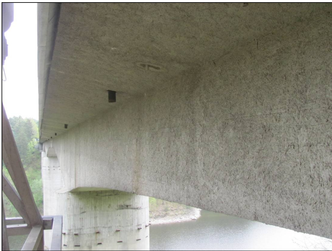
Foto 8: Pohled na bok komory v poli 1. Povodní strana. Bok komor a spodní líc konzol plošně zakryt vrstvou torkretu.
