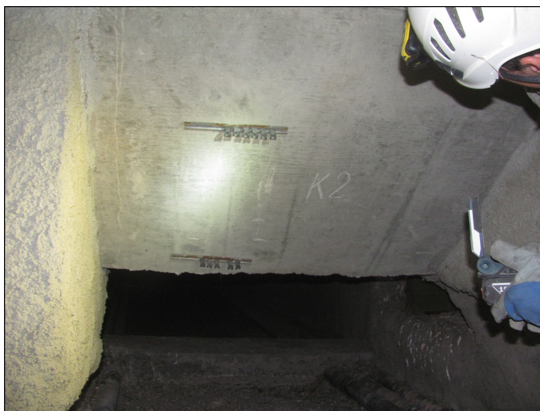
Foto 42: Detail zmonolitněného kloubu v poli 3. V čele příčnicku sít' trhlín.
