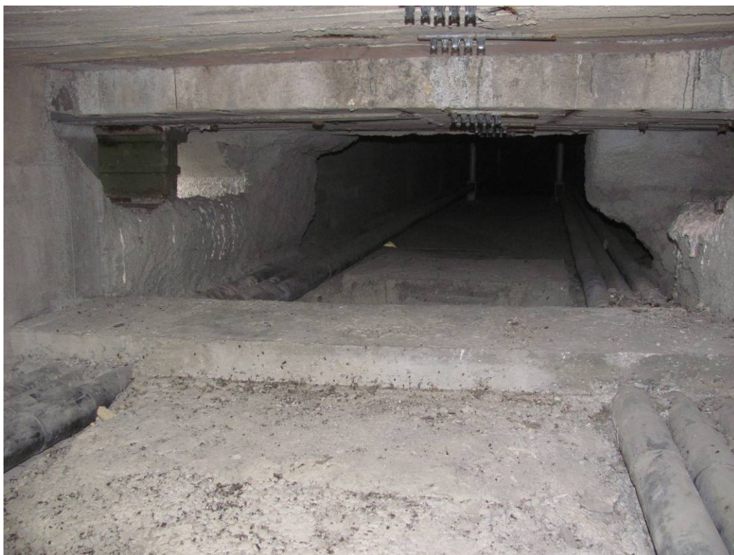
Foto 41: Detail zmonolitněného kloubu v poli 2.
