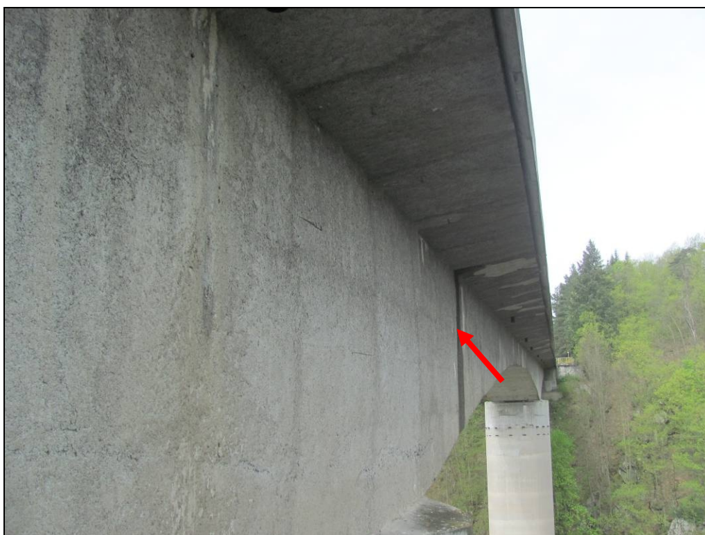
Foto 22: Povodní strana, pole 3. Bok komor a spodní líc konzol plošně zakryt vrstvou torkretu. Na spodním líci konzol místa s odpadlou vrstvou torkretu. Aktivní zatékání nefunkčním odvodňovačem na bok komory.
