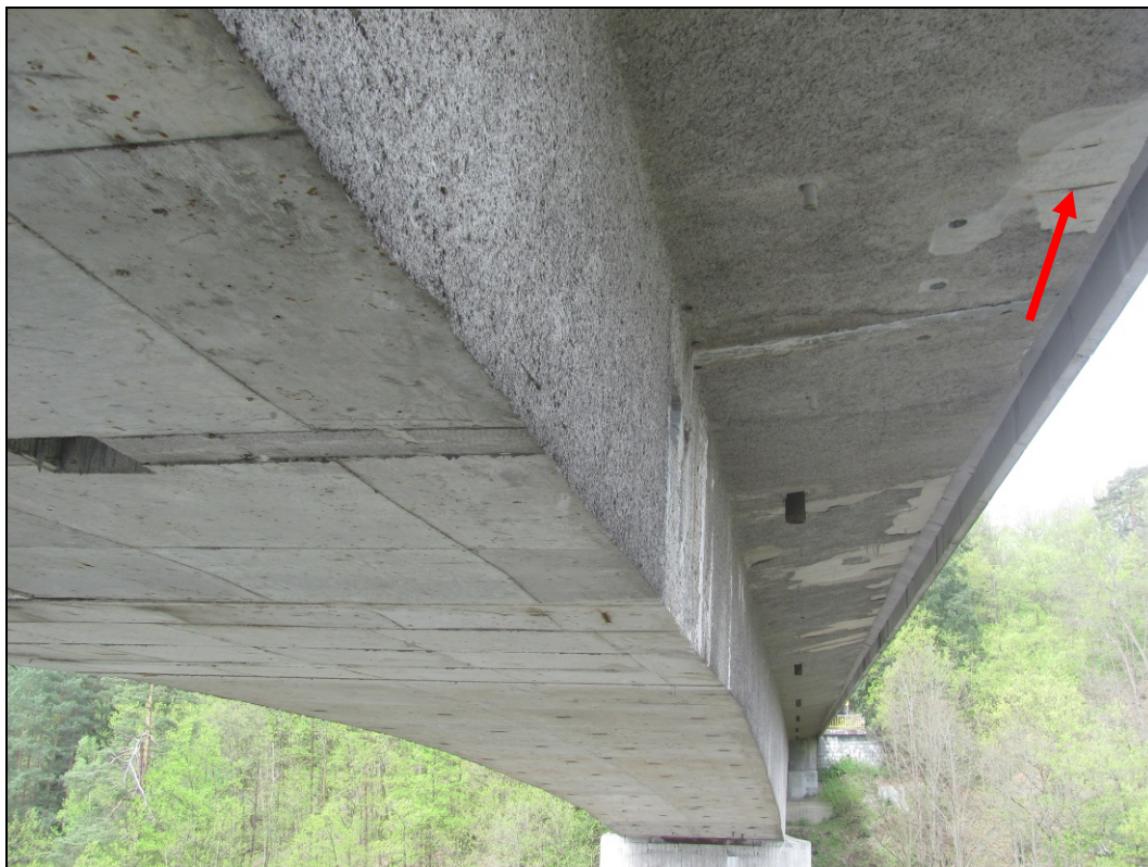
Foto 15: Povodní strana, pole 2. Bok komor a spodní líc konzol plošně zakryt vrstvou torkretu. Na spodním líci konzol místa s odpadlou vrstvou torkretu. Viditelný průsak v místě zmonolitněný kloubu.
