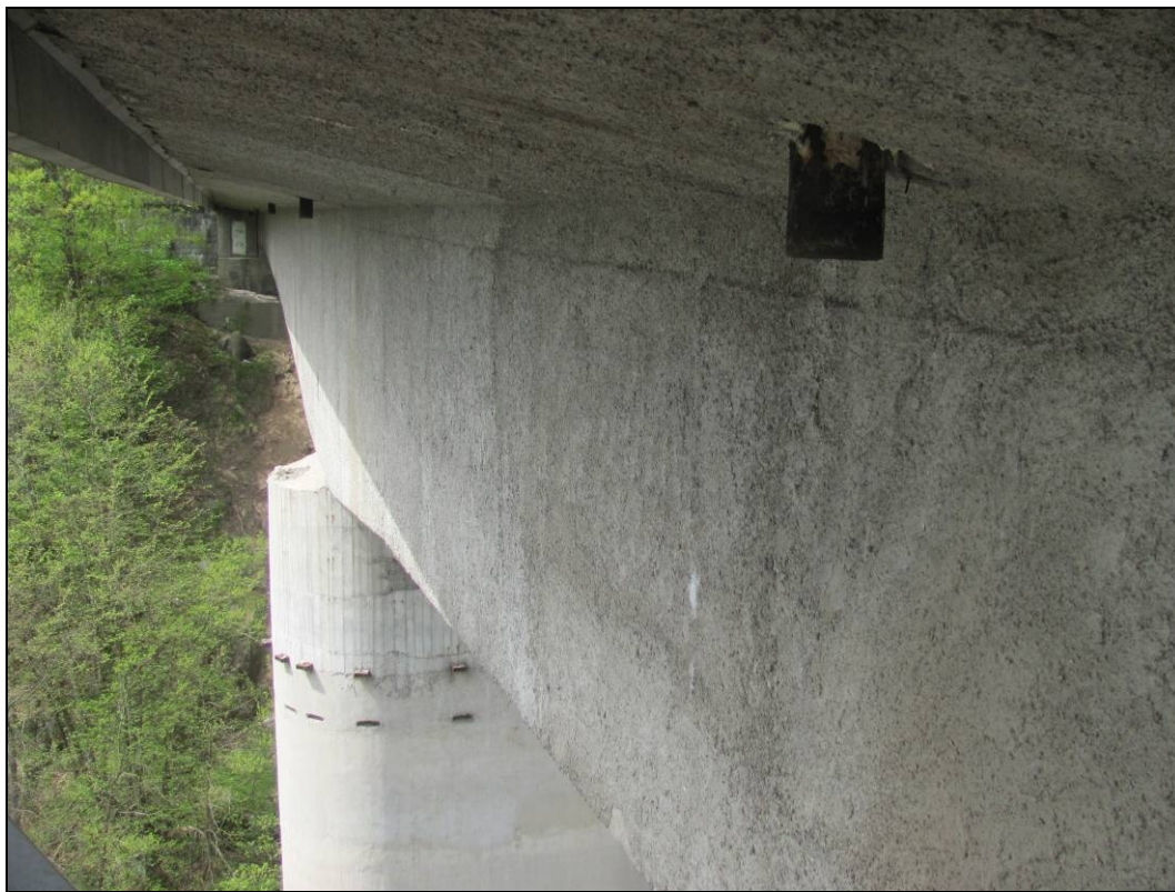
Foto 14: Návodní strana, pole 2. Návodní strana. Bok komor a spodní líc konzol plošně zakryt vrstvou torkretu.
