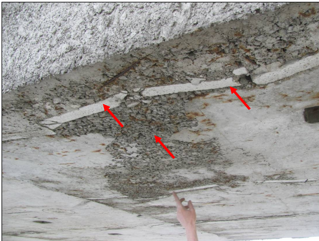
Foto 17: Na spodním líci komor, viditelná štěrková hnízda a místa a kde nebyl dostatečně ztuhl beton při výstavbě. Betonové distanční podložky (trámečky).
