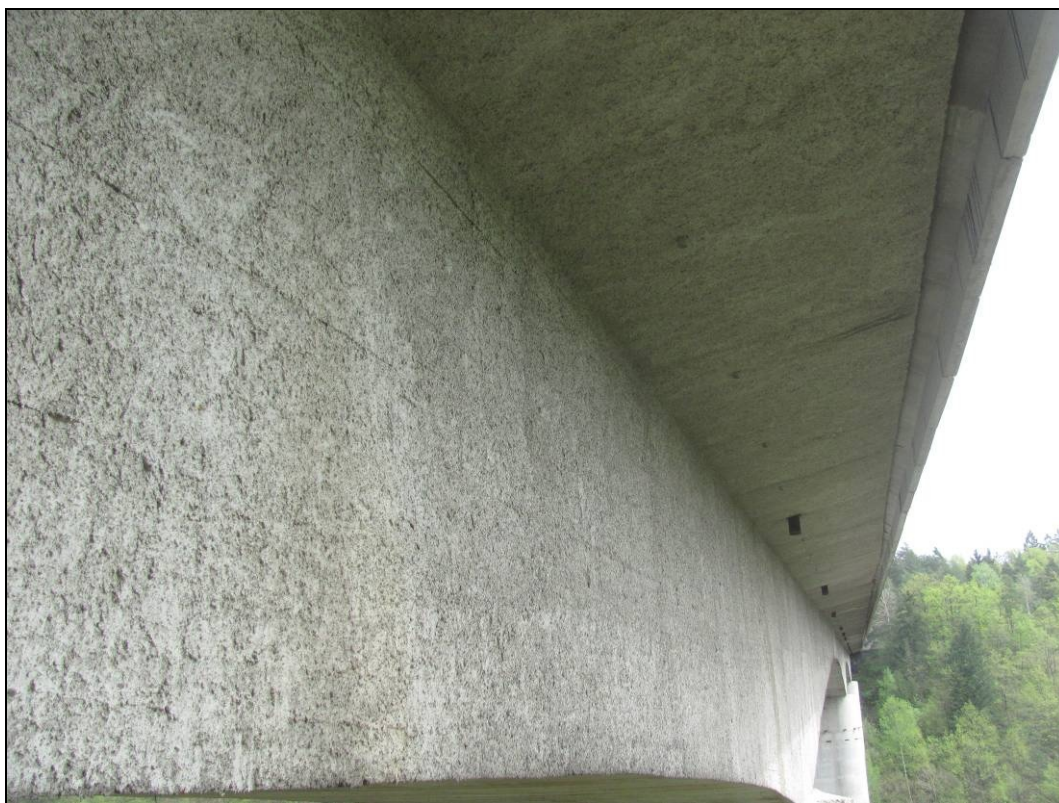
Foto 7: Pohled na bok komory v poli 1. Návodní strana. Bok komor a spodní líc konzol plošně zakryt vrstvou torkretu.
