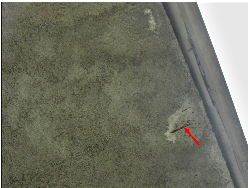
Foto 33: Na koncích konzol místa s odpadlou vrstvou torkretu. Odhalená výztuž vlivem odpadlé krycí vrstvy. Zde dochází k povrchové korozi výztuže.
