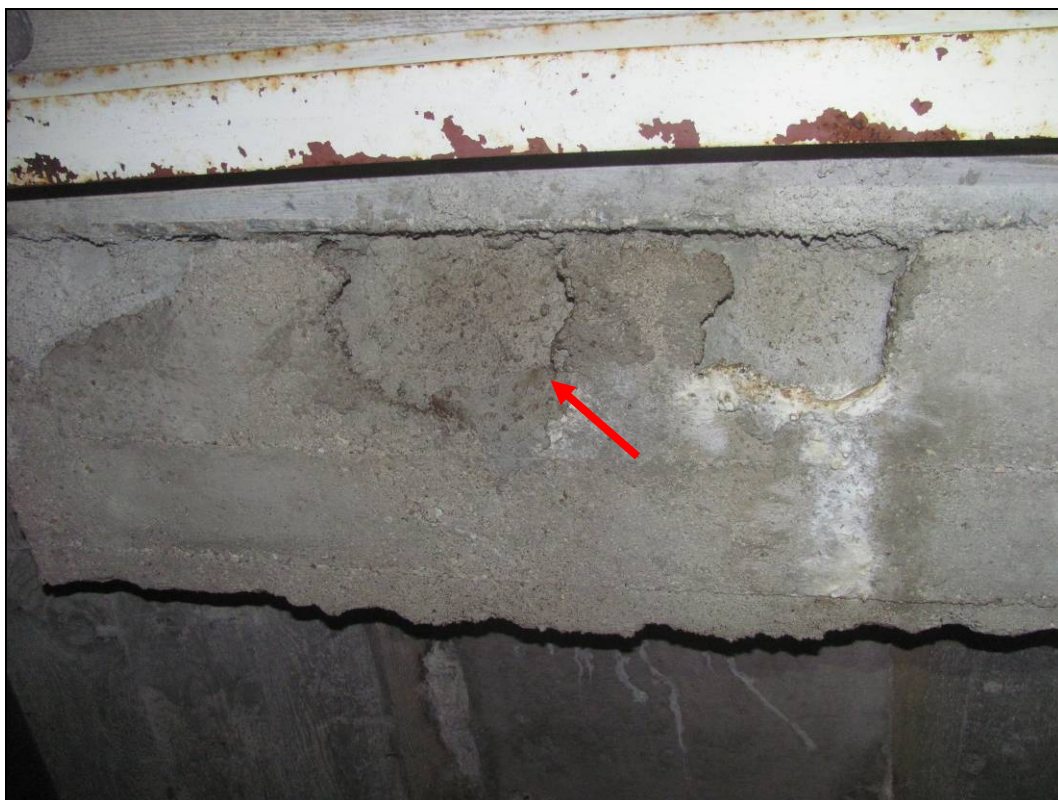
Foto 55: Nprobetonované kotvy v příčném kotevním prahu.
