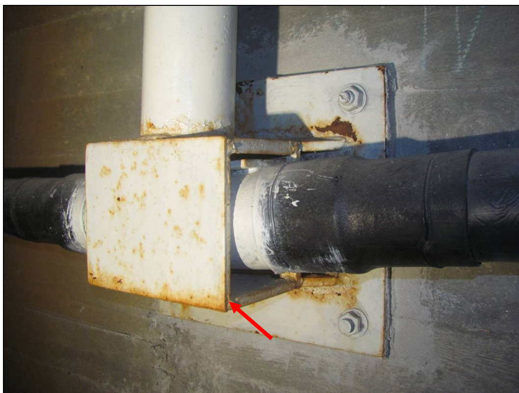
Foto 50: Detail lokální koroze deviátorů, degradace nátěru.
