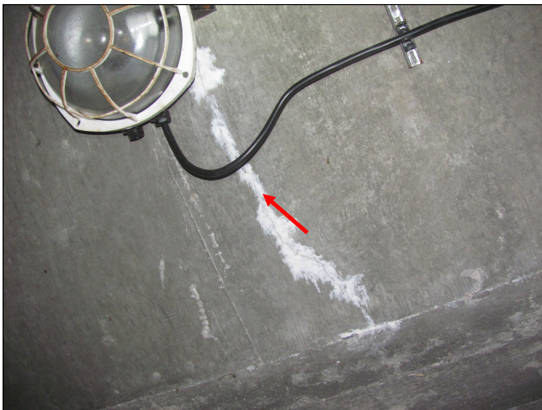
Foto 47: Detail trhliny šířky 0,05 – 0,15 mm v jednom z příčných kotevních prahů. Výluhy vlivem průsaků. V době prohlídky neaktivní.
