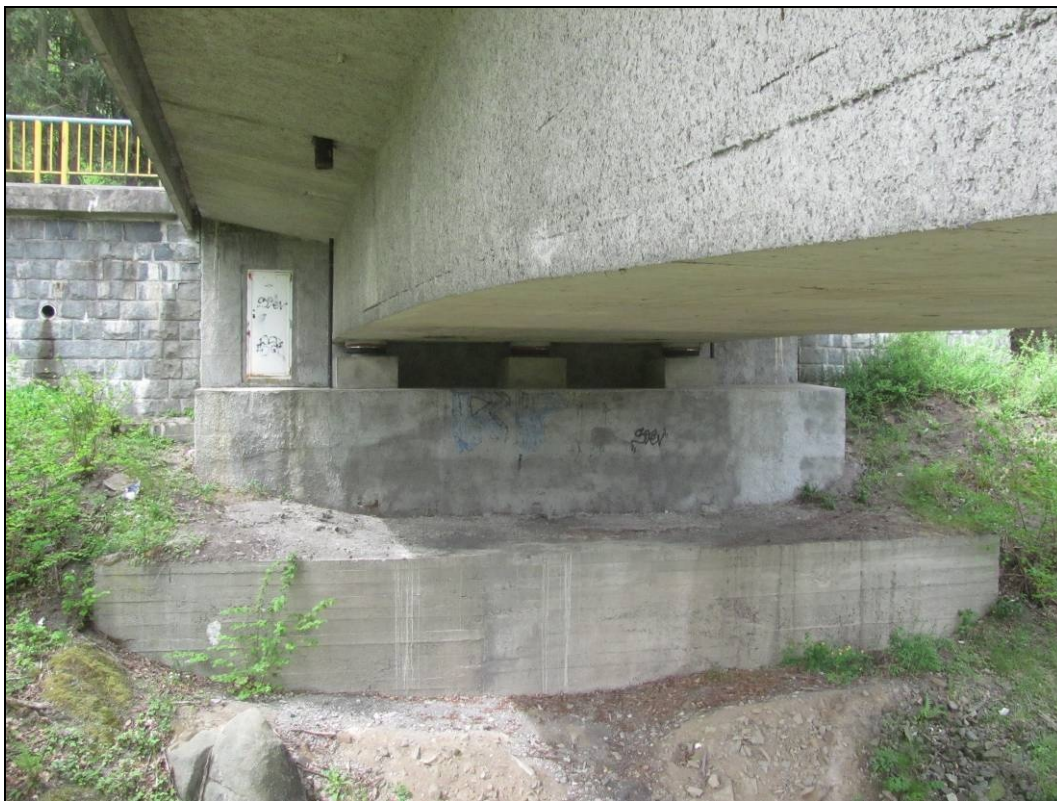
Foto 3: Celkový pohled na opěru OP1. Viditelné výluhy vlivem zatékání na čele opěry a na kamenných křídlech. V době prohlídky neaktivní.
