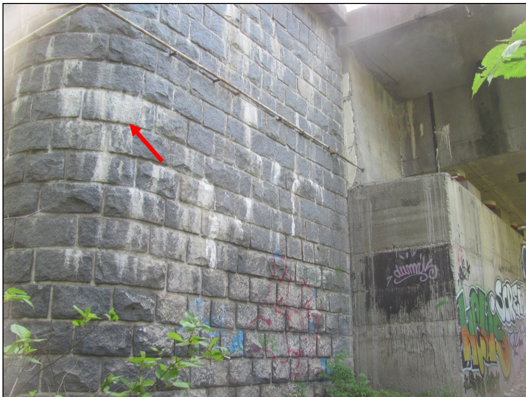
Foto 35: Detail křídla, povodní strana. Viditelné výluhy na kamenném zdivu.
