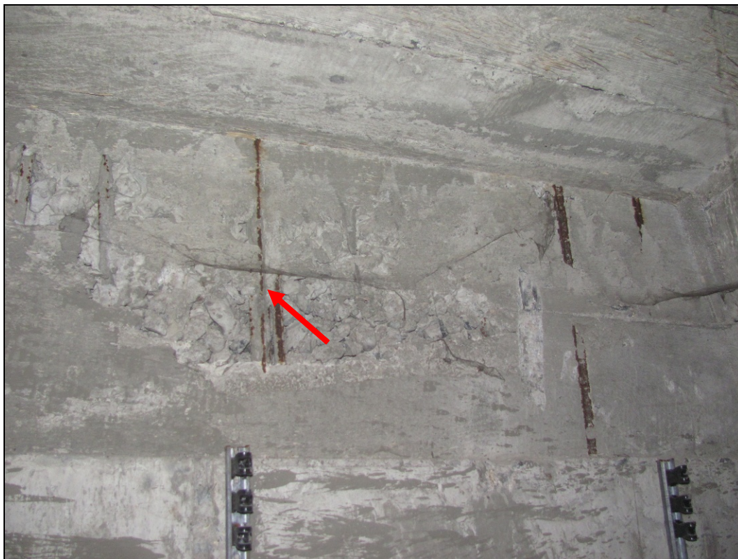
Foto 53: Detail štěrkových hnízd na boku komory. Povrchová korozí odhalené výztuže.
