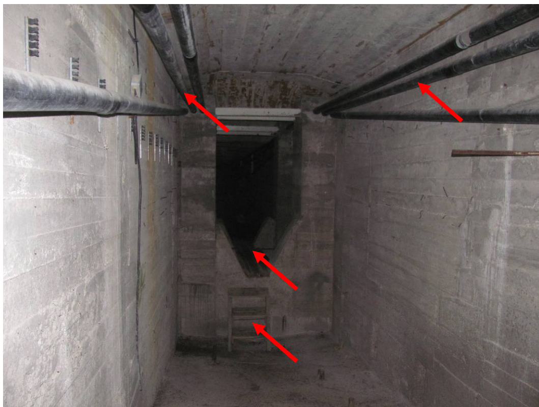
Foto 40: Detail interiéru komory 1. Viditelná volná předpínací lana. Nestabilní schodiště a lávky umožňující přechod mezi jednotlivými poli nad pilířem.
