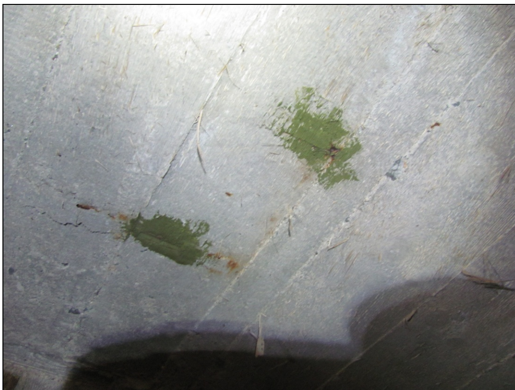
Foto 49: Interiér komory 2, lokálně viditelná koroze výztuže. Již opatřeno nátěrem.
