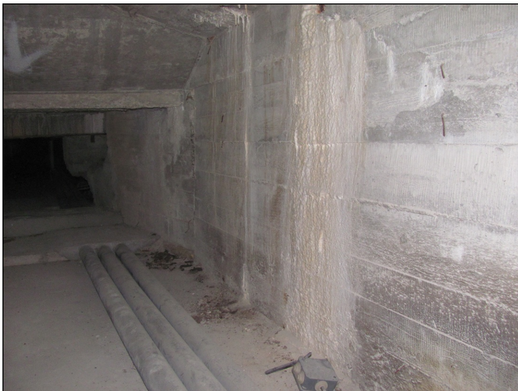
Foto 54: Výluhy způsobené zatékáním z vozovky. V době prohlídky neaktivní.
