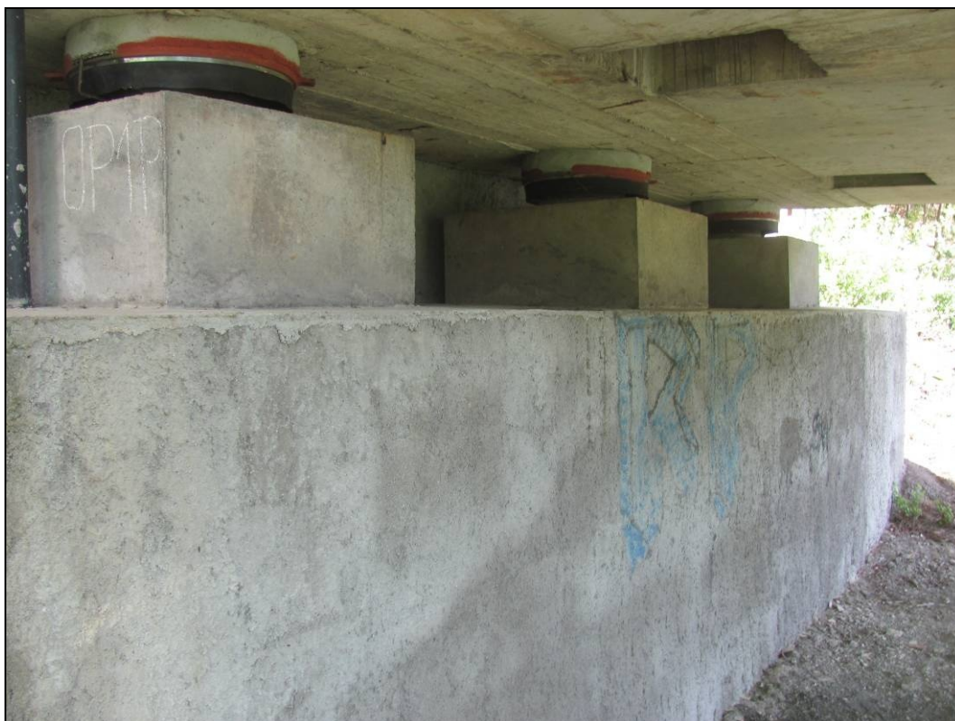
Foto 6: Pohled na tři hrncové ložiska (NGe 2,5MN) a táhlo.
