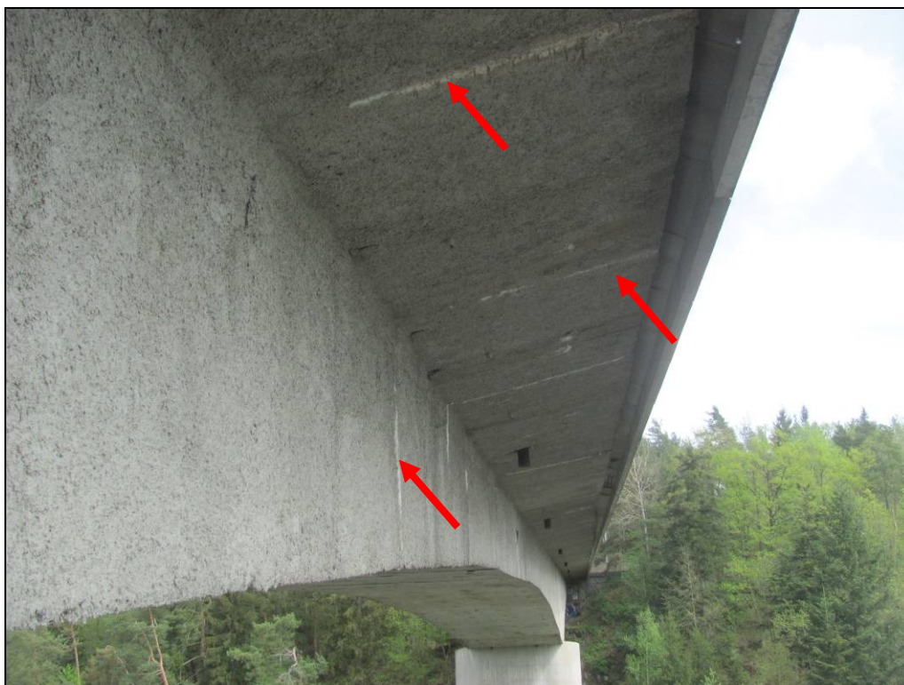
Foto 21: Návodní strana, pole 3. Bok komor a spodní líc konzol plošně zakryt vrstvou torkretu. Na spodním líci konzol místa s odpadlou vrstvou torkretu. Viditelné průsaky v místě pracovních spár.
