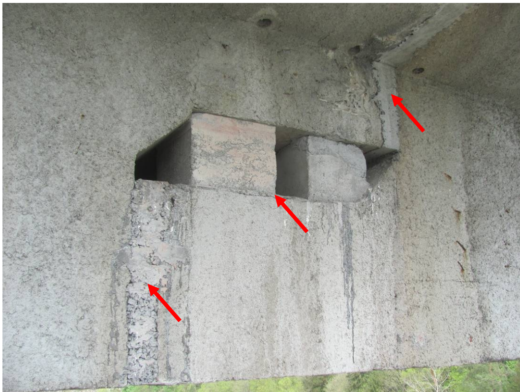
Foto 25: Návodní strana, pole 3. Detail zmonolitněného kloubu uprostřed rozpětí. Na površích nebyly nalezeny známky nějakého zjevného poškození, jako jsou např. trhliny, drcení betonu, nadměrné deformace.
