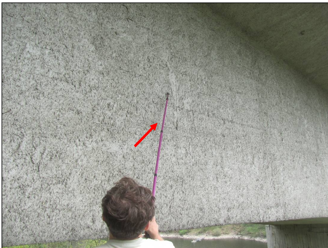
Foto 9: Detail provádění trasování pro zjištění soudržnosti vrstvy torkretu na betonovém podkladu.
