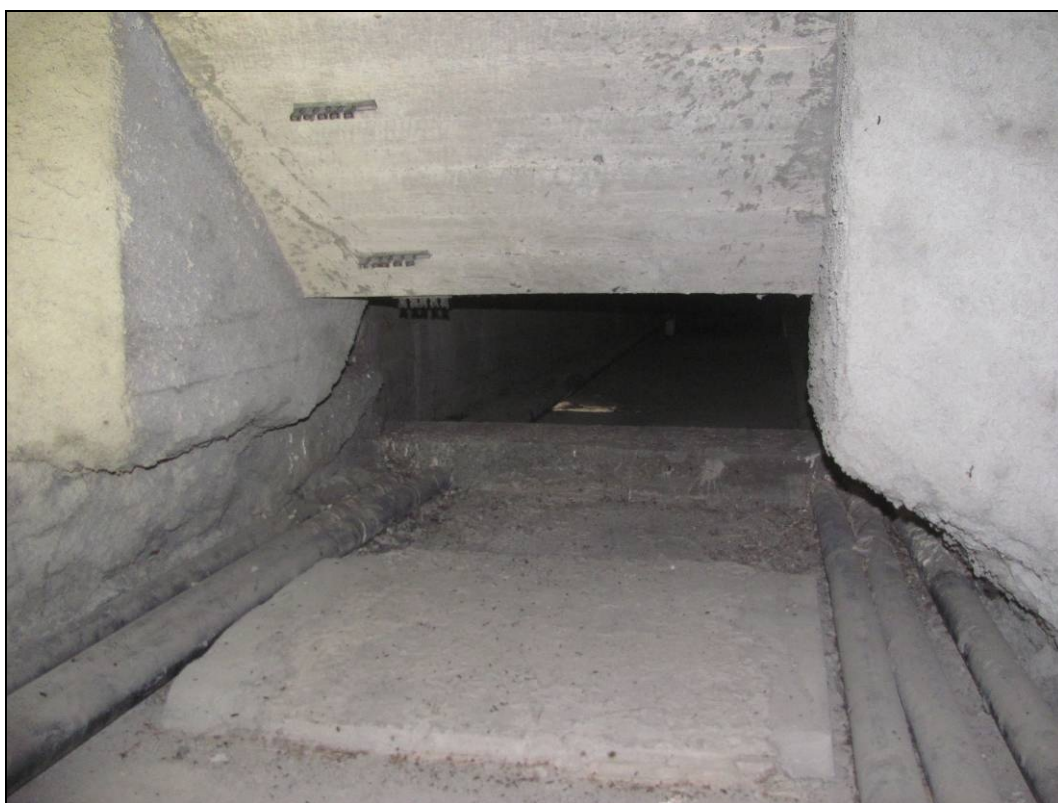
Foto 52: Detail zmonolitněného kloubu v poli 3.
