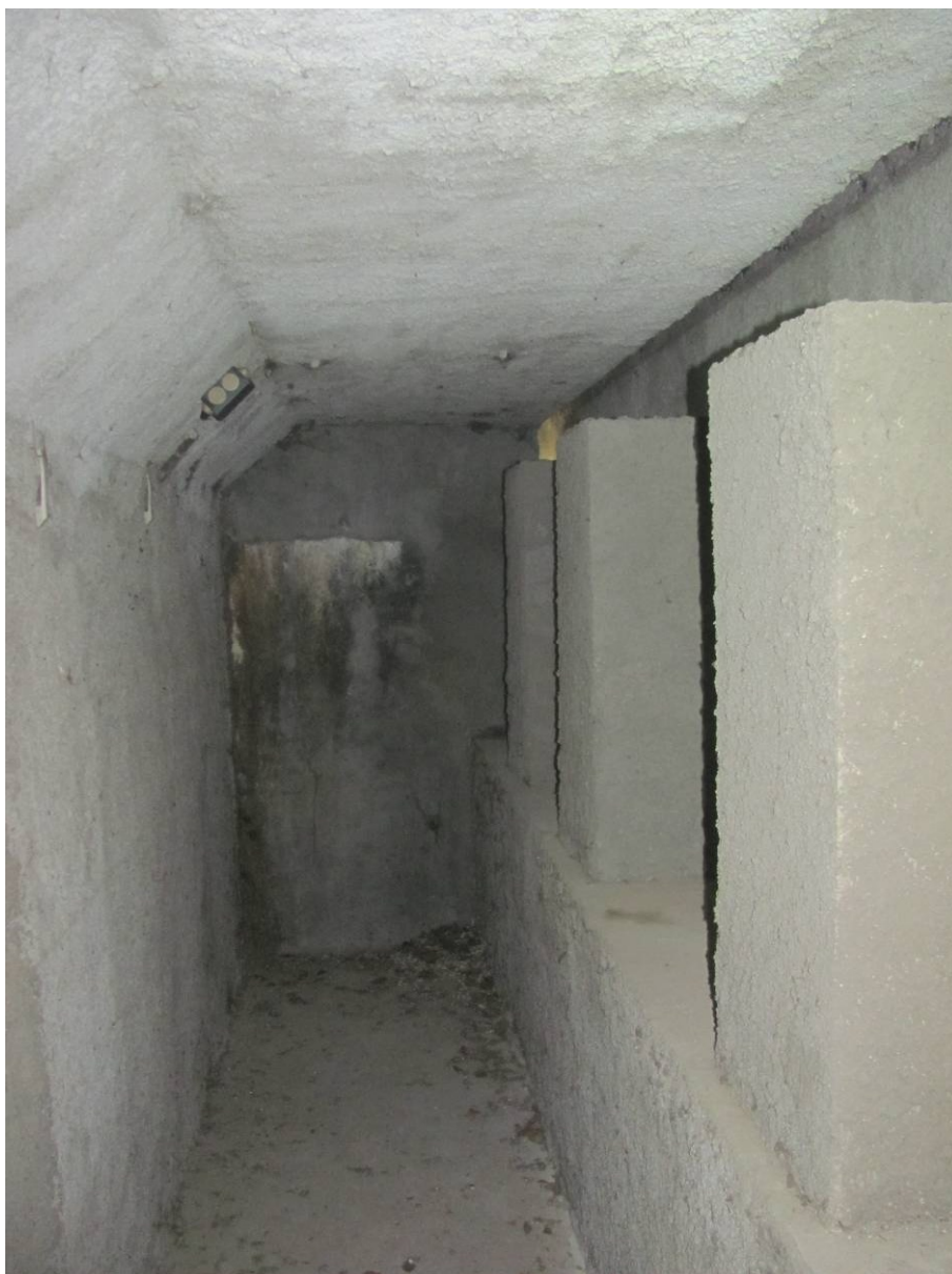
Foto 54: Pohled do komory pod mostním závěrem, Zvíkovské Podhradí. Lokální výluhy způsobené zatékáním. V době prohlídky neaktivní.
