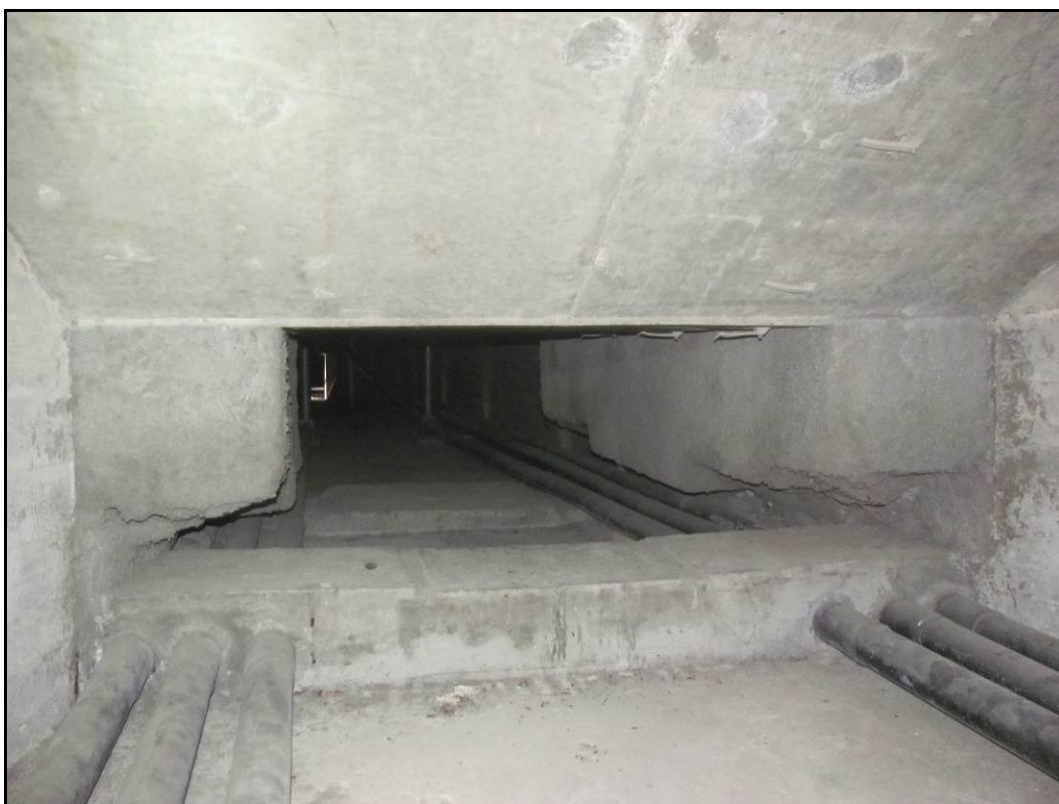
Foto 42: Detail zmonolitněného kloubu v poli 3.
