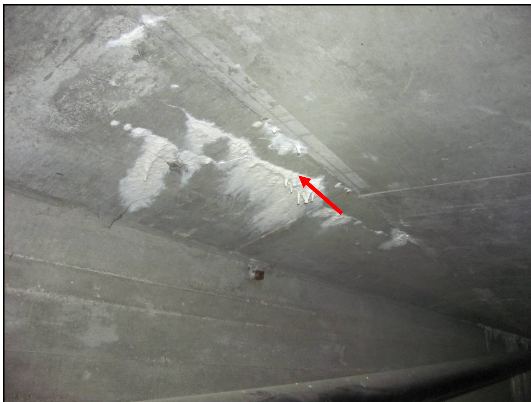
Foto 53: Na stropě komory výluhy v oblasti trhliny šířky 0,1 – 0,15 mm, tvorba výkvětů. V době prohlídky byly průsaky neaktivní.
