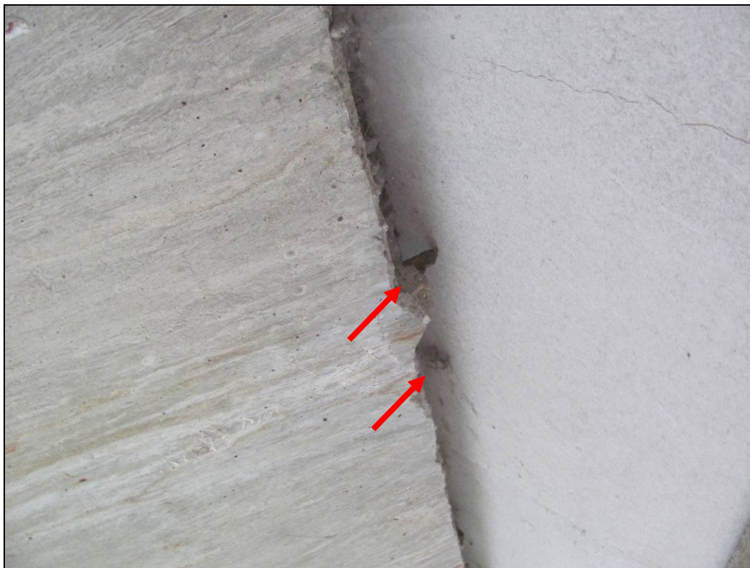
Foto 9: Detail konce konzoly. Odhalená výztuž, povrchová koroze.
