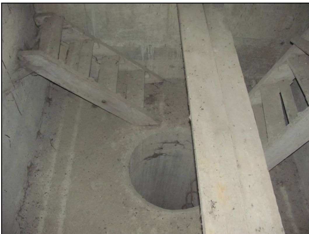
Foto 52: Nezajištěný vlez do pilře P4.
