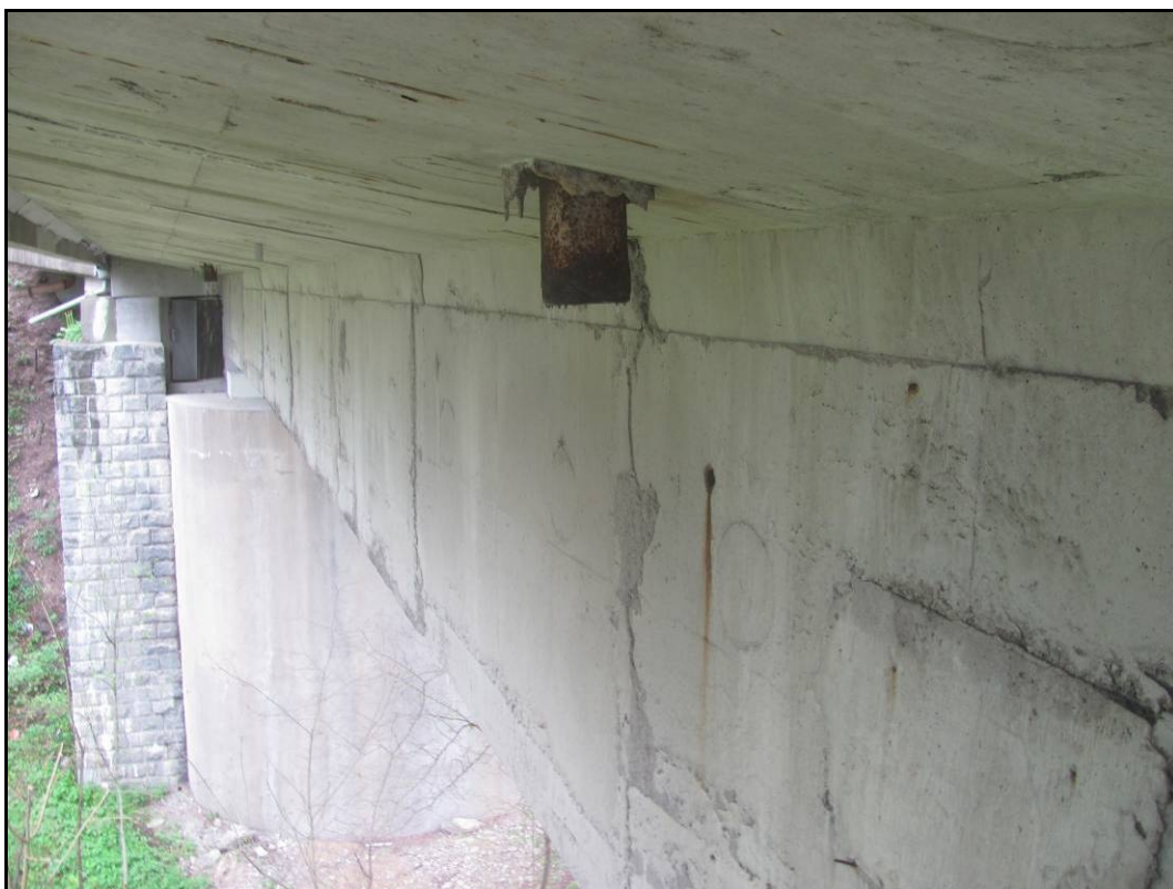
Foto 31: Povodní strana, pole 4. Nerovnosti vzniklé posunem/deformací bednění, svislé a vodorovné pracovní spáry.
