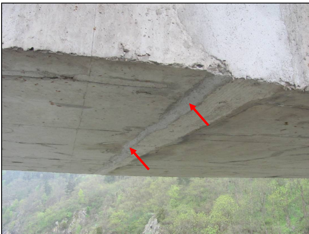
Foto 26: Pohled na spodní líc zmonolitného kloubu. Na površích nebyly nalezeny známky nějakého zjevného poškození.
