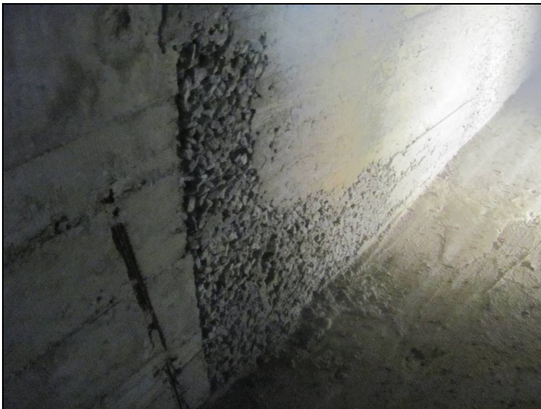
Foto 51: Detail štěrkových hnízd na boku vnitřku komory.
