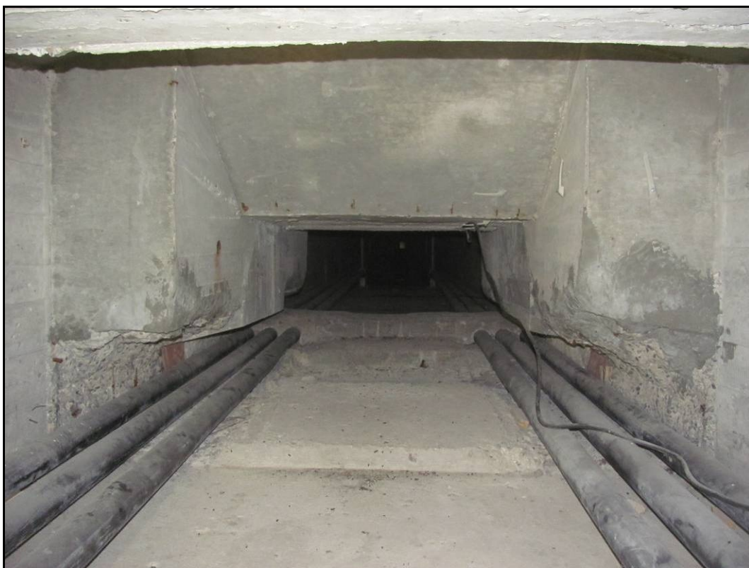
Foto 50: Detail zmonolitněného kloubu v poli 3.
