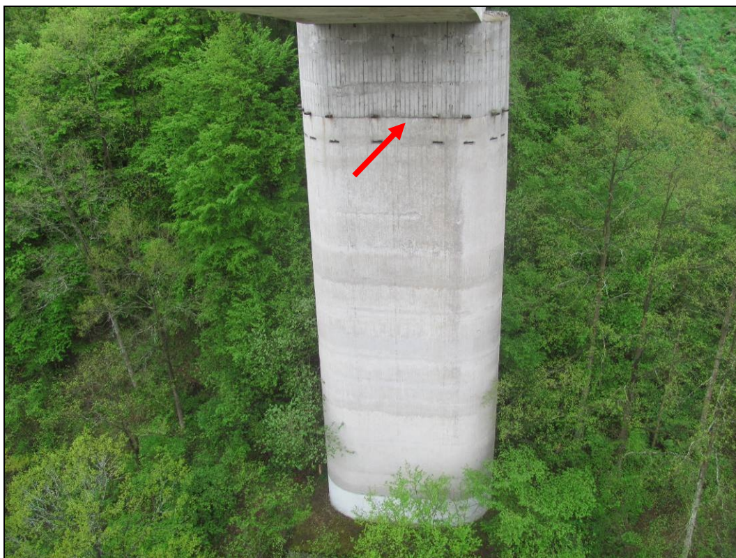
Foto 10: Pohled na pilíř P2. Viditelná pracovní spára. Koroze ocelových konzol, pravděpodobně sloužících k ukotvení pracovní lávky.
