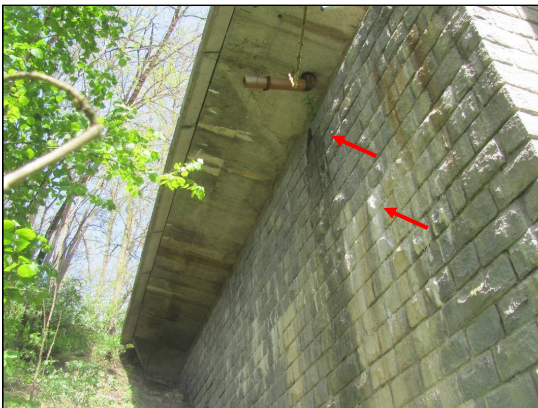
Foto 36: Detail křídla opěry, návodní strana. Zatékání vlivem nefunkčního odvodňovače a přes konzoly. Výkvěty na kamenném zdivu.
