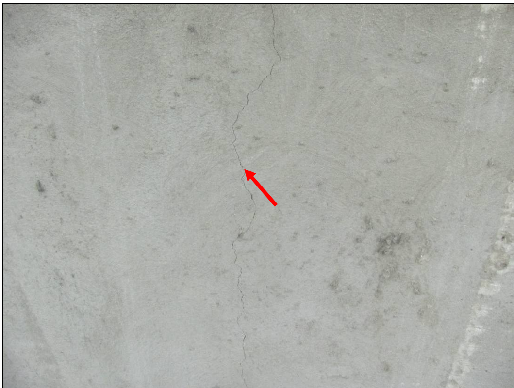
Foto 35: Detail svislé trhliny šířky 0,2 mm do výšky 2 m, od paty opěry.
