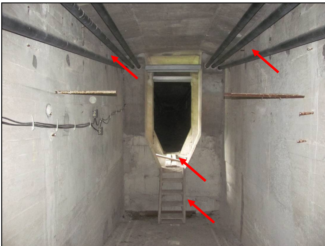
Foto 40: Detail interiéru komory 1. Viditelná volné předpínací kabely. Nestabilní schodiště a lávky umožňující přechod mezi jednotlivými poli nad pilířem.
