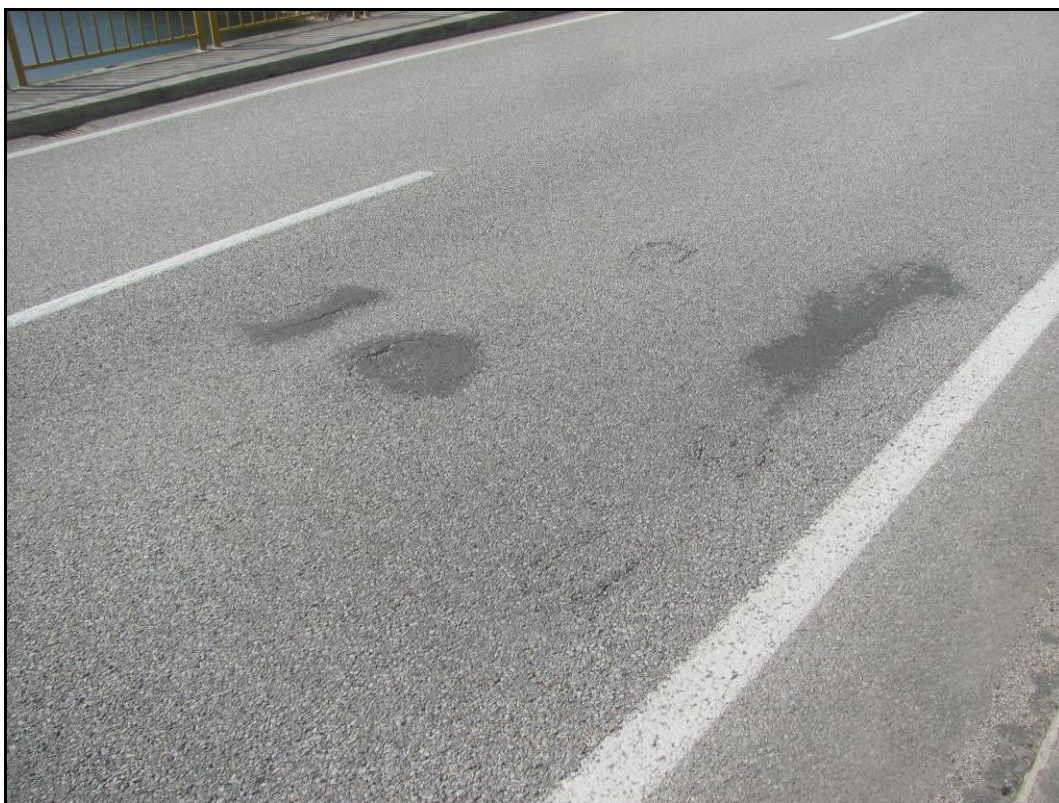
Foto 57: Lokální výtluky na vozovce v asfaltobetonové vrstvě.
