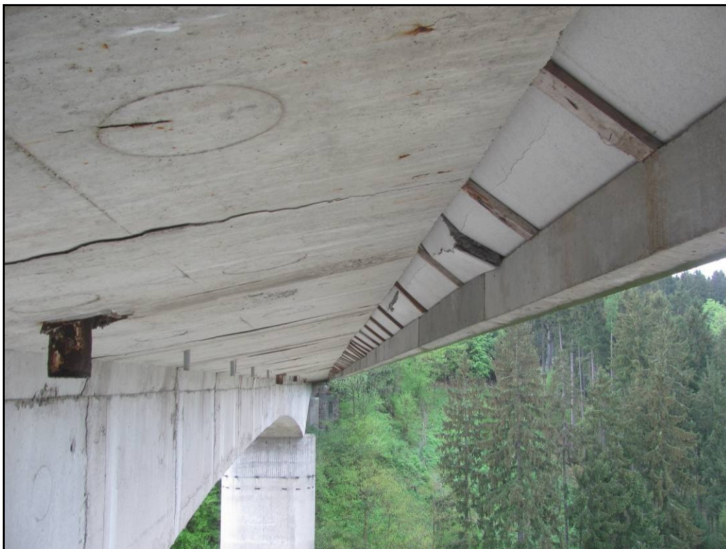
Foto 15: Povodní strana, pole 2. Nerovnosti vzniklé posunem/deformací bednění, svislé pracovní spáry. Korodující odvodňovač.
