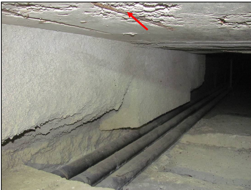
Foto 49: Detail zmonolitněného kloubu v poli 2, viditelná štěrková hnízda v podhledu. Obnažená betonářská výztuž, povrchová koroze.
