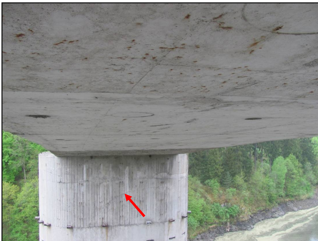
Foto 20: Detail hlavy pilíře P3, viditelná šikmá trhlina či pravděpodobně pracovní spára.
