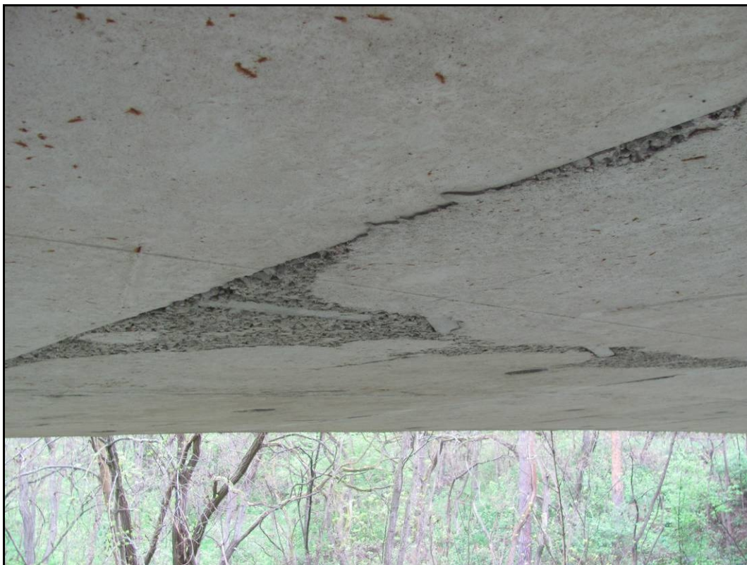
Foto 33: Na dolní hraně komory je nedohutněné místo nebo spíš odtok cementového mléka s odhaleným hrubým kamenivem.
