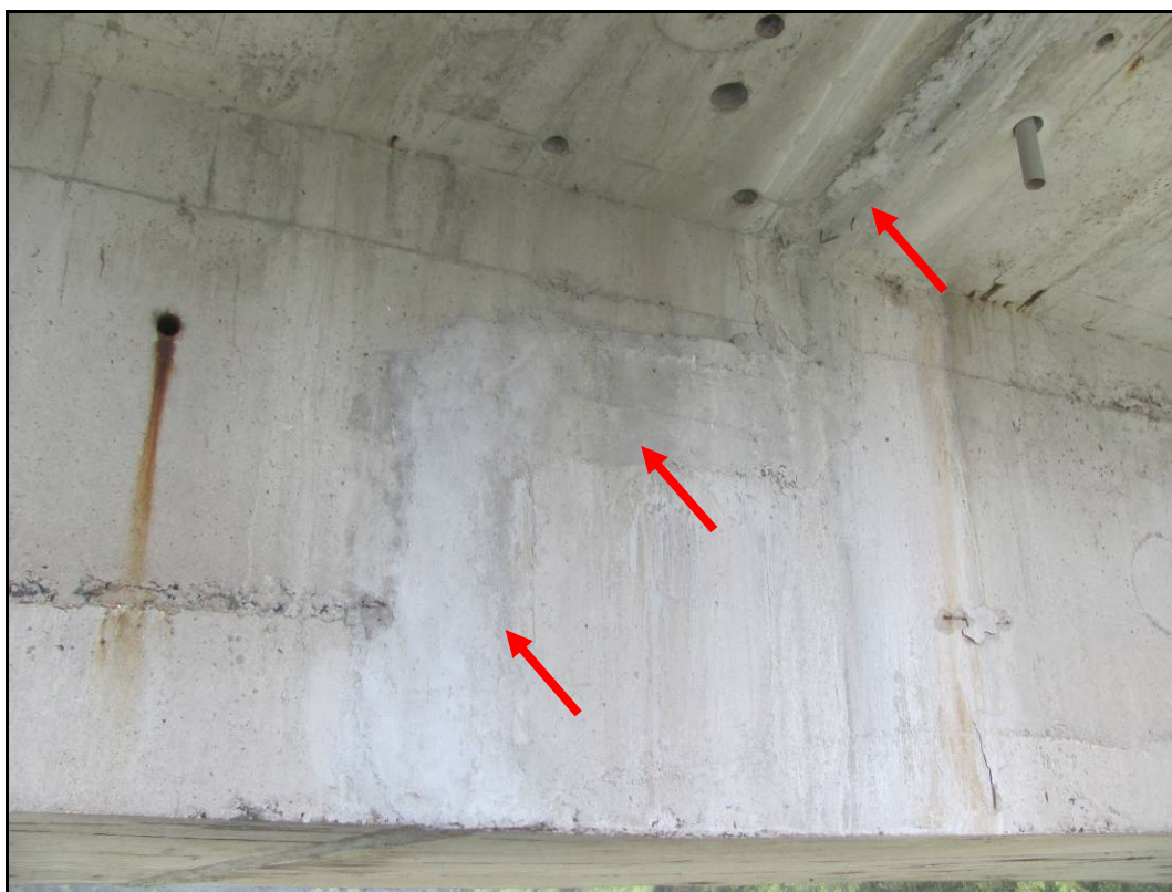
Foto 16: Povodní strana, pole 2. Detail zmonolitněného kloubu uprostřed rozpětí. Na površích nebyly nalezeny známky nějakého zjevného poškození.
