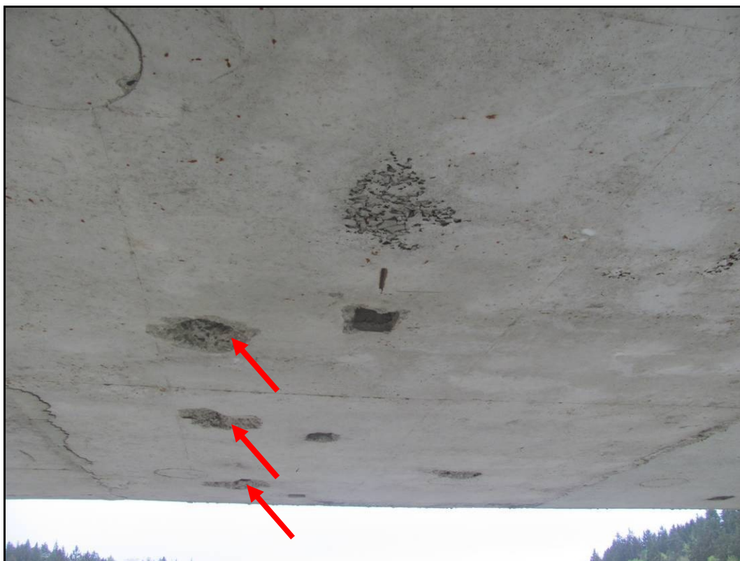
Foto 17: Na spodním líci komor, několik dodatečně vybouraných otvorů. Viditelná štěrková hnízda.
