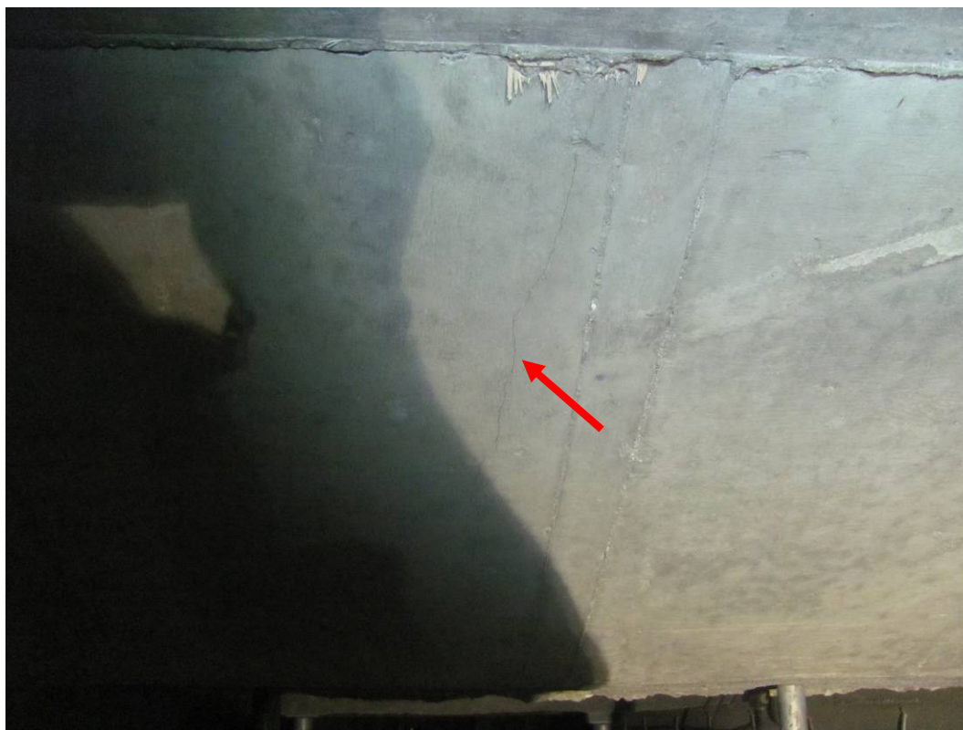
Foto 45: Detail trhliny šířky 0,05 – 0,15 mm v jednom z příčných kotevních prahů.
