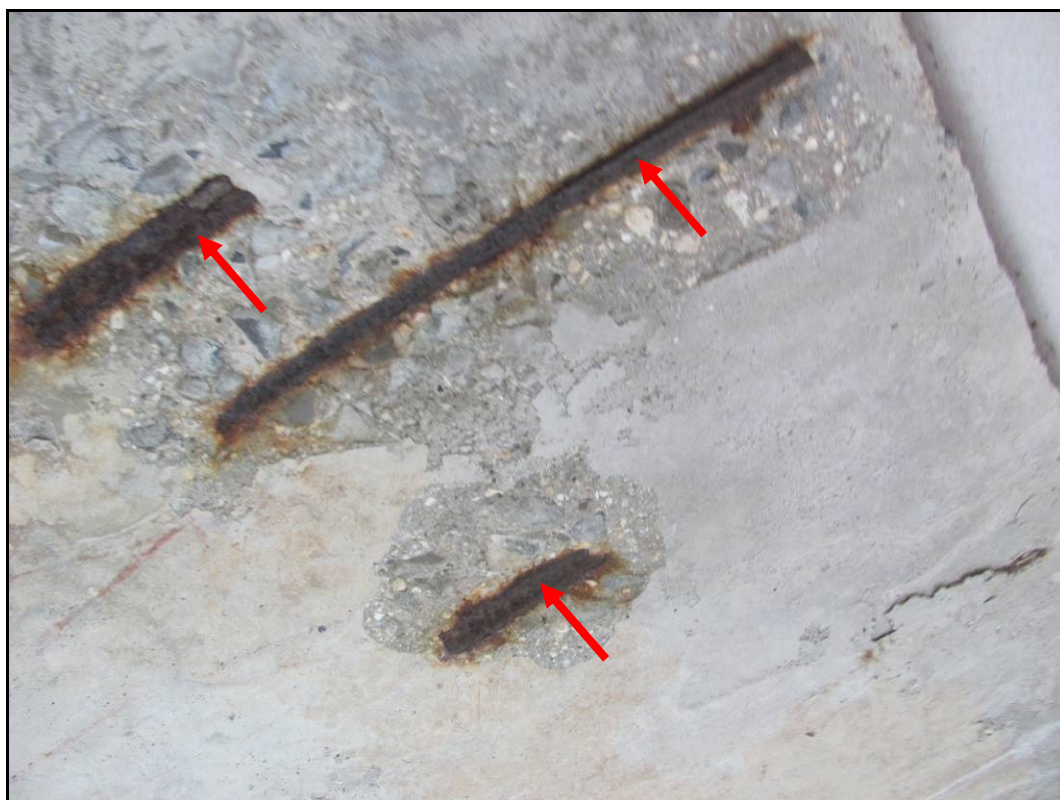
Foto 18: Na koncích konzol odhalená výztuž. Zde dochází k povrchové až silné korozi výztuže.
