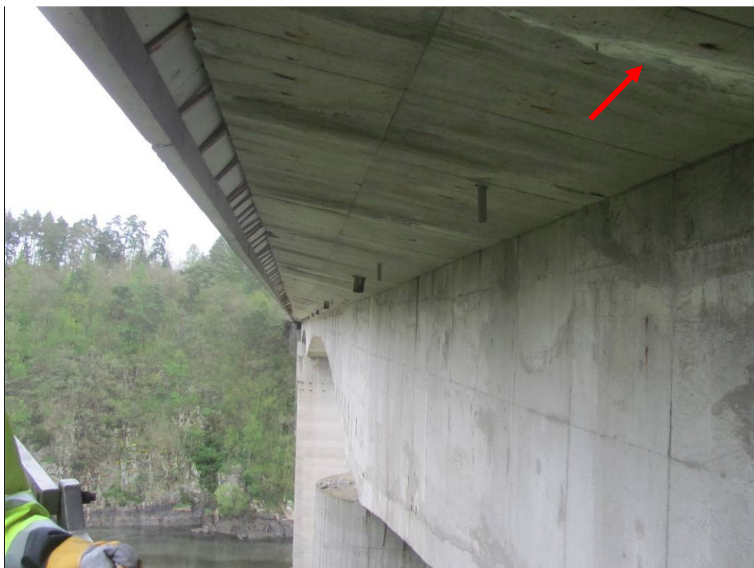
Foto 8: Pohled na bok komory v poli 1. Povodní strana. Viditelné výluhy způsobené zatékáním v oblasti pracovní spáry na spodním líci konzoly.
