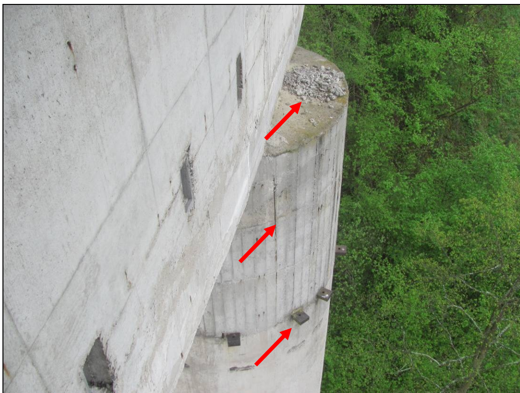
Foto 11: Pohled na Píleň 2. Ponechaný vybouraný materiál na horním líci. Lokální povrchová koroze výztuže. Koroze ocelových konzol, pravděpodobně sloužících k ukotvení pracovní lávky.
