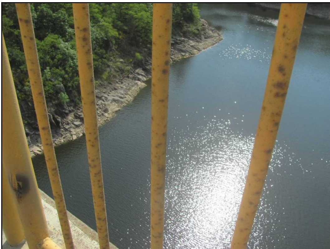
Foto 59: Detail degradace nátěru zábradlí a jeho povrchová koroze.
