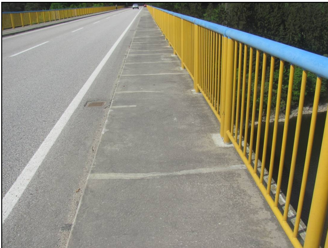
Foto 58: Detail zálivek podél a na chodnících, místy lokálně netěsné, dochází k zatékání na římsy.
