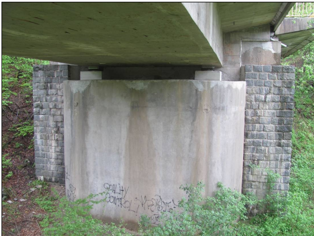
Foto 3: Celkový pohled na opěru OP1. Viditelné výluhy vlivem zatékání na čele opěry.
