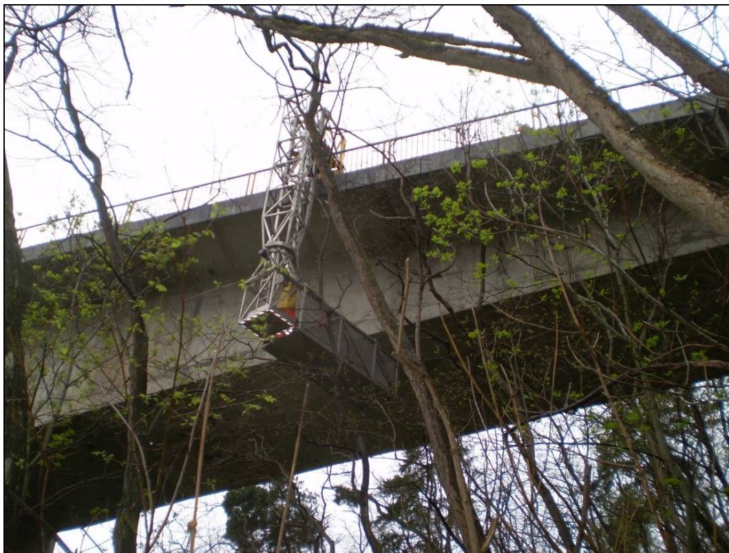
Foto 60: Prohlízkací souprava a náletové dřeviny bránící pojezdu prohlídkové kabiny.
