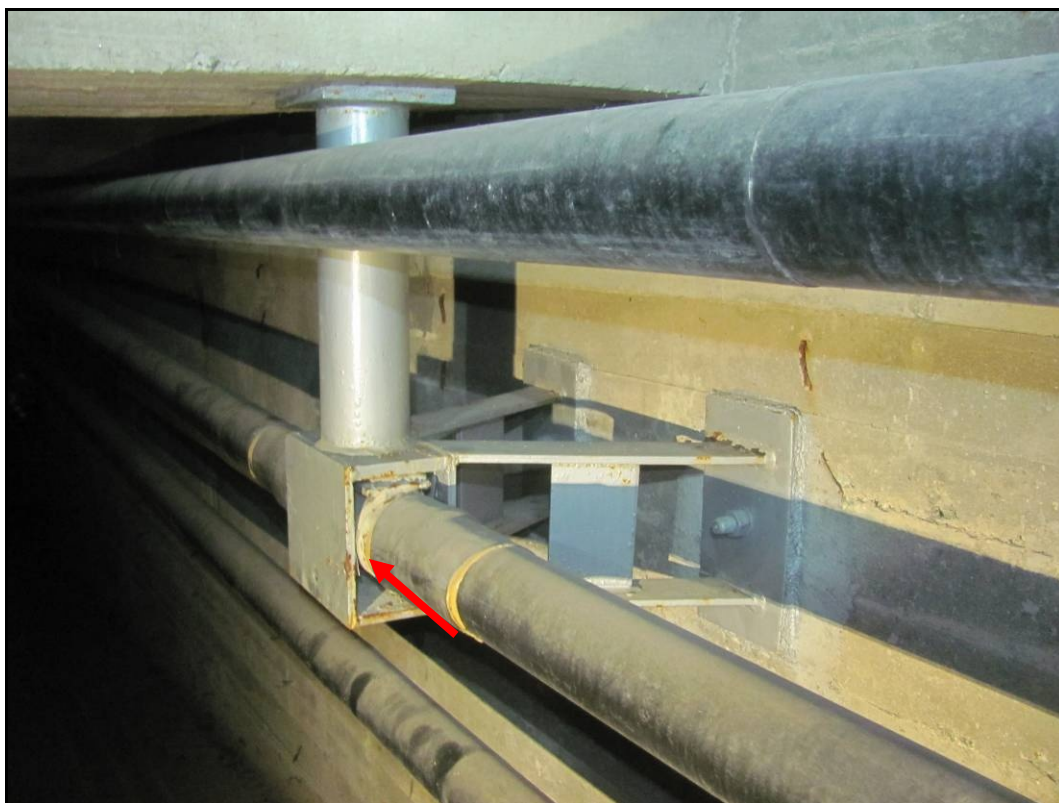
Foto 48: Detail lokální koroze deviátorů.
