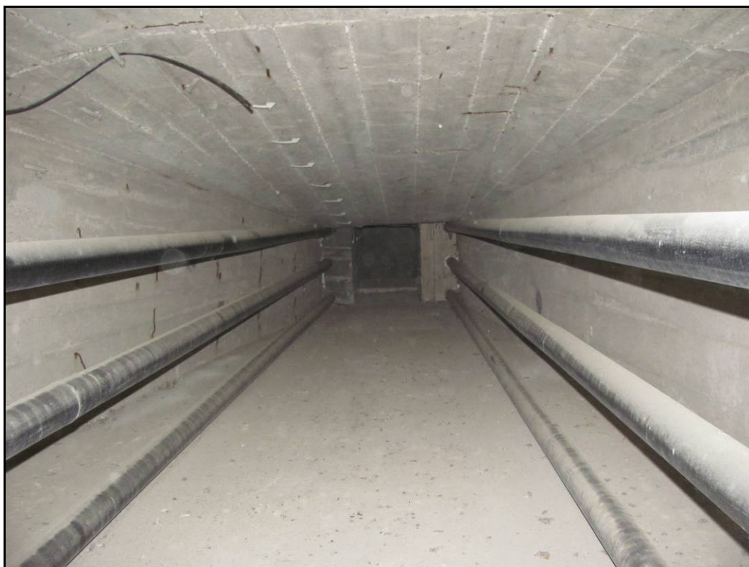
Foto 47: Uvnitř komory 2, lokálně viditelná koroze betonářské výztuže.
