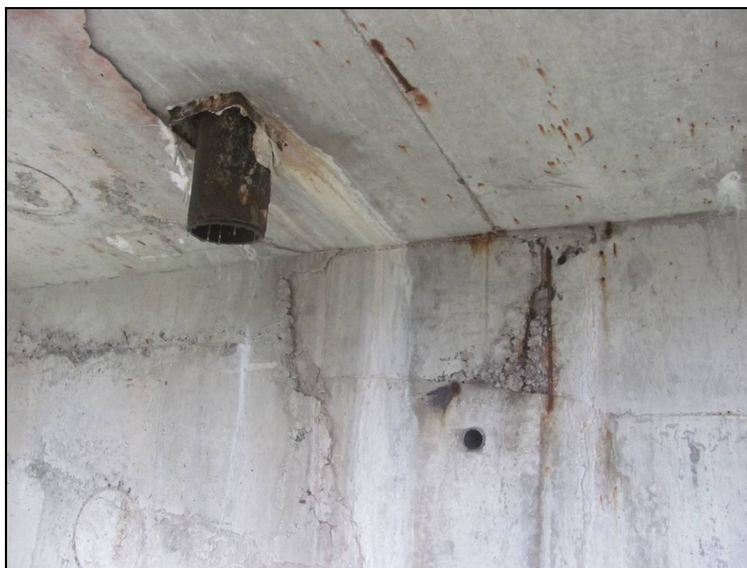
Foto 24: Nerovnosti vzniklé posunem/deformací bednění, svislé pracovní spáry. Výkvěty v oblasti těchto spár a kolem odvodňovače. Nedohutněné místo nebo spíše odtok cementového mléka s odhaleným hrubým kamenivem.
