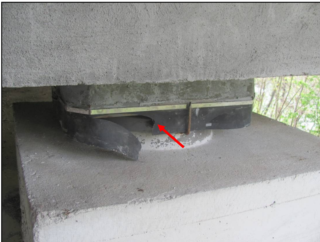
Foto 37: Pohled na jedno ze dvou hrncových ložisek (NGe 2,5MN). Špatně čitelný ukazatel posunu ložiska a roztržený ochranný pás.
