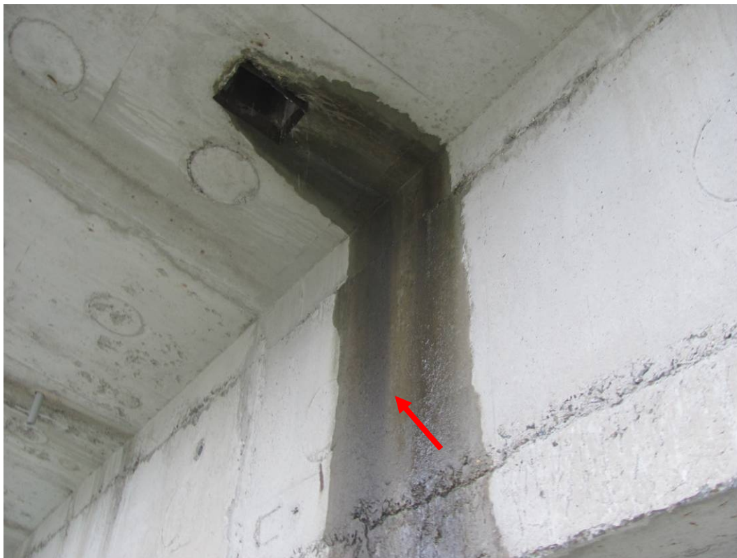
Foto 23: Nefunkční odvodňovač, zatékání na bok komory. Povodní strana.
