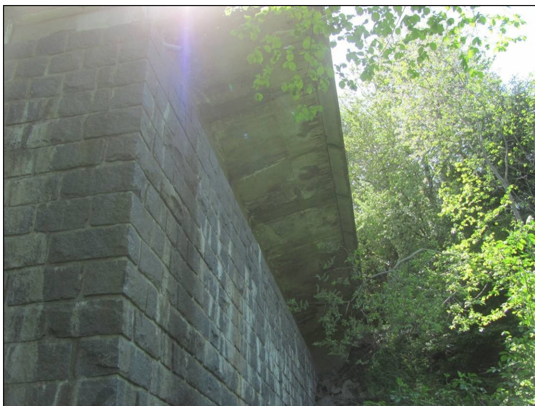
Foto 4: Pohled na kamenné křídlo opěry (levá strana ve směru staničení), viditelné výluhy vlivem zatékání.
