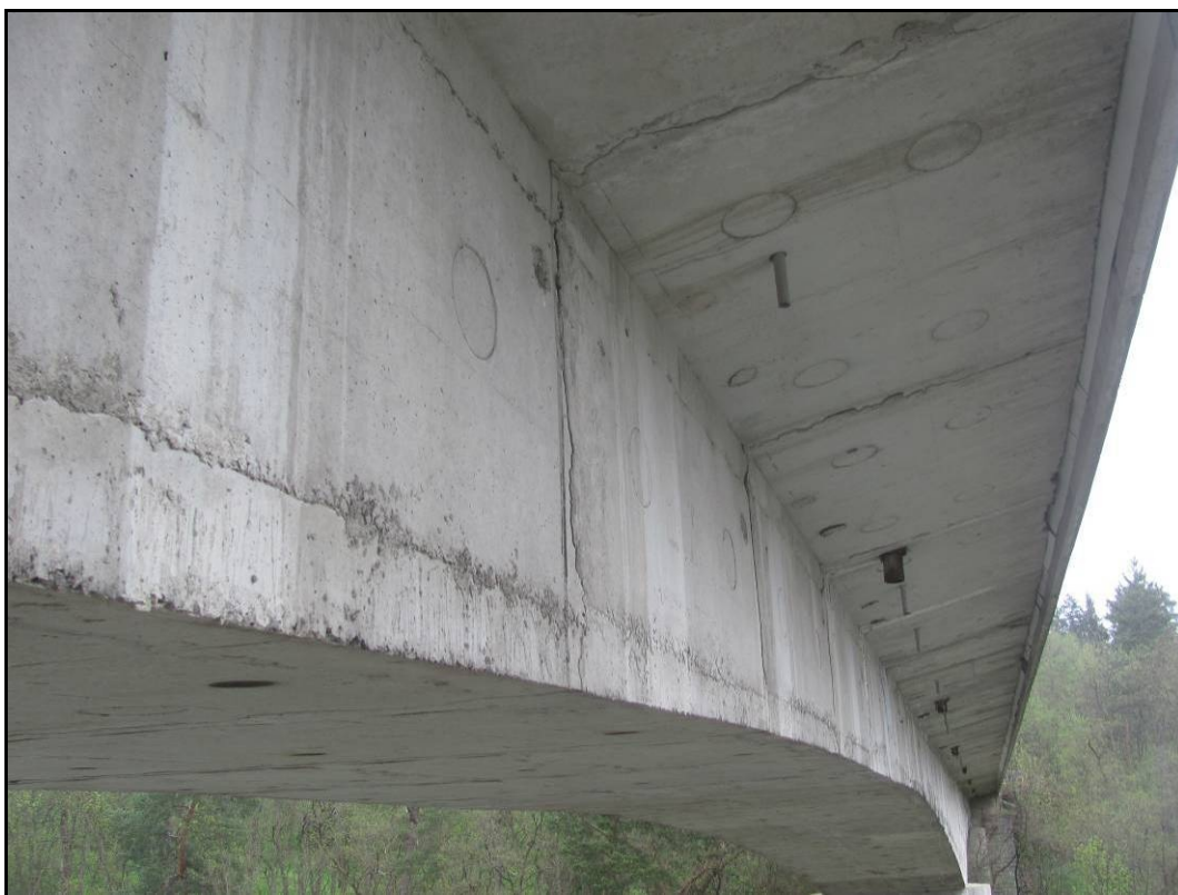
Foto 21: Návodní strana, pole 3. Nerovnosti vzniklé posunem/deformací bednění, svislé a vodorovné pracovní spáry.
