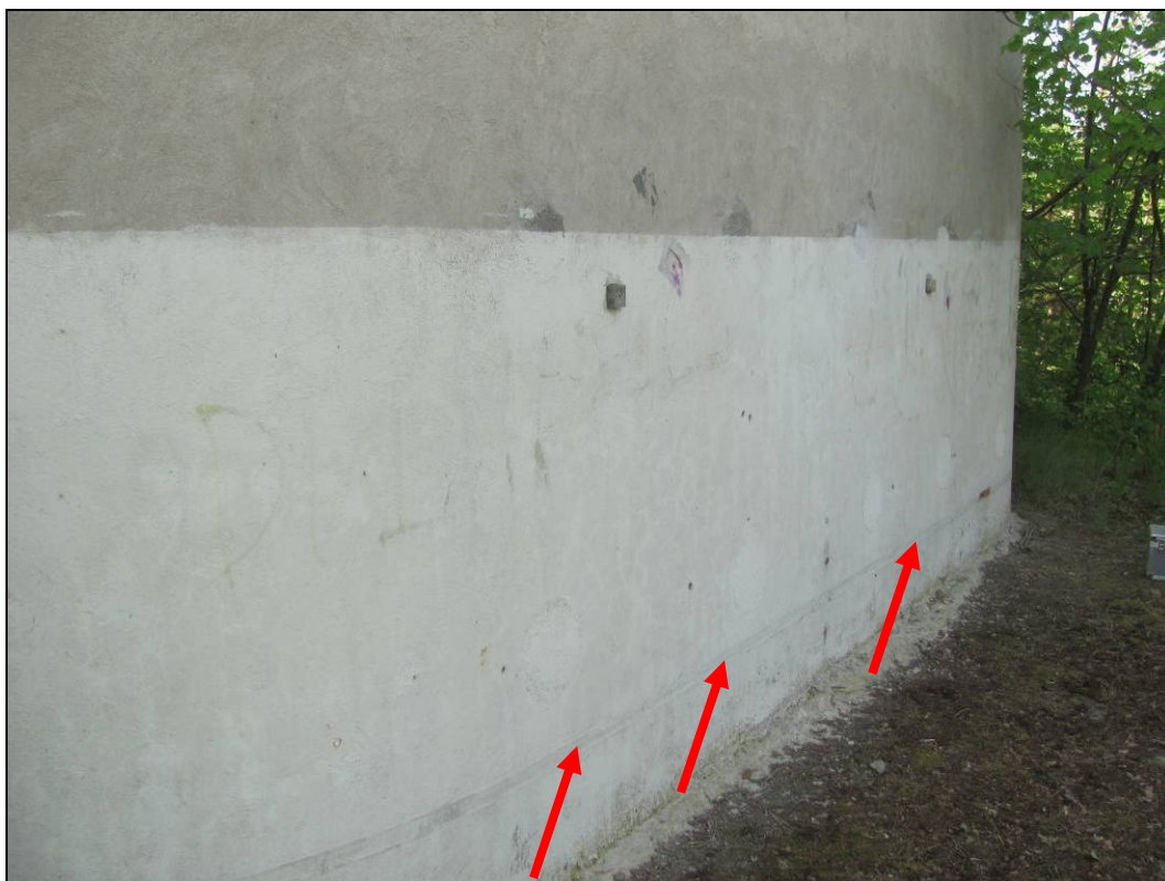
Foto 13: Pata pilíře. Viditelná spára po podřezání, vyplněná tmelem.
