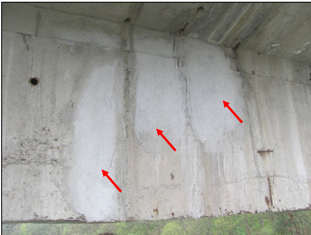
Foto 25: Návodní strana, pole 3. Detail zmonolitného kloubu uprostřed rozpětí. Na površích nebyly nalezeny známky nějakého zjevného poškození.
