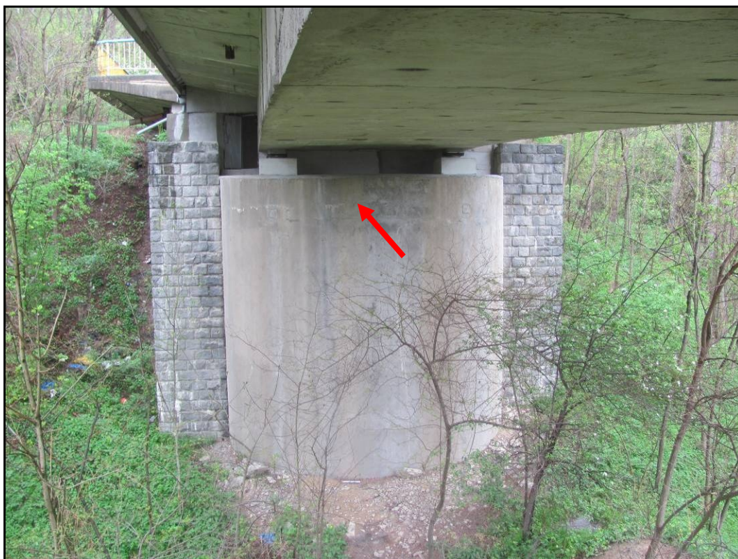
Foto 34: Celkový pohled na opěru OP5. Viditelné výluhy po zatékání na čele opěry. Zejména pod spárou úložného prahu. V době prohlídky neaktivní
