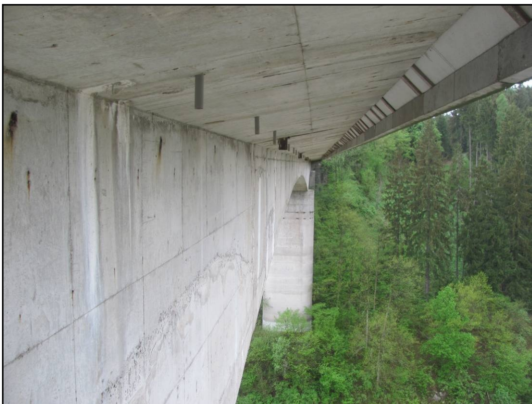
Foto 22: Povodní strana, pole 3. Nerovnosti vzniklé posunem/deformací bednění, svislé a vodorovné pracovní spáry. Výkvěty v oblasti těchto spár.
