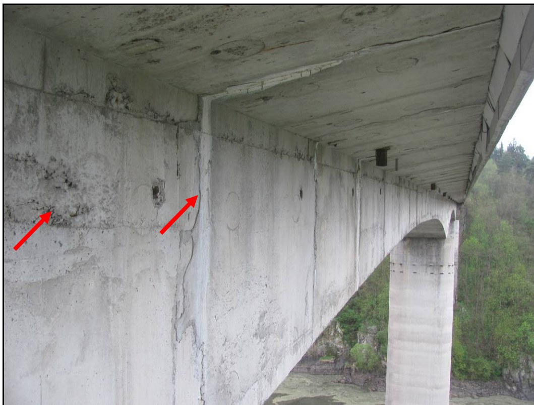
Foto 14: Návodní strana, pole 2. Nerovnosti vzniklé posunem/deformací bednění, svislá pracovní spára, kolem ní je výtok cementového mléka. Štěrková hnízda.
