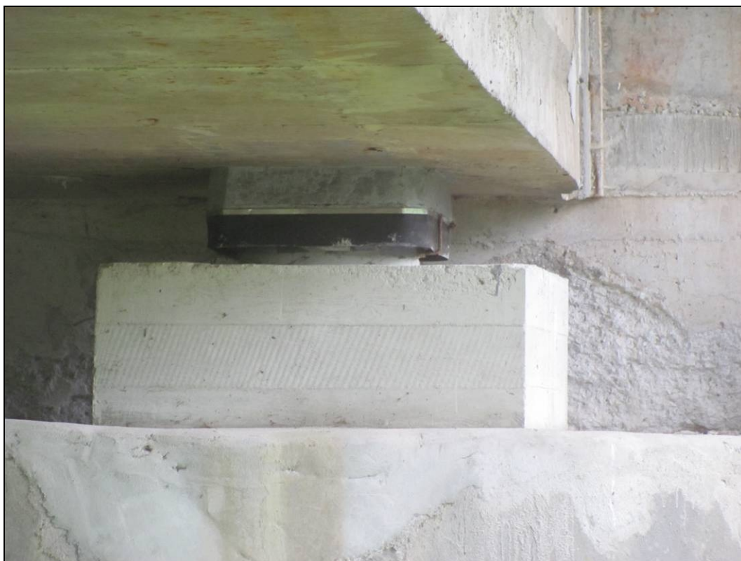
Foto 6: Pohled na jedno ze dvou hrncových ložisek (NGe 2,5MN). U závěrné zídky v prostoru za ložisky dochází k opadávání omítky.
