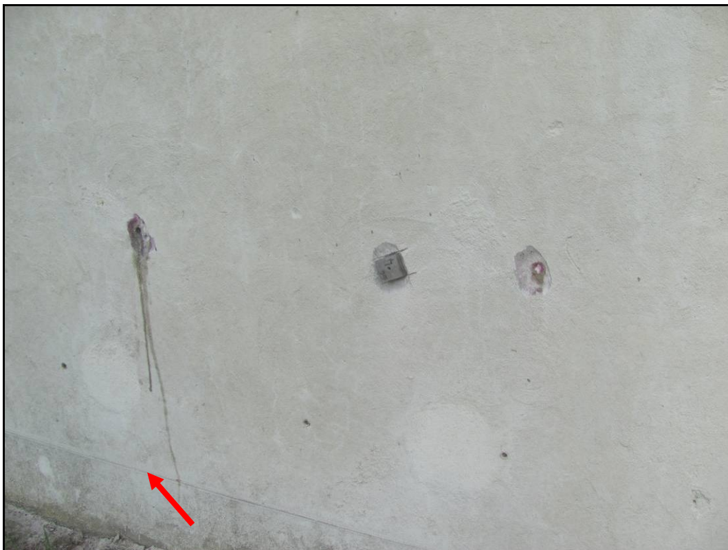
Foto 29: Detail prováděných zkoušek u paty pilíře, viditelná zatmelená spára po podřezání.
