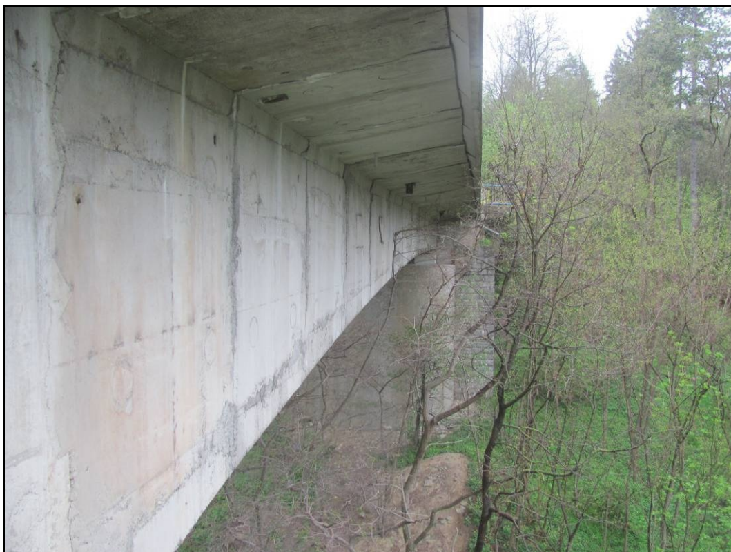
Foto 30: Návodní strana, pole 4. Nerovnosti vzniklé posunem/deformací bednění, svislé a vodorovné pracovní spáry.
