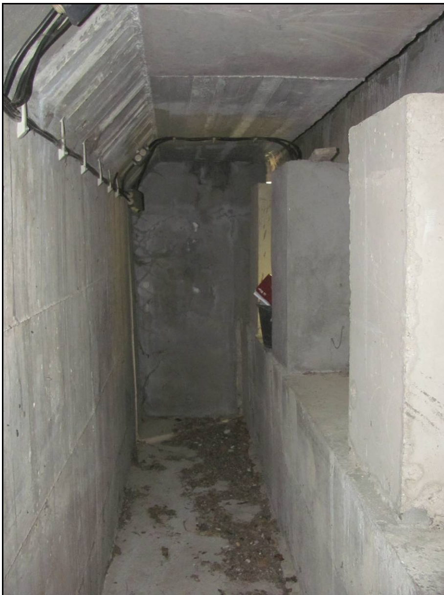
Foto 55: Pohled do komory pod mostním závěrem, Kučeř. Lokální výluhy způsobené zatékáním. V době prohlídky neaktivní.
