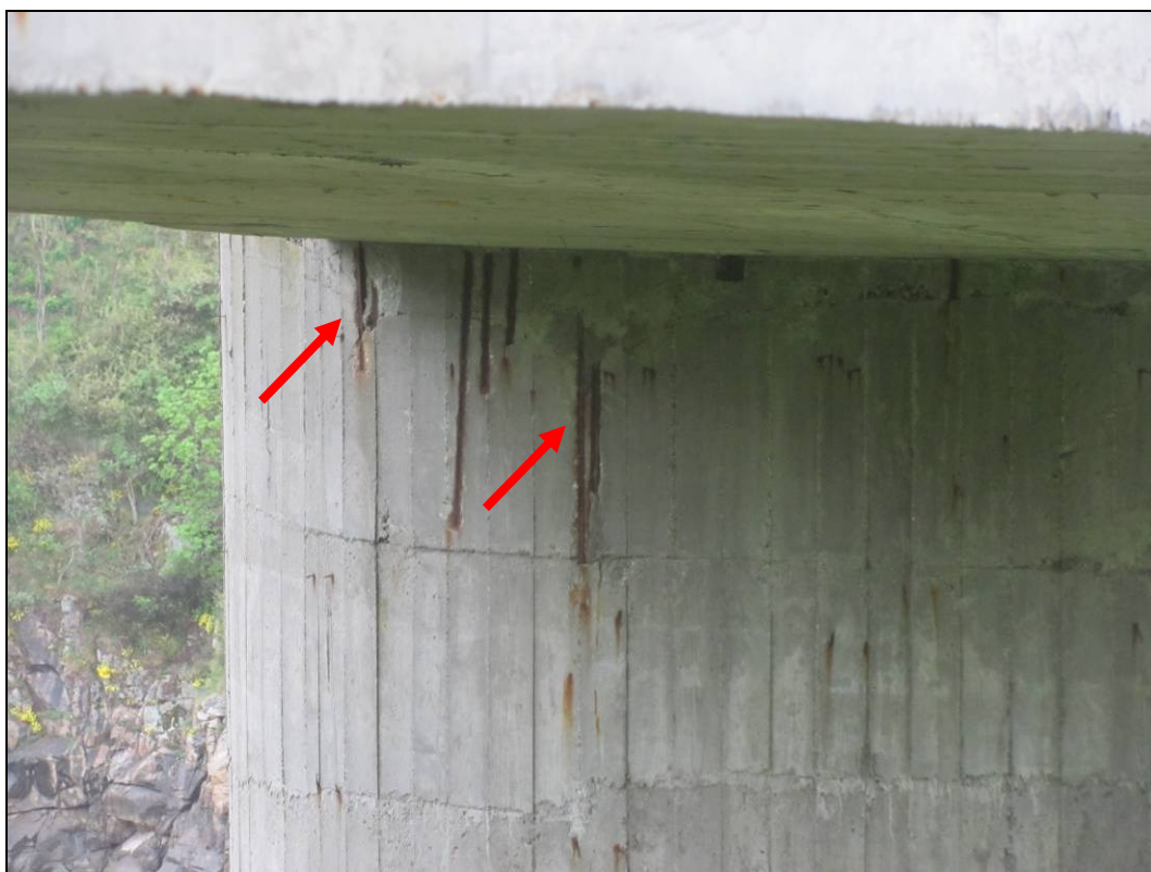
Foto 12: Povrchová až silná koroze odhalené výztuže v horní části pílře.
