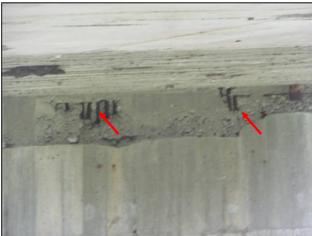
Foto 28: Hlava pilíře P4, detail výraznější koroze odhalené výztuže.
