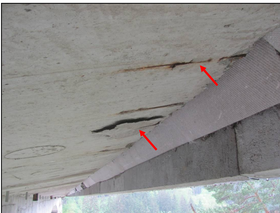
Foto 32: Na spodním líci konzoly dochází k odpadávání betonové krycí vrstvy vlivem koroze výztuže.
