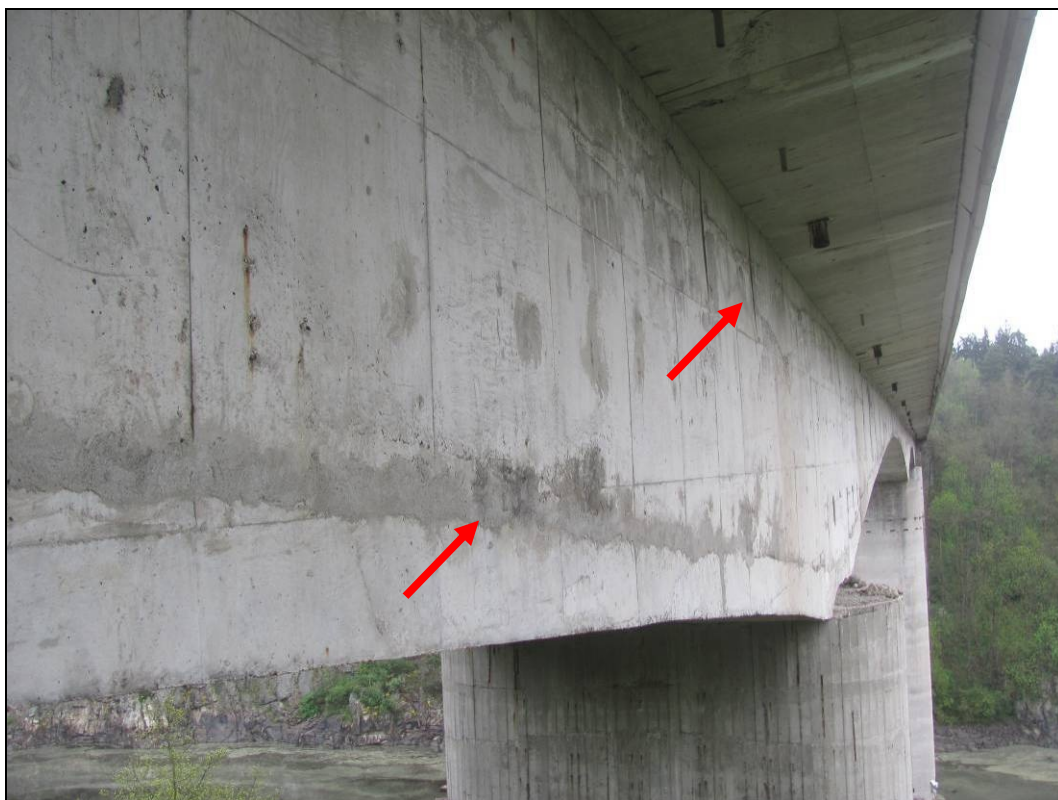
Foto 7: Pohled na bok komory v poli 1. Návodní strana. Viditelné pracovní spáry a lokální koroze odhalené výztuže.
