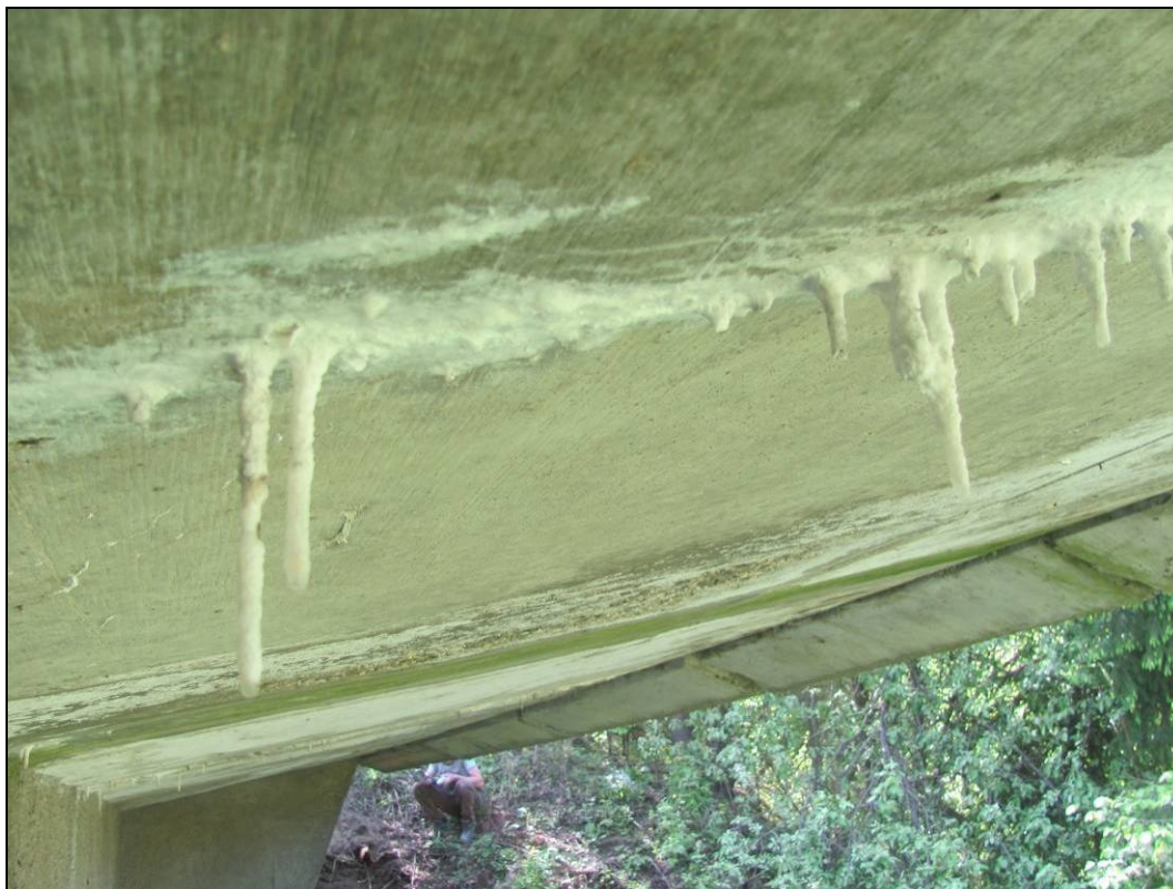
Foto 5: Na spodním líci konzoly lokálně dochází k zatékání a k vápenatým výluhům pojiva v místech trhlin nebo pracovních spár. V době prohlídky neaktivní.
