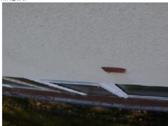
Obr. 2. Všechny atikové otvory jsou osazeny funkční mřížkou
