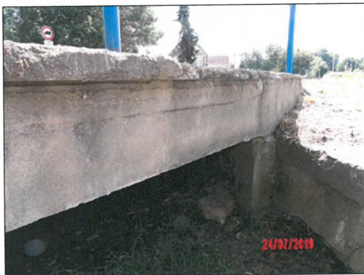
rozpad vnější hrany levé římsoy.JPG
