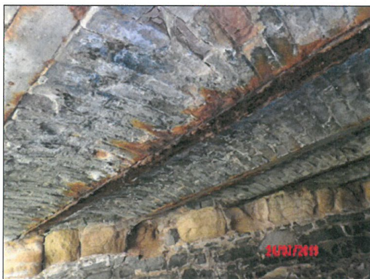
rozpad cihlového podhledu NK.JPG
