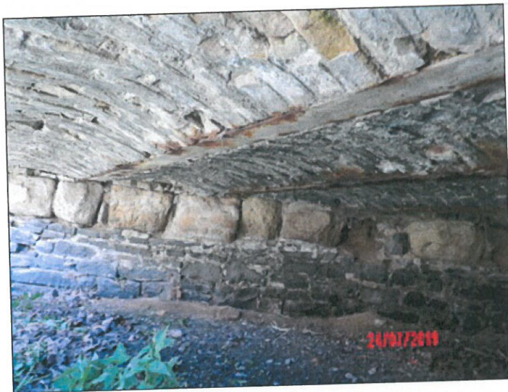
eroze kvádrů ÚP vlevo na OP2.JPG
