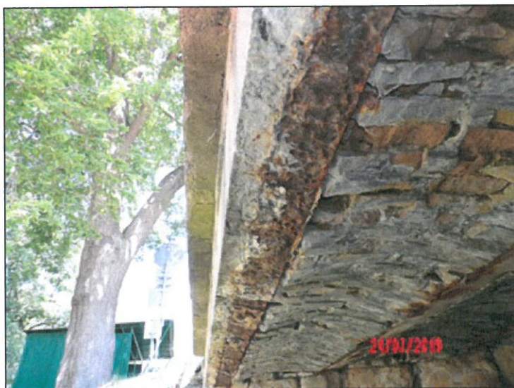
lístková koroze krejního nosníku vlevo.JPG
