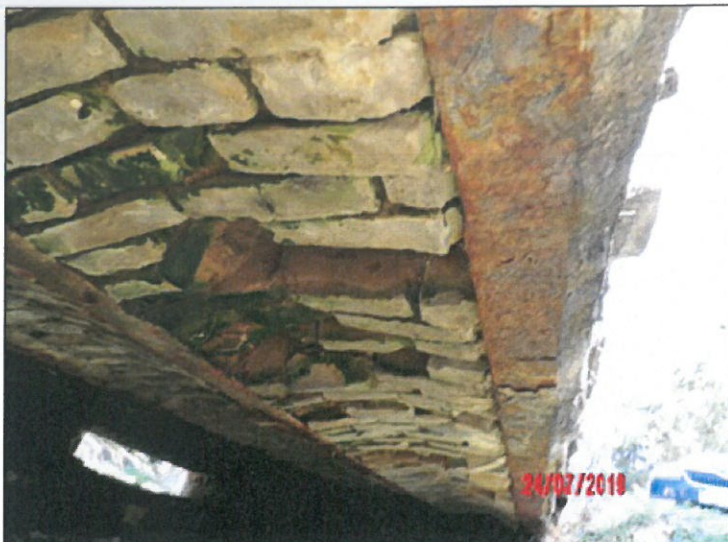
uvolněné cihlové zdivo podhledu NK v pravém kraji.JPG
