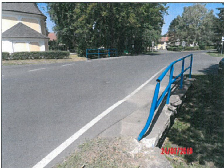
vyvrácený sloupek vpravo před OP1.JPG
