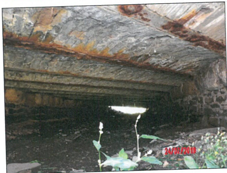
koroze nosníků NK.JPG
