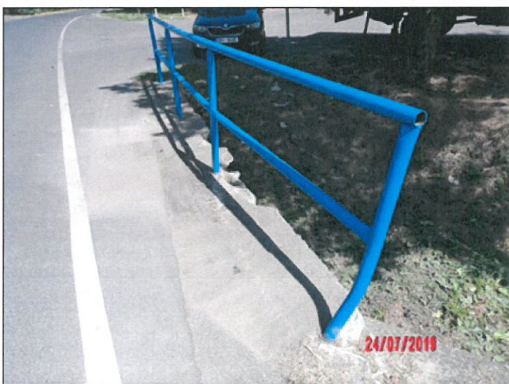
deformace zábradlí vpravo před OP1.JPG
