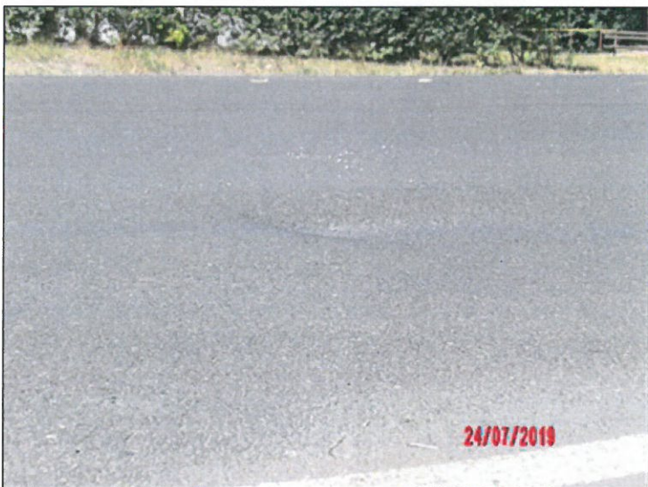
propad AB krytu cca 2.5m od pravého kraje mostu.JPG
