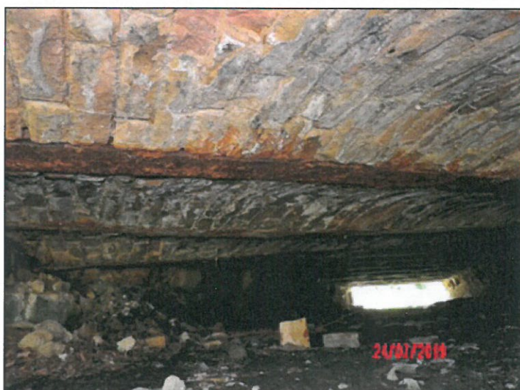
zřícené zdivo OP1 vpravo včetně NK s nosníky 15-19.JPG
