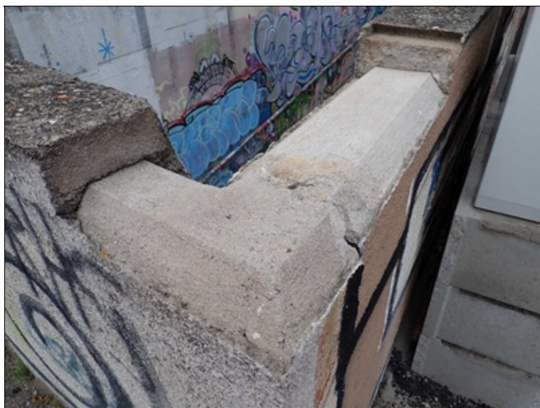
Zábradelní zídka - oddělené bloky v horní části.
