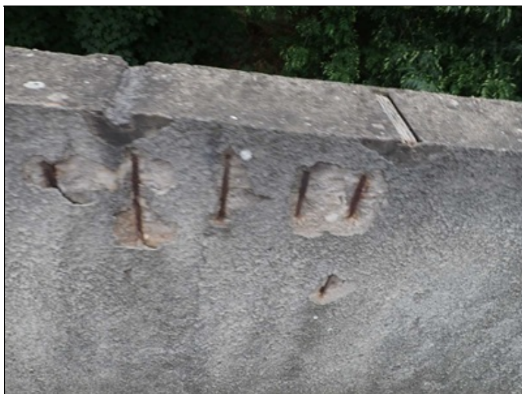
Zábradelní zídka - odhalená korodující výztuž.
