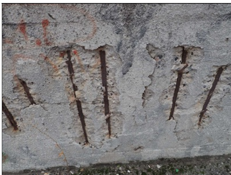
Zábradelní zídka - odhalená korodující výztuž.
