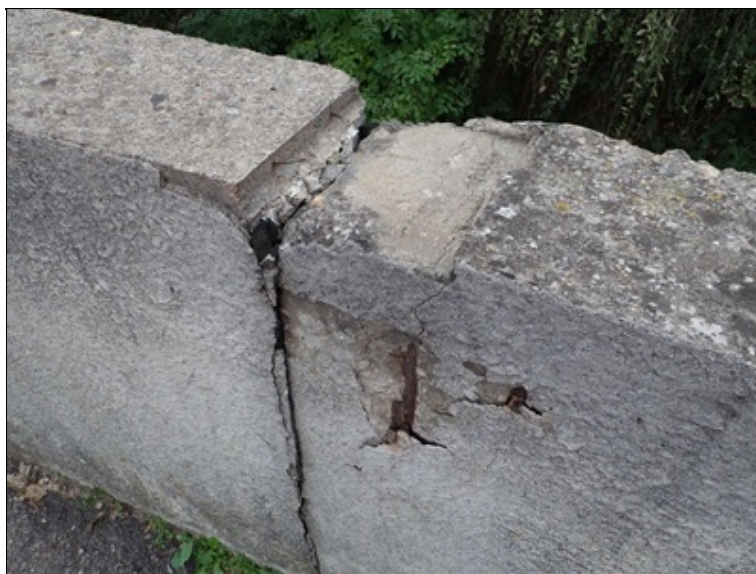
Zábradelní zídka - odhalená korodující výztuž. Zatékání nezatěsněnou dilatační sparou.
