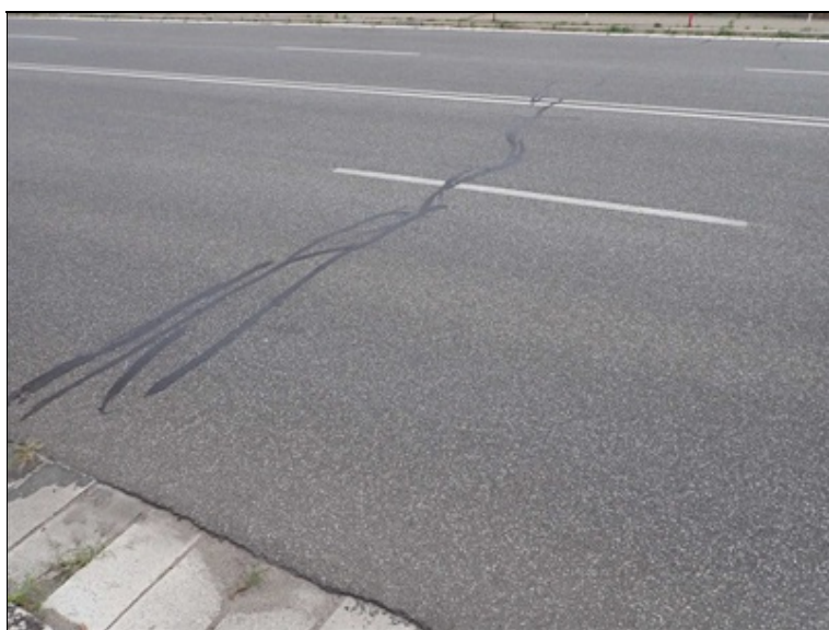
Zalité trhliny ve vozovce.
