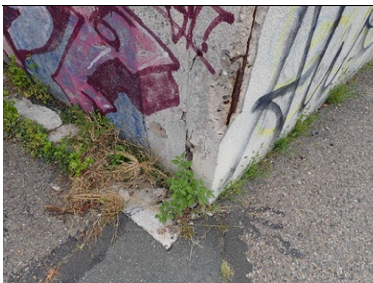
Zábradelní zídka - odhalená korodující výztuž.
