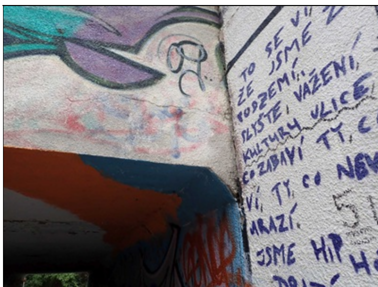
Trhlina mezi prefabrikátem NK a zábradelní zídkou.
