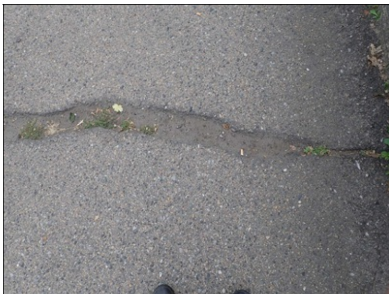
Široké trhliny v chodníku - dilatace.
