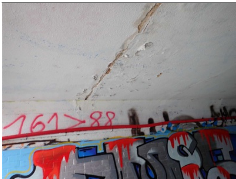
Lokálně zatékání mezi prefabrikáty.
