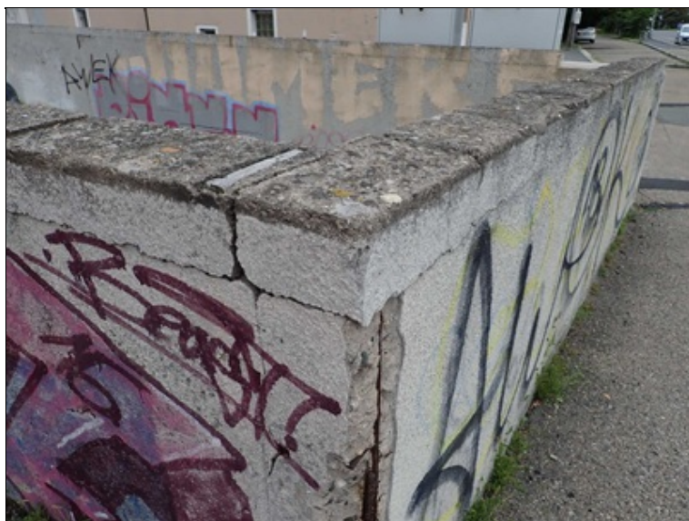
Zábradelní zídka - oddělené bloky v horní části.
