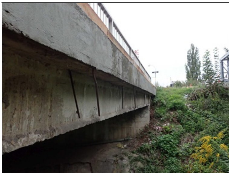
Bok NK - koroze kotvicích profilů.
