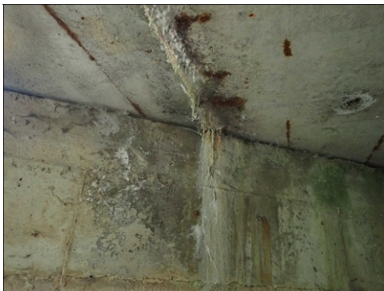
Zatékání na opěru spárou mezi nosníky.
