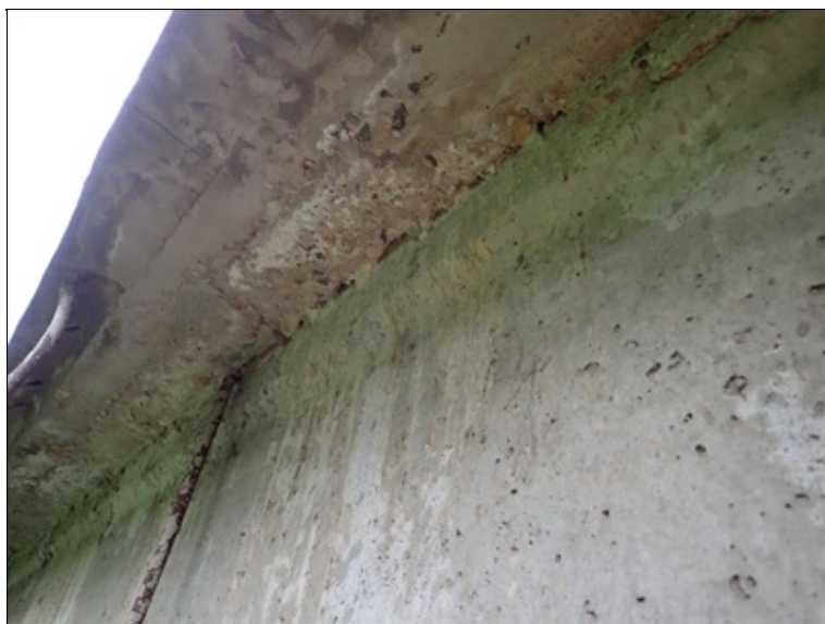
Zatékání zpod římsy.
