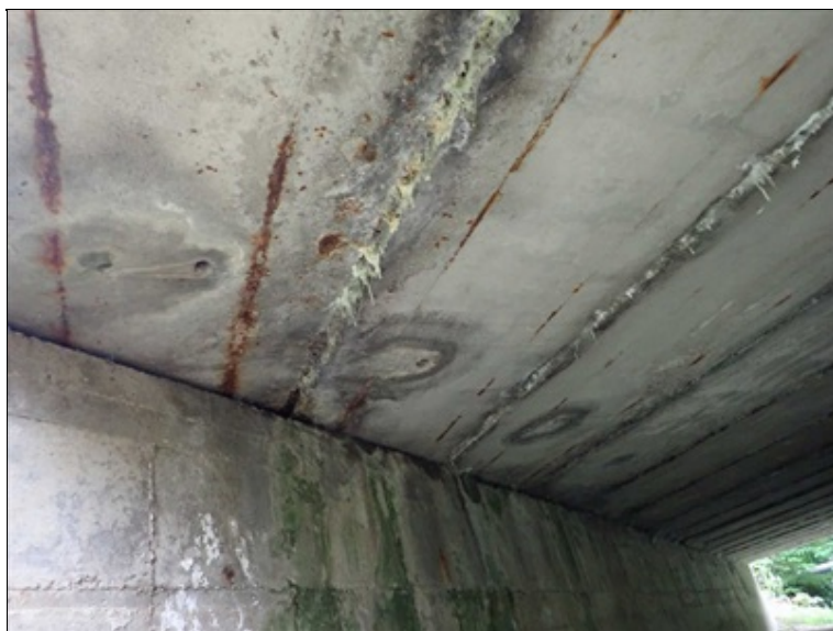
Zatékání mezi nosníky.
