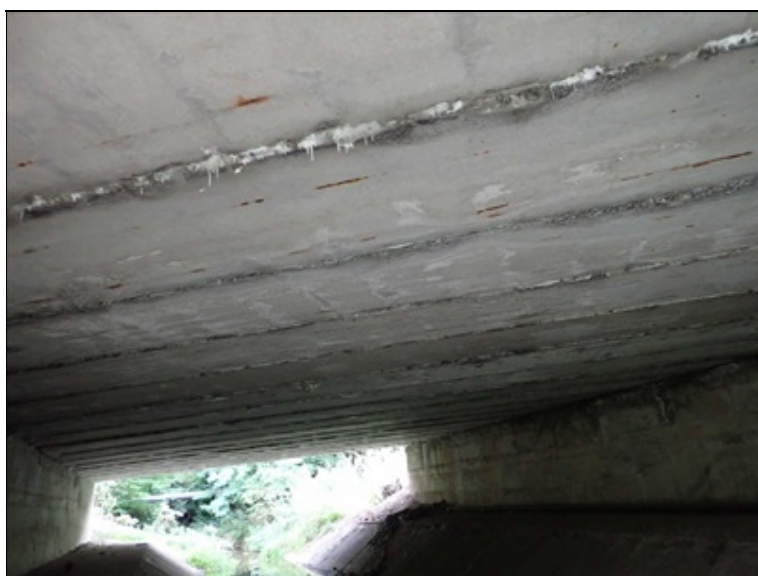
Zatékání ve sparách mezi krajními nosníky.
