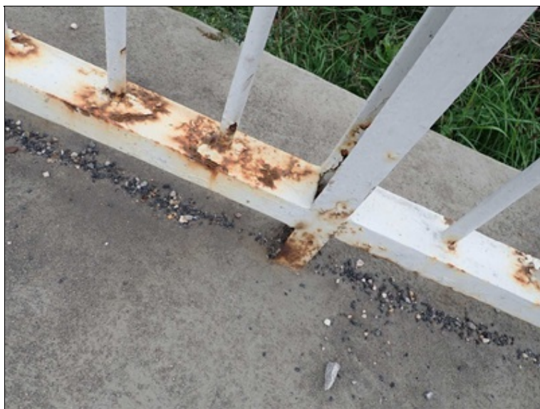
Lokální koroze zábradlí.
