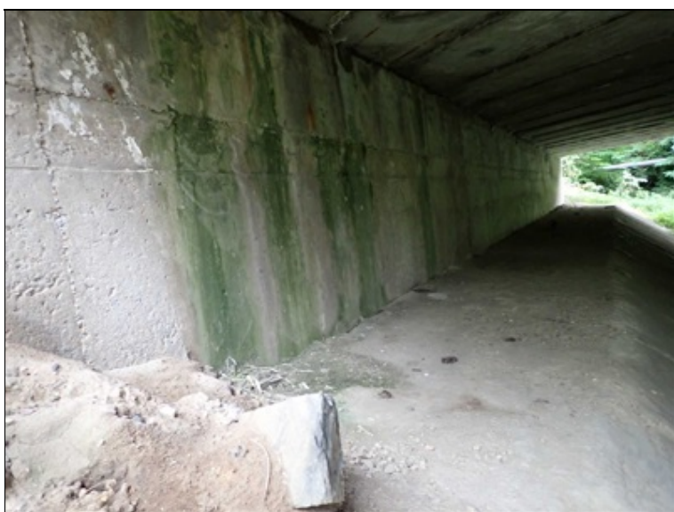
Zatékání na opěry, biologické napadení.
