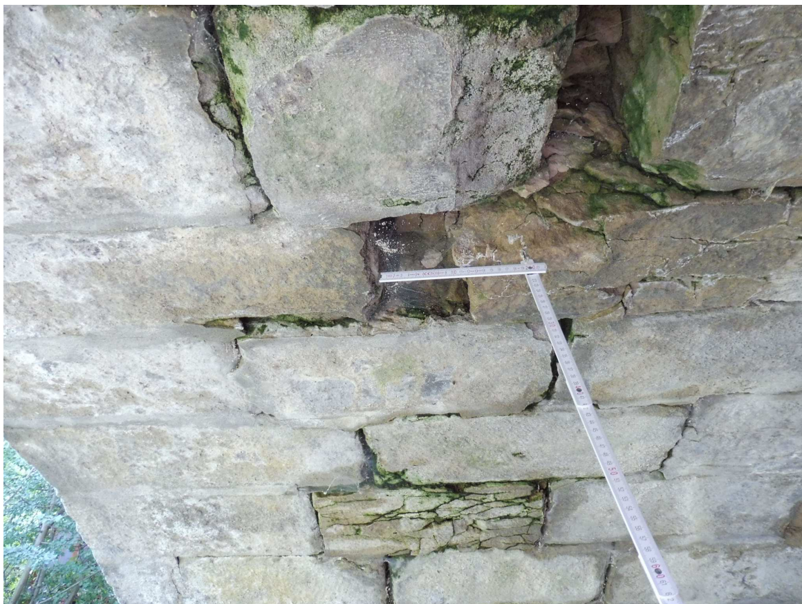
Levý kraj nosné konstrukce, rozpad bloků.
