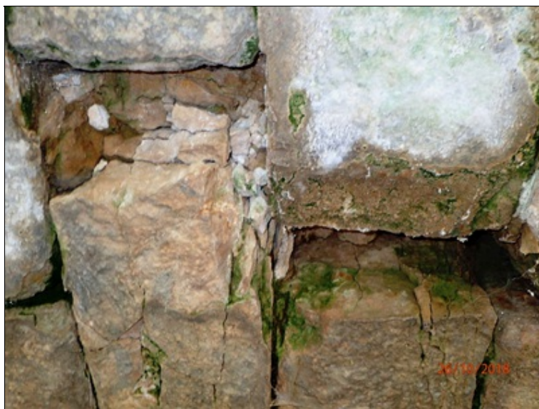
Detail z výše uvedené foto, lokální mrazová destrukce kamenných bloků u 1. linie trhlin.
