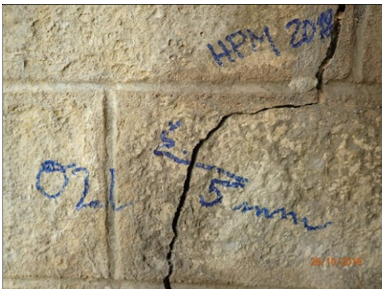
Detail zalomené trhliny z výše uvedené foto, opěra O2 u levého boku mostu.
