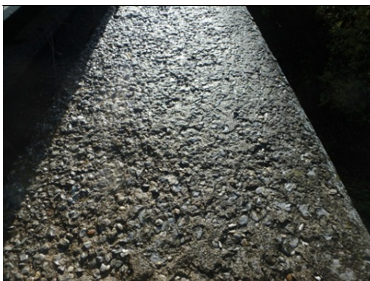
Degradace povrchu římsy.
