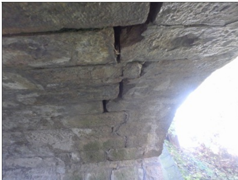
Trhlina u pravého boku mostu.
