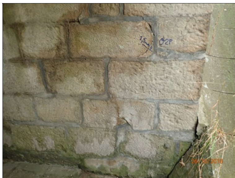
Opěra O2, u pravého boku mostu, 4. linie trhlín.
