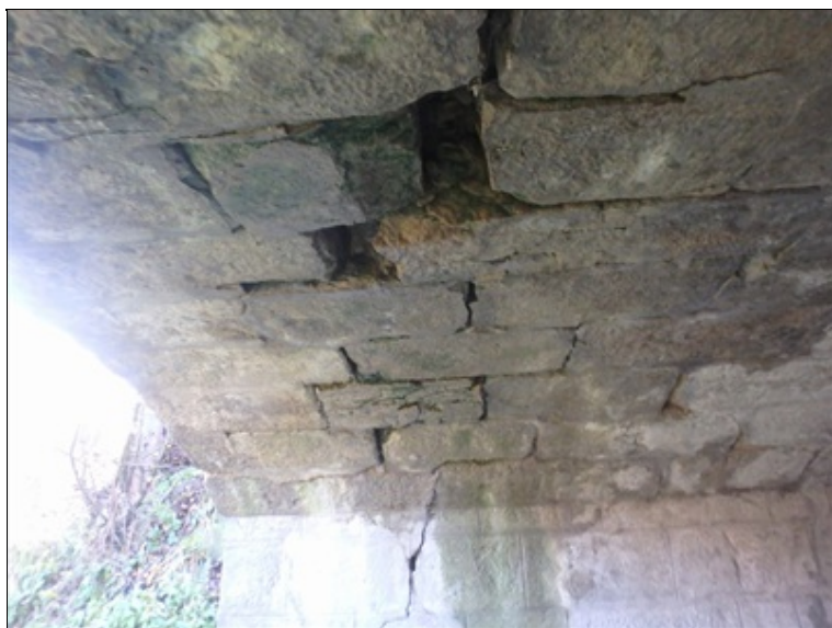
Trhlina u levého boku mostu.
