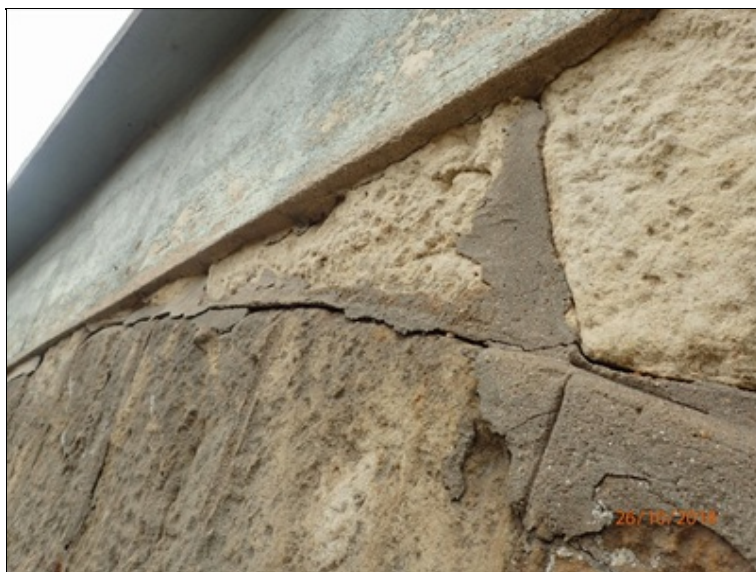
Levý portál, detail styku klenebního pásu a čelní zdi.
