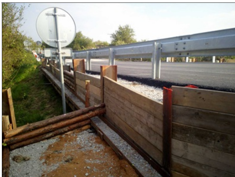
08 křídlo z I profilů a výdřevy z fošen na výtkové straně.jpg
