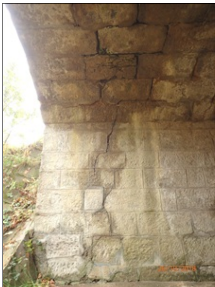
Opěra O2, u levého boku mostu, 1. linie trhlin.
