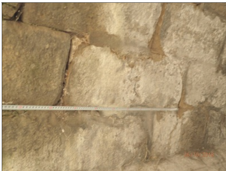
Podhled klenebního pasu před opěrou O2, měření polohy 2. linie trhlin od levého boku mostu.
