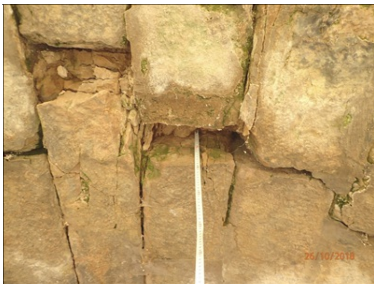
Stejná porucha jako na výše uvedené foto, měření hloubky rozpadu pískovcových bloků (= 20 cm).
