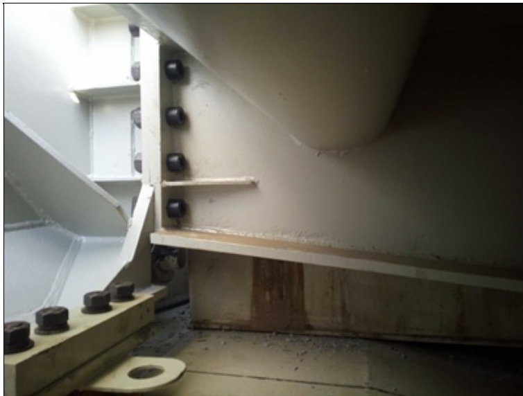
10 detail připoje krajního příčnicku na pravém břehu.jpg
