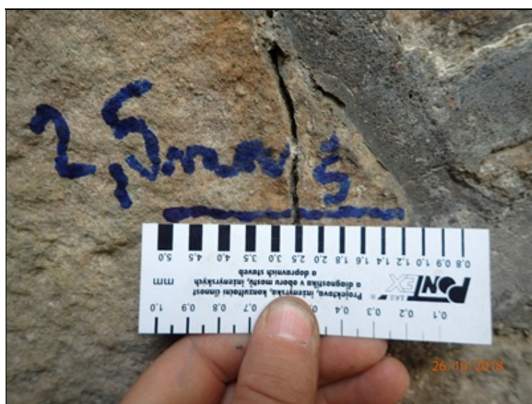
Detail zalomené trhliny z výše uvedené foto, opěra O2 u pravého boku mostu.
