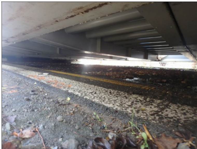
Nečistoty uchycené mezi provizoriem a vozovkou.
