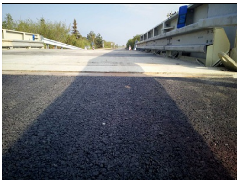
09 drobná nerovnost na levobřežním úložném prahu.jpg
