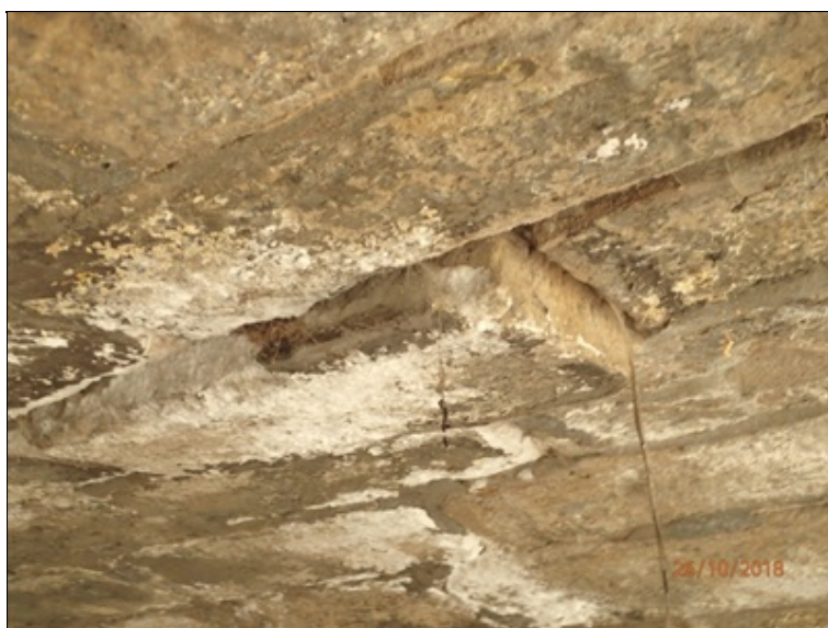
Vrchol nosné konstrukce, vnitřní úsek, 1x výrazně pokleslý blok.
