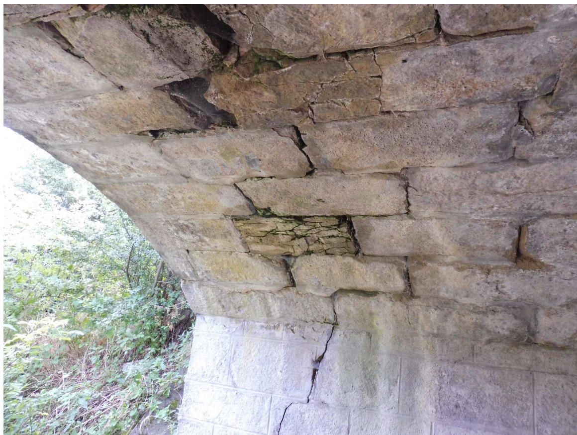
Levý kraj nosné konstrukce, rozpad bloků.
