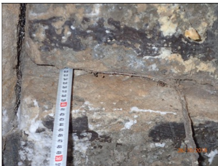
Detail z výše uvedené foto, měření hloubky volné spáry podél vysunutého bloku (=42 cm).
