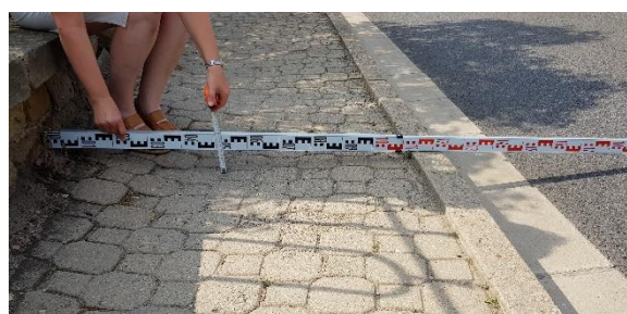
Obr. 02 – Místo propadu chodníku 80 mm
