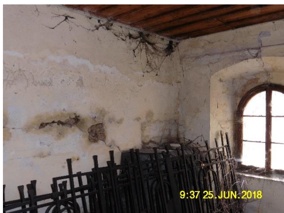
Obr. 30 – Zeď zákristie na straně ke komunikaci – Průsaky vody, vodorovná trhлина v cca polovině výšky zdi, trhлина prochází po celé délce zdi
