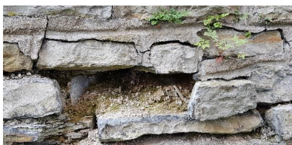
Obr. 12 – Vypadlý kámen ze zdiva opěrné zdi – je vidět část kamene zdiva uvnitř kaverny
