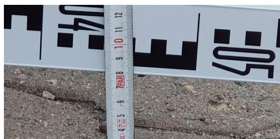
Obr. 03 – Místo propadu chodníku – 80 mm
