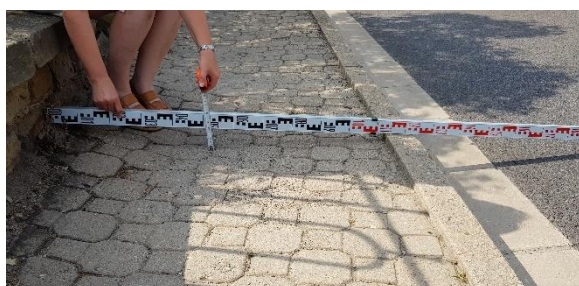
Obr. 04 - Místo propadu chodníku – 60 mm
