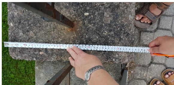
Obr. 06 - Šířka římsy cca 450 mm
