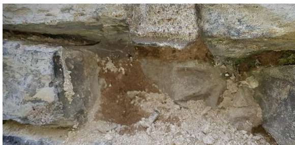
Obr. 14 – Po vypadlém kameni zdiva je vidět skladba zdiva
