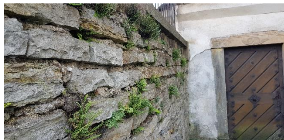
Obr. 21 - Po vypadlých kamenech a v místech rozpadlé malty se uchycuje vegetace, na opěrnou zeď navazuje přístavek od kostela sv. Jana Nepomuckého
