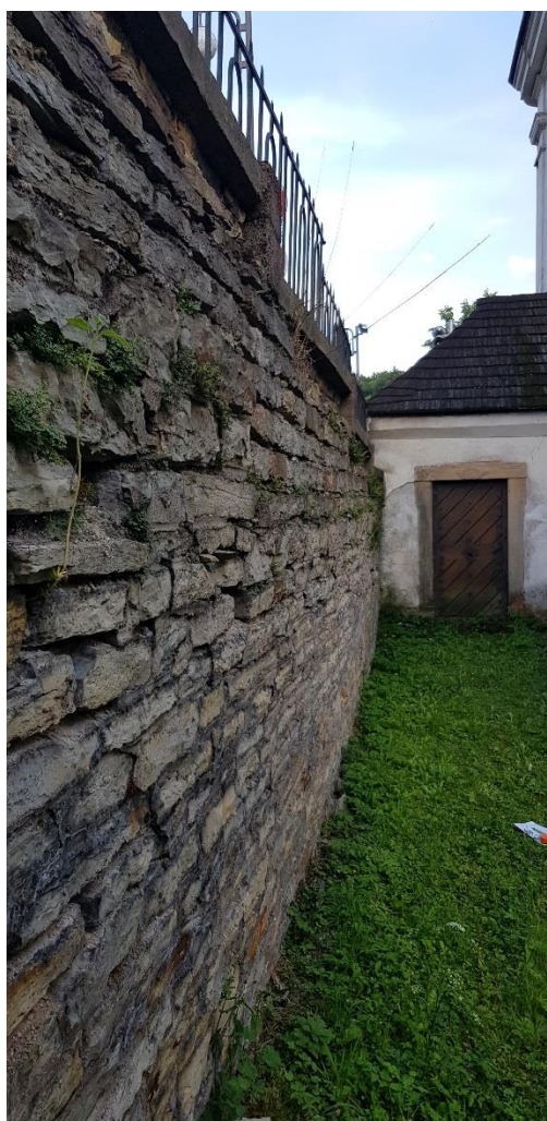
Obr. 16 – Vyboulení opěrné zdi po výšce
