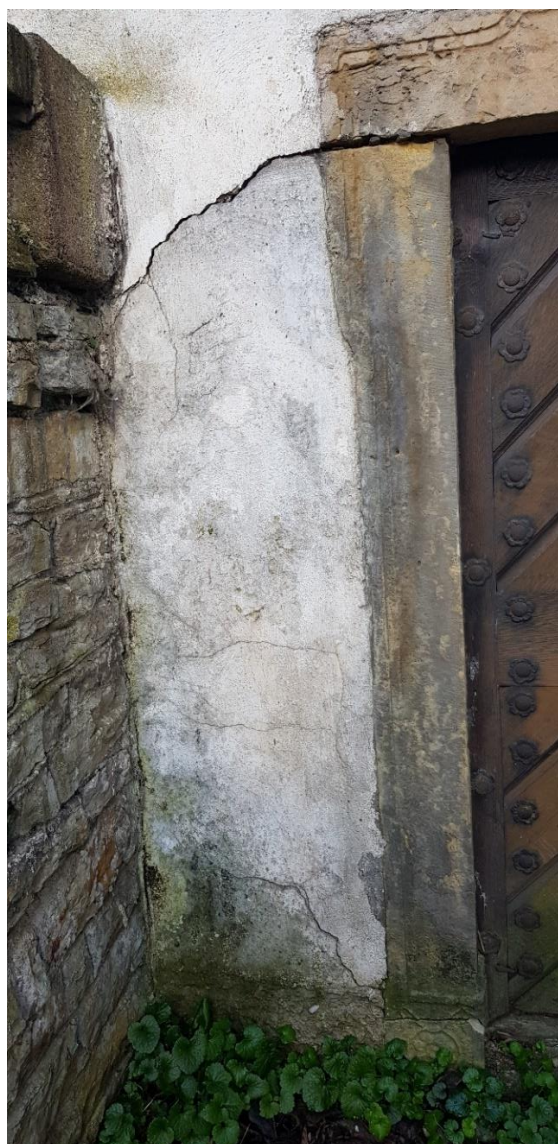
Obr. 24 – Stěna zákristie kolmá na opěrnou zeď – trhlina v místě uložení překladu na kamenné ostění – trhlina zasahuje až k opěrné zdi
