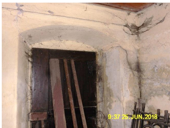
Obr. 28 – Pohled vstupní dveře zákristie – Venkovní trhlina z obr. 24 opsaná na vnitřní stranu
