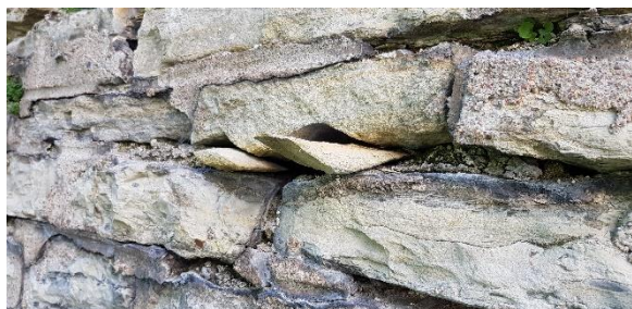
Obr. 22 – Rozpadající se opukové zdivo
