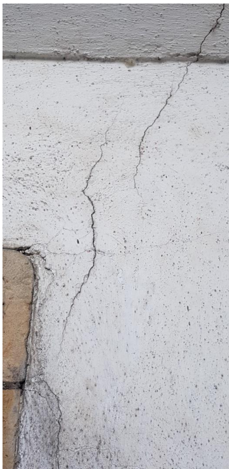
Obr. 26 – Trhlina na druhé straně dveří
