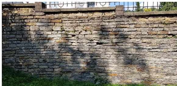
Obr. 10 – Detailnější pohled na opěrnou zeď v místě její nejvyšší výšky (cca 2,7 m) – V horní polovině výšky zdi je vidět rozpadající se malta
