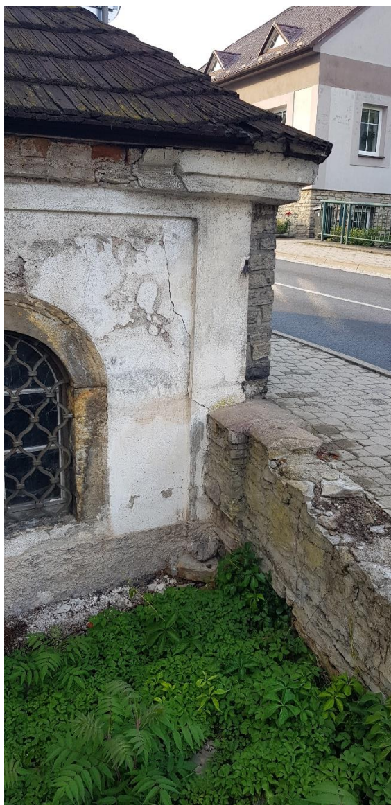
Obr. 34 – Pohled na trhlinu probíhající po celé zdi zákristie
