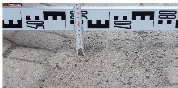
Obr. 05 – Dttto obr. 04 - Místo propadu chodníku – 60 mm
