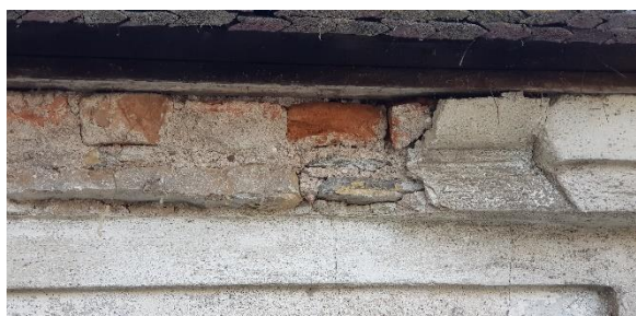
Obr. 36 – Trhлина zasahuje až do římsy
