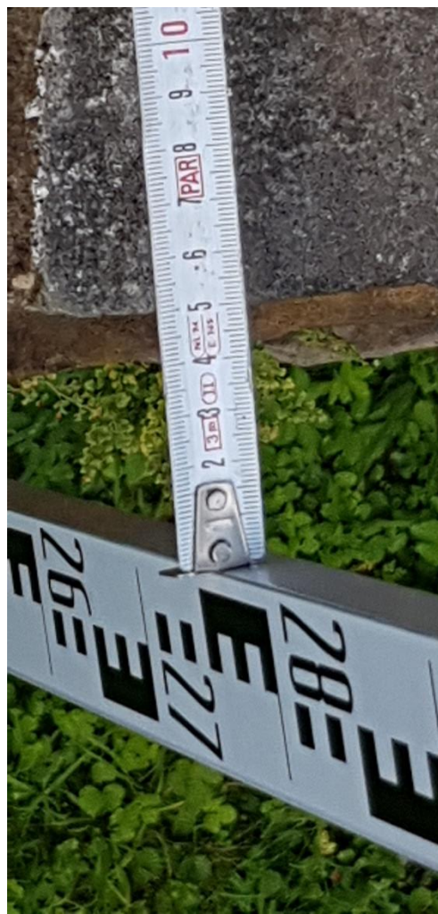
Obr. 17 – Dtto obr. 16, 18 a 19 – vyboulení zdi činní cca 50 mm oproti kraji římsy
