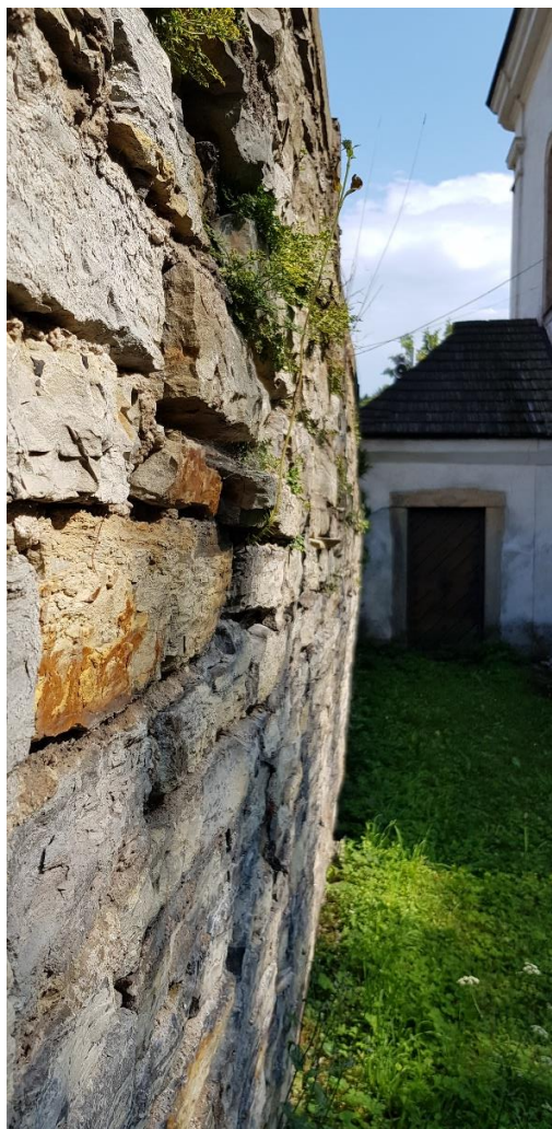
Obr. 18 – Boulení opěrné zdi v cca polovině výšky – v horní polovině porušena malta, v uvolněných spárách se uchycuje vegetace
