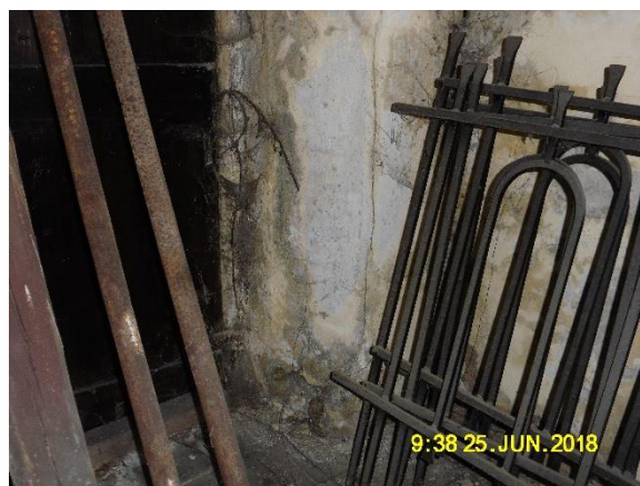
Obr. 29 – Dtto 28 – Trhlina pokračuje až k podlaze
