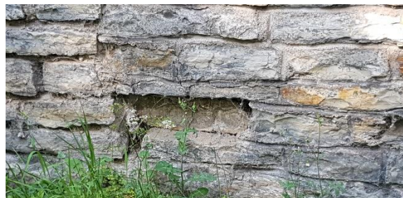
Obr. 11 – Vypadlý kámen těsně nad patou zdi
