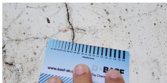
Obr. 27 – Dtto obr. 26– šířka trhliny
