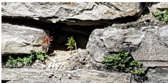
Obr. 20 – Po vypadlých kamenech a v místech rozpadlé malty se uchycuje vegetace
