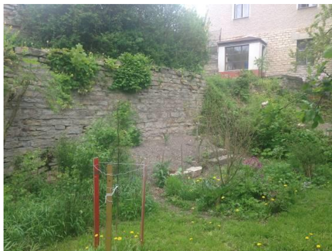
Vybočená horní opěrná stěna
